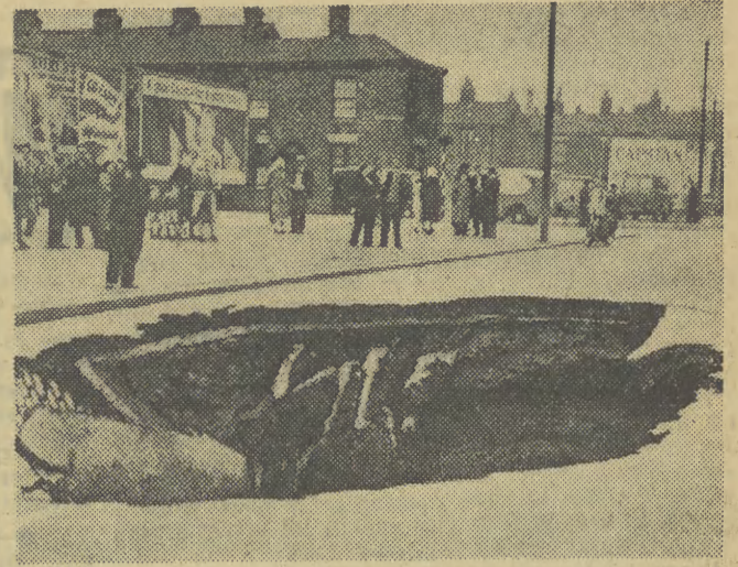
Tak zapadła się nieoczekiwanie jezdnia na jednej z ulic Manchesteru (Anglia). Głęboka na przeszło trzy metry wyrwa powstała na skutek uszkodzenia kanału. (db)
