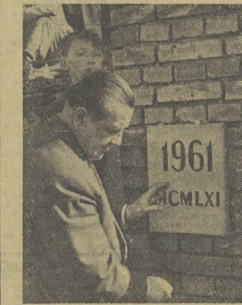
Przewodniczący Prezydium Rady Narodowej m. Krakowa mgr Zbigniew Skolicki wmurował kamień węgielny pod nowa Szkołę Tysiąclecia w Prokocimiu. Będzie to Technikum Przemysłu Elektrotechnicznego budowane przez Krakowską Fabrykę Kabli. (eo)
