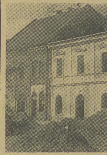
Gdy do akcji przystąpili krakowscy naukowcy z AGH — dom został uratowany. Jego odbudowa dobiega już końca.
