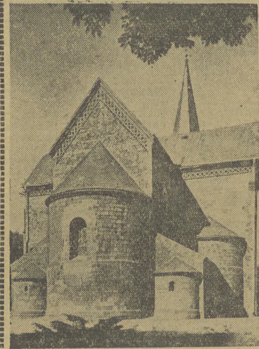
Sławna romańska kruszwicka kolegiata, w której wnętrzu się obecnie przebudowuje i prace renowacyjne.
