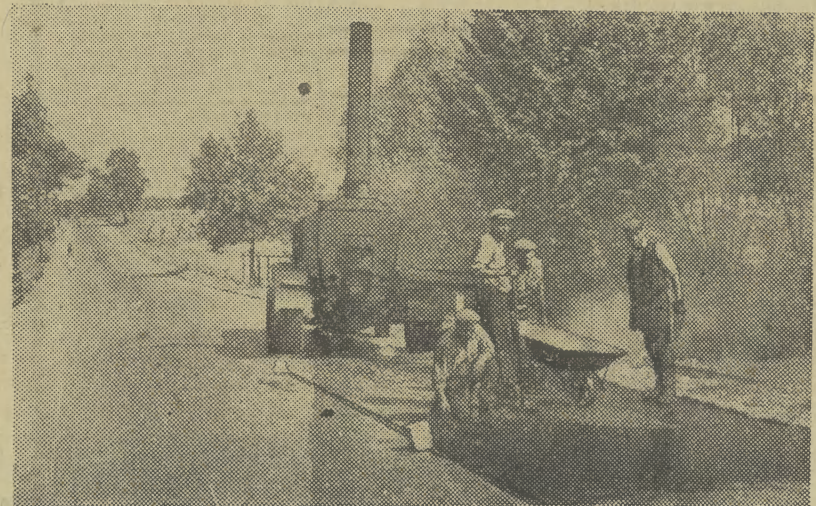
Również stare odcinki tej szosy podlegają stałej konserwacji. Koszt położenia takiej warstewki asfaltowej wynosi na kilometr — pół miliona złotych. (Do art. powyżej — fot. autora.)
