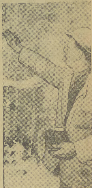
„Ładowanie ściany“ przed odstrzałem.
