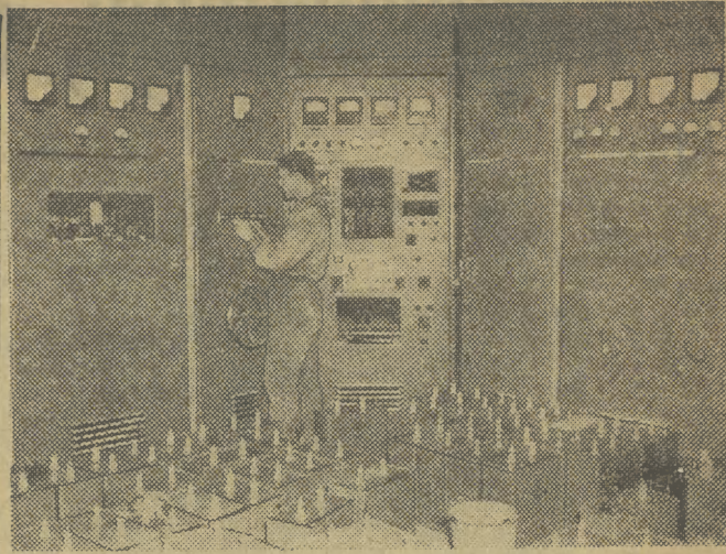
W KRAKOWSKIM INSTYTUCIE BADAŃ JĄDROWYCH Jeszcze w bieżącym roku spodziewać się należy przeprowadzenia pierwszych doświadczeń w Ośrodku Badań Jądrowych w Bronowicach pod Krakowem. Bieżące prace koncentrują się wokół wykończenia urządzeń cyklotronu. Na zdjęciu: Generator wysokiej częstotliwości do zasilania komory akceleracyjnej. Fot. — J. Lewicki
