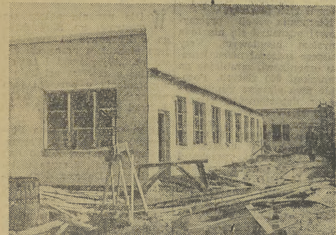
Zdjęcie nowej hali obróbki mechanicznej wybudowanej na Zabłociu, stanowi z poprzednim pomieszczeniem ogromny kontrast.
