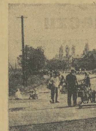
Miejskie Przedsiębiorstwo Robót Drogowych kończy prace przy pięknej arterii w ul. Długiej. W chwili obecnej na ukończeniu jest szereg ulic asfaltowych w obrębie miasta.
