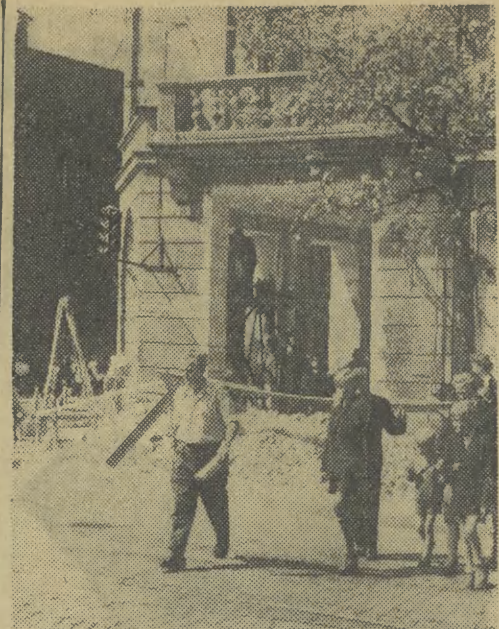
Przy rogu ul. Karmelickiej i 1-go Maja — trwają obecnie prace przy budowie arkadowego przejścia.
