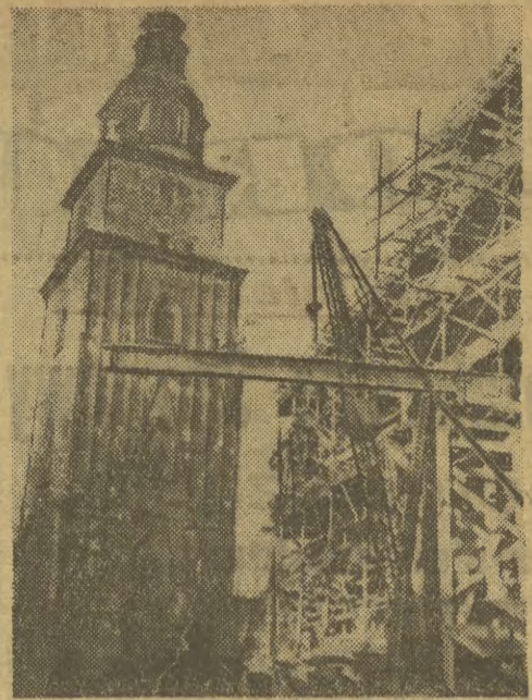
Ostatnio remont Sukiennic nabral tempa, które jak na krakowskie stosunki wydaje się zawrotne. Mechanizacja w postaci dźwigu windującego potężne prefabrykowane elementy budzi wśród krakowian ogromne zainteresowanie.
