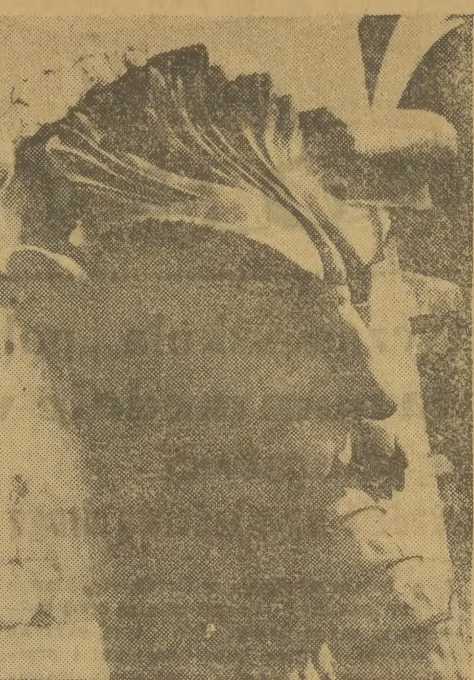
W naszym kąciku „Nieznany Kraków“ pokazaliśmy już wyloty rylnien. Powyższa zaś fotografia przedstawia wyloty rylnien atykowego dachu Sukiennic.
