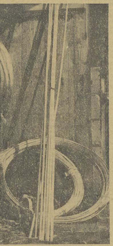
Chłopi, tak starzy jak i młodzi chętnie pomagają w pracy przybyłym elektrykom, a idzie ona rażno, gdy się ją pokonuje zbiorowym wysiłkiem, który krzepi myśl, że już nie długo zabłyśnie we wsi światło. Chłopi kopią więc doły, wbijają słupy, oczywiście pod okiem fachowców z ekipy, ci ostatni mają pełne ręce roboty instalując na słupach przewody.
