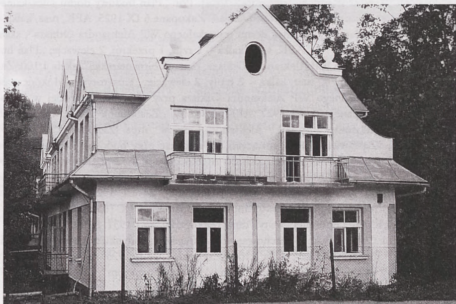
61. Budynek Sądu Grodzkiego w Zakopanem przy ul. Nowotarskiej (1925–1927)
