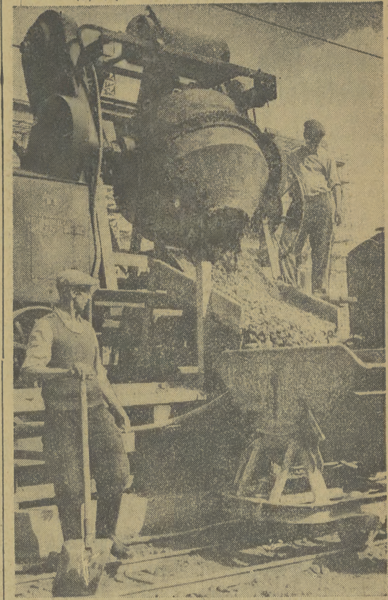
Polężna betoniarzka na MDM przy pracy. (Fot. Groszowicz)
