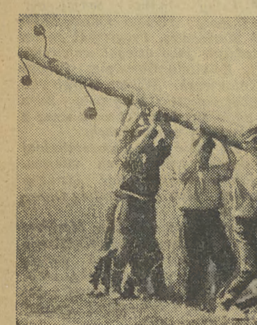
Grupa robotników przy ustawianiu słupa linii wysokiego napięcia.
