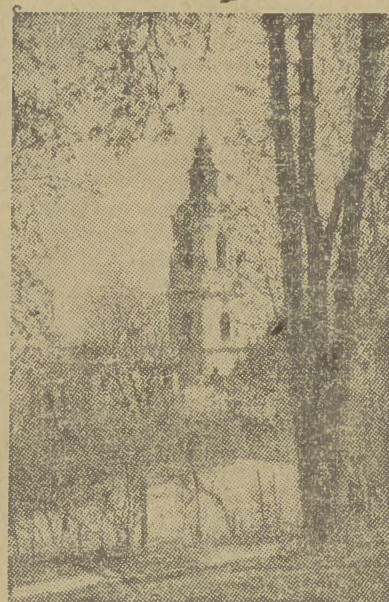
Widok z góry Zamkowej na wieżę katedralną Fot. J. Fischer
