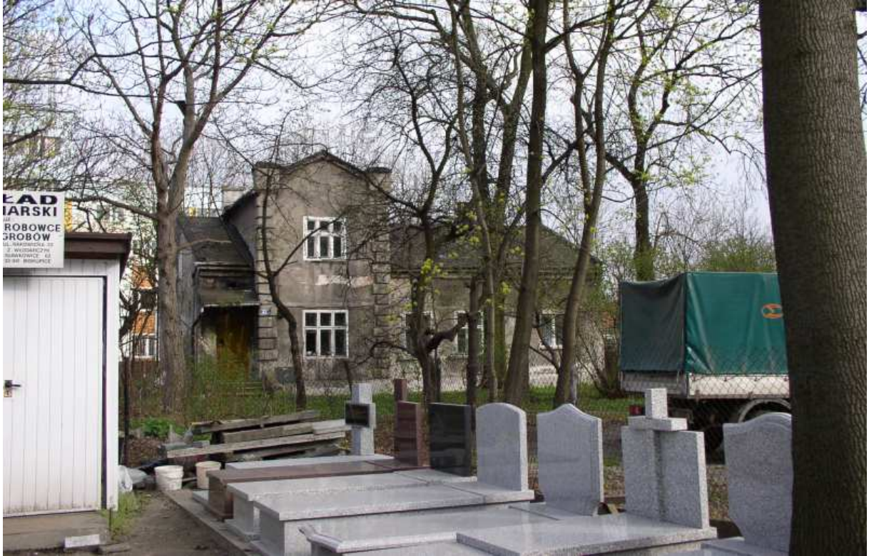
Fot. nr 140 (140-141). Dla porównania stan willi z dnia 12.04.2009. Ta bliska oryginałowi dom powstał ok. 1890 roku wg projektu Franciszka Bujasa.
