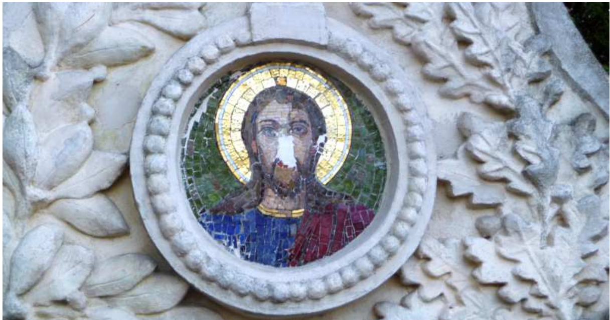
Fot. nr 13. Uszkodzona przez wandalę mozaika. (01.11.13)
