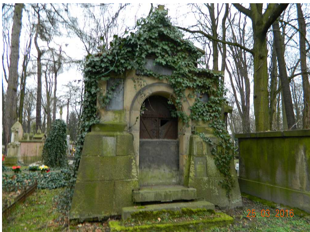
Fot. nr 153. Zanedbany, ale pełen cmentarnego uroku grobowiec Szczepanowskich (?).
