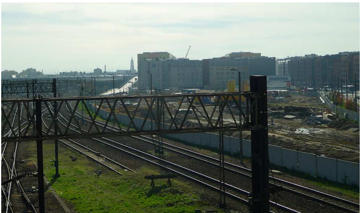
Fot. nr 214. Widok z wiaduktu nad ulicą Warszawską w stronę zabudowań ulicy Pawiej. (18.10.2018)
