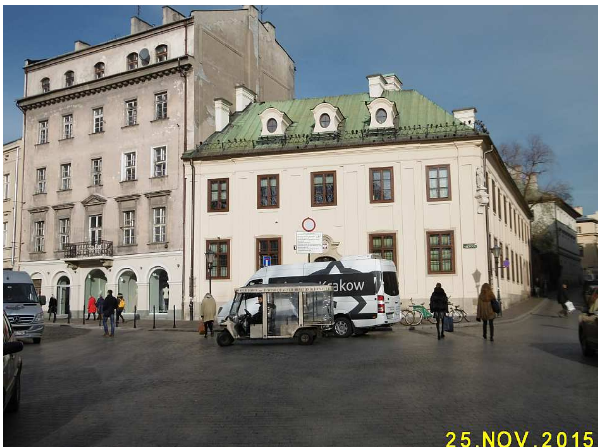
Fot. nr 60. Narożnik z ulicą św. Krzyża. (25.11.2017)
