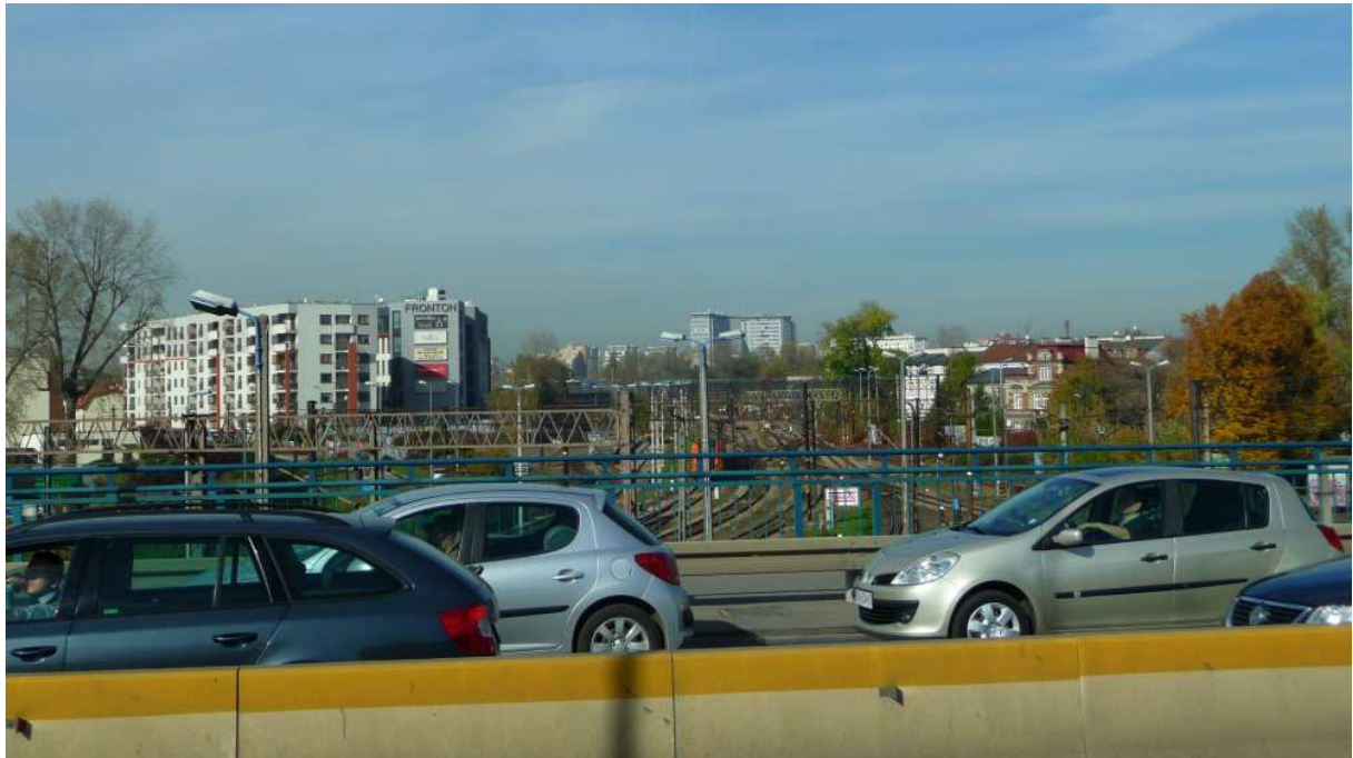
Fot. nr 217. Widok z wiaduktu nad ulicą Warszawską w stronę Krowodrzy Murowanej (z prawej) i nowej zabudowy przy pętli przy dworcu towarowym. (18.10.2018)
