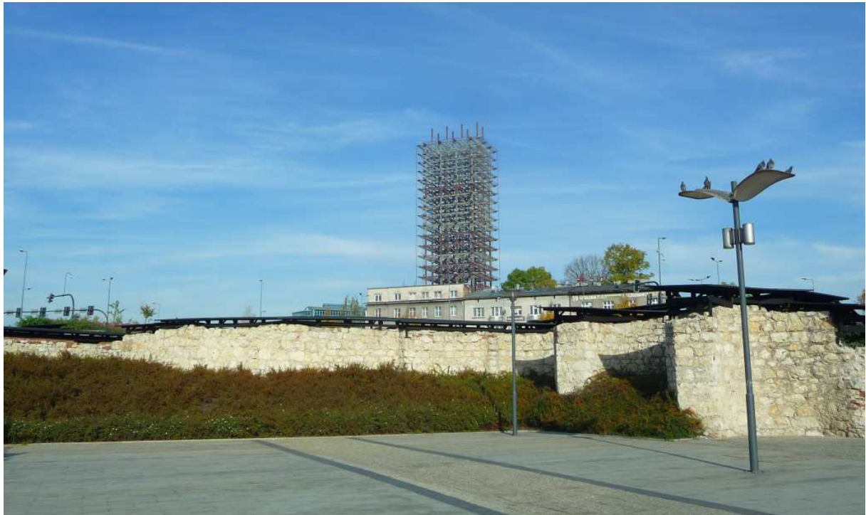
Fot. nr 219 (219-221). Różne ujęcia szkieletora z Ronda Mogińskiego i jego sąsiedztwa. Jego ściany zostały wyburzone i pozostał autentyczny szkielet stalowy. Co tu powstanie? (18.10.2017)
