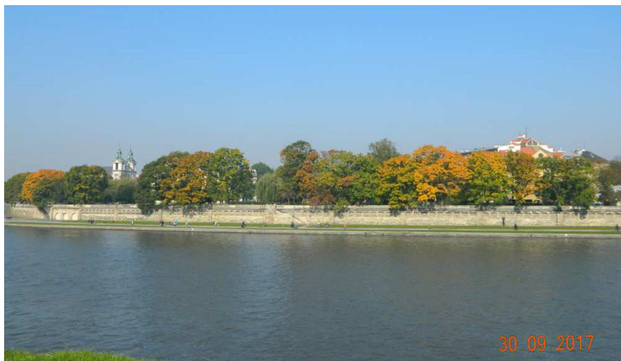
Fot. nr 68. Widok na Bulwar Inflancki na kazimierskim brzegu rzeki.
