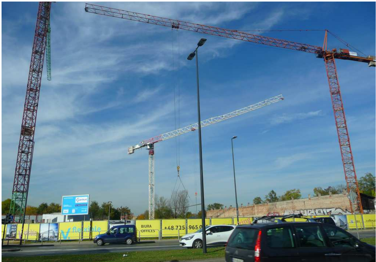
Fot. nr 218. Nowy plac budowy w sąsiedztwie ulicy Warszawskiej i w bliskości „lunety warszawskiej” (bastionu nr IV). (18.10.2018)
