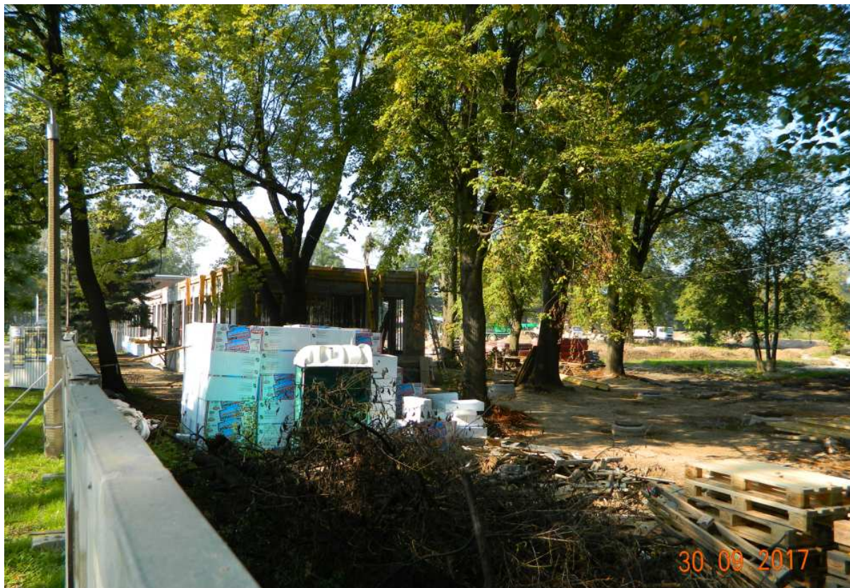
Fot. nr 171 (171-172). Po wyburzeniu dawnych szatni w jej miejscu powstaje nowy budynek, który swą sylwetką najwyraźniej ma nawiązywać do swego poprzednika.
