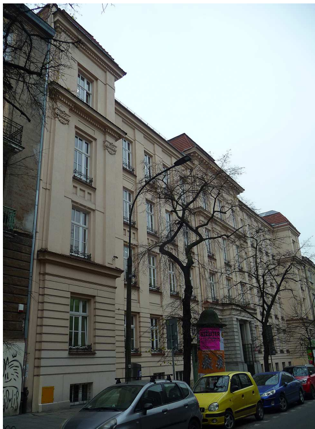
Fot. nr 91 (91-92). Budynek szkolny przy ulicy Szlak 9. (09.11.2017)
