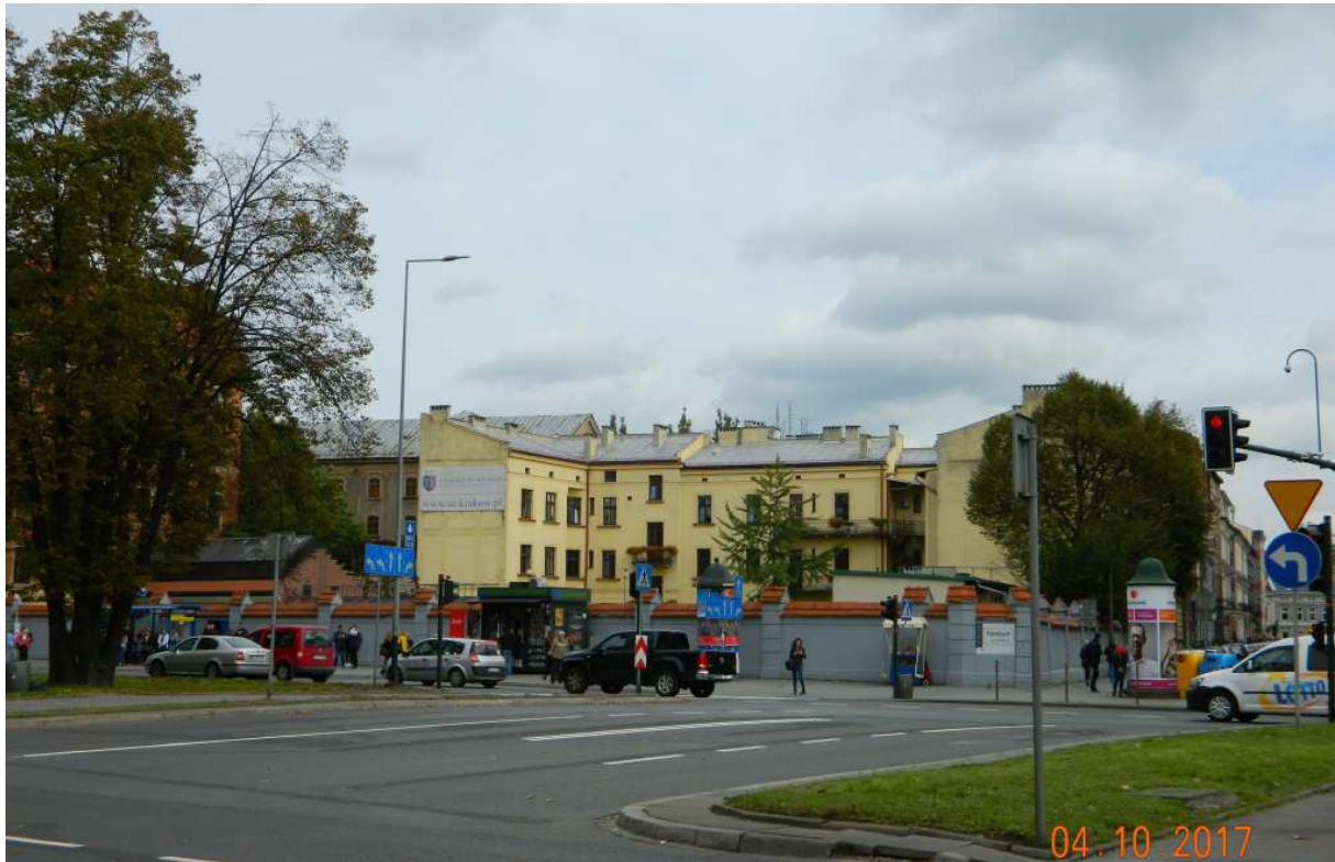
Fot. nr 123. Oficyna kamienicy z ulicy Czystej 21 w ujęciu z ulicy Reymonta.
