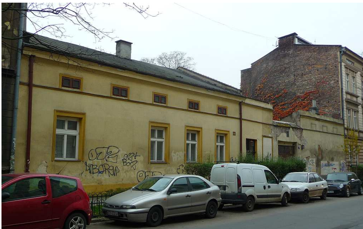
Fot. nr 90. Budynek dawnego przedszkola przy ulicy Krowoderskiej 38-40. (09.11.2017)
