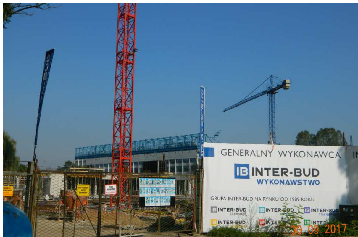
Fot. nr 166. Plac budowy ze stadionem Wisły w tle.
