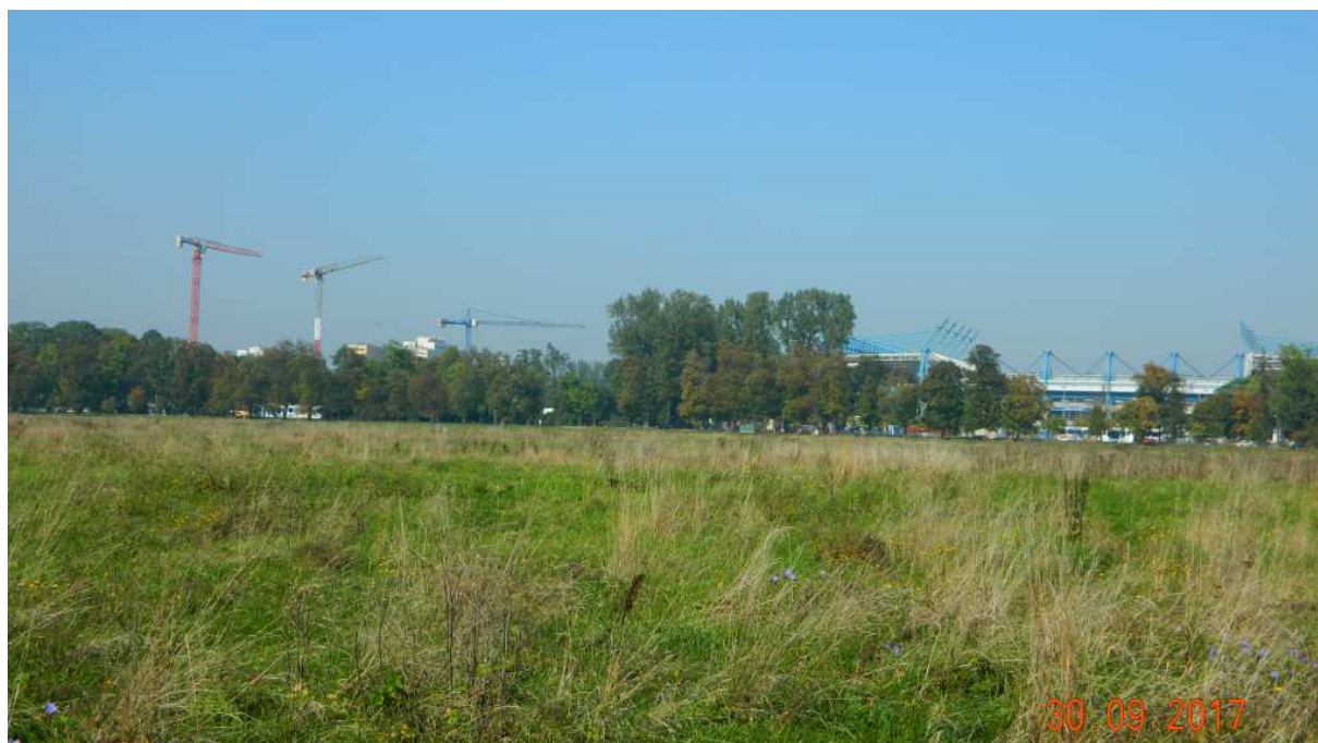
Fot. nr 180. W trzonie placu budowy blokowiska „Błonia Park”. Nikt mnie nie przekona, że powstanie tak wielkiego mrówkowca nie wywoła wzmożonego ruchu ulicznego i zanieczyszczenia spalinami w obrębie tych zielonych płuc Krakowa. Dodatkowo sama aleja 3-Maja zostanie zatkana parkującymi tam samochodami.
