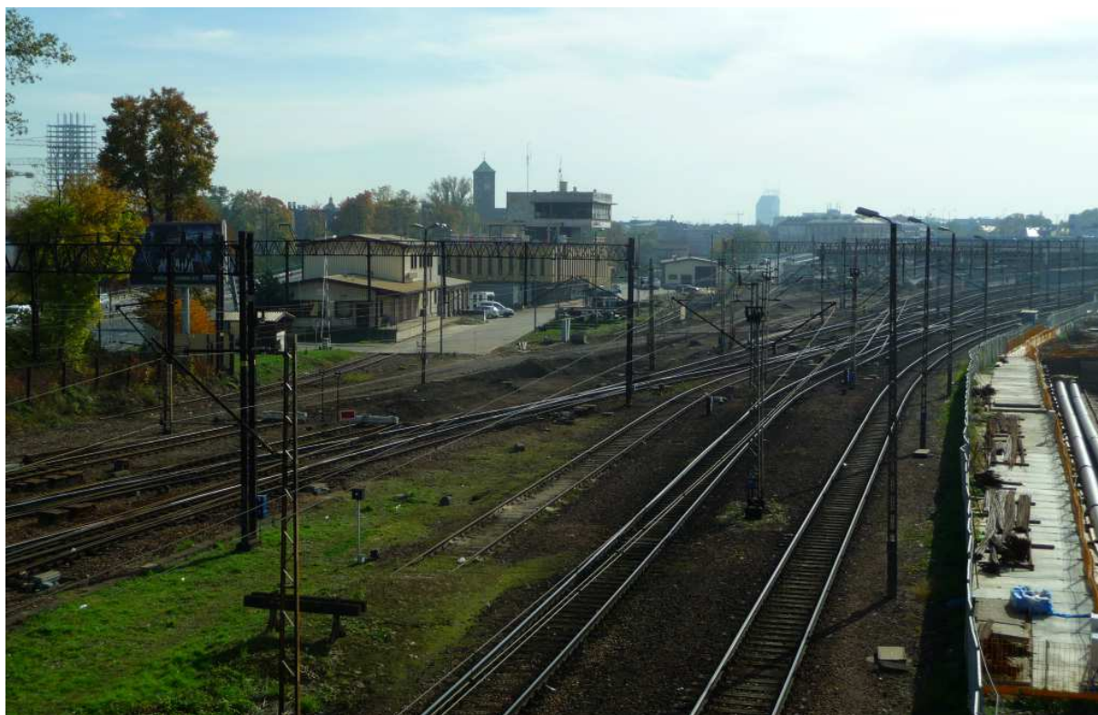
Fot. nr 232. W stronę Wesołej – widok z wiaduktu nad ulicą Warszawską. (18.10.2017)
