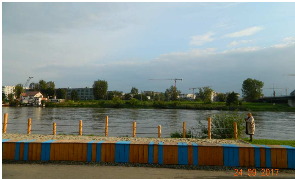
Fot. nr 251 (251-252). Trwa zabudowa Podgórze w rejonie ulicy Portowej.
