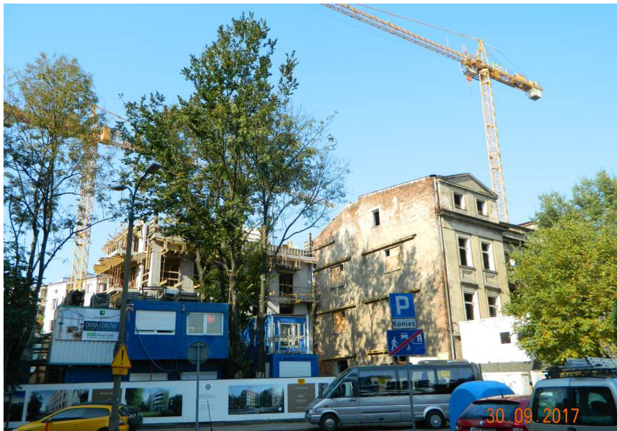
Fot. nr 135 (135-136). Dawna willa Medyńskich z placu Kossaka na etapie rozbudowy.
