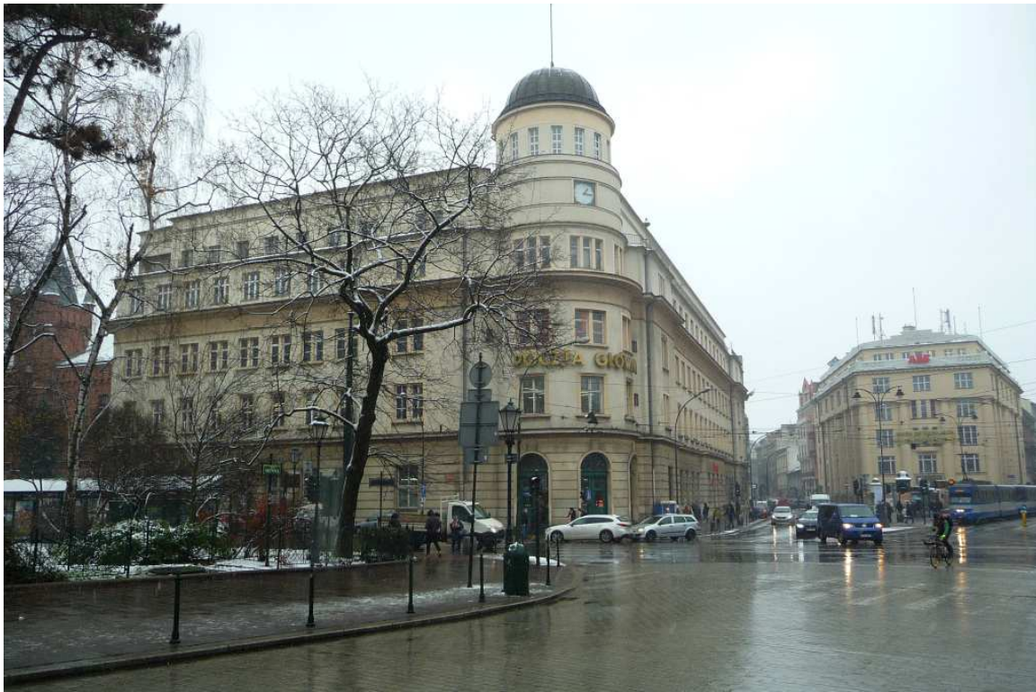
Fot. nr 225. Budynki Poczty Głównej i „Kurierka” w ujęciu z wylotu ulicy Siennej. (04.12.2017)
