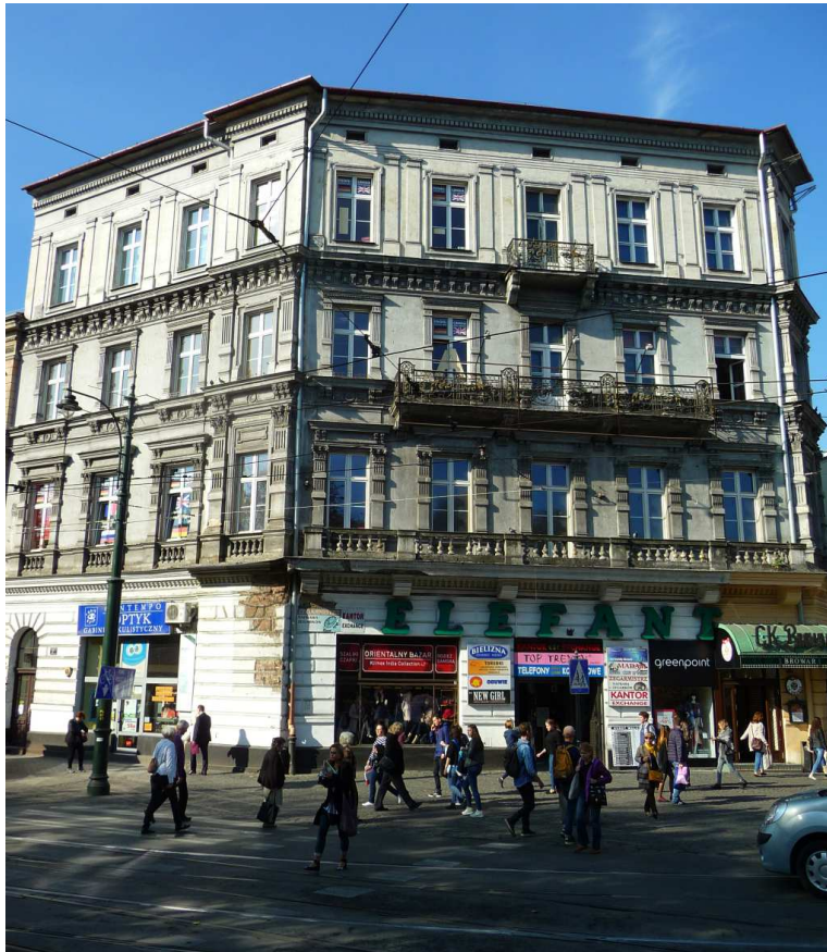
Fot. nr 93. Kamienica z naroża ulic: Podwale i Krupniczej. (17.10.2017)
