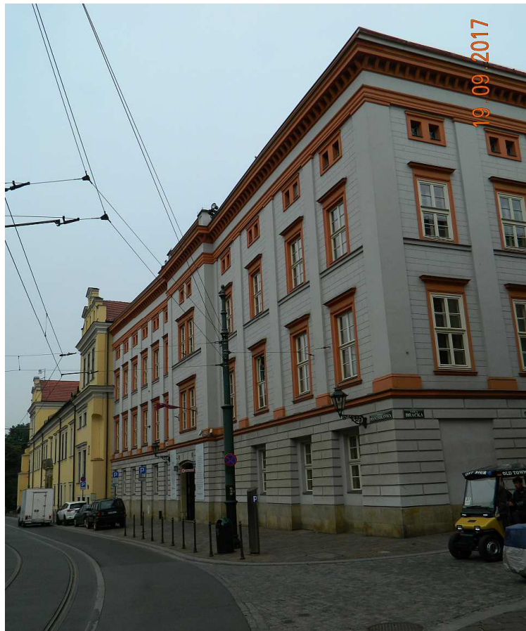
Fot. nr 2. Fragment ulicy Franciszkańskiej w ujęciu z wylotu ulicy Brackiej.
