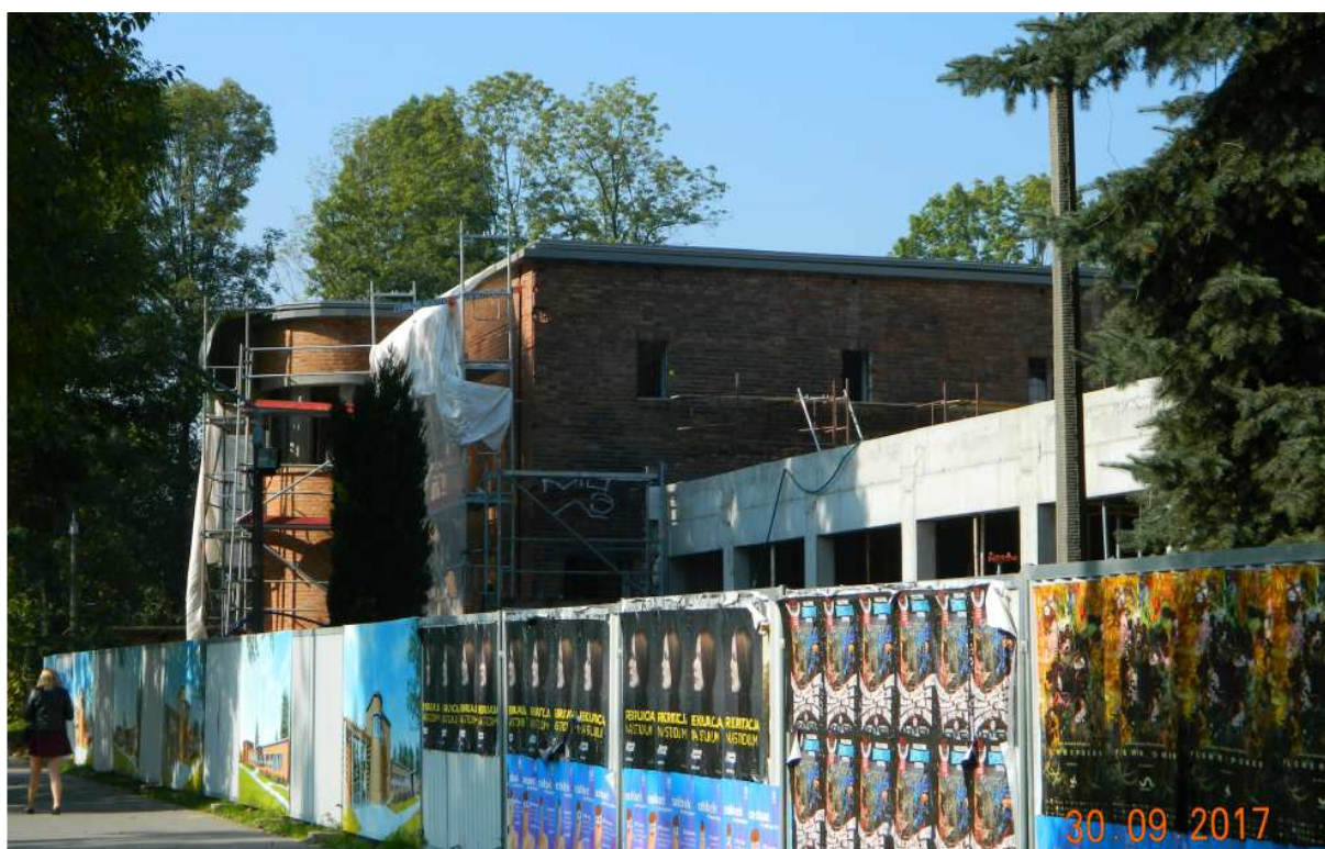
Fot. nr 172. Trwa też remont dawnego budynku mieszkalnego przylegającego do szatni.
