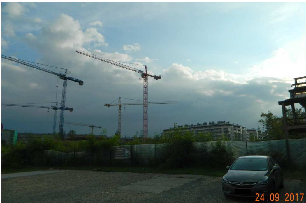
Fot. nr 241 (241-243). Plac budowy w miejscu budynków fabrycznych dawnej fabryki Zieleniewskiego.
