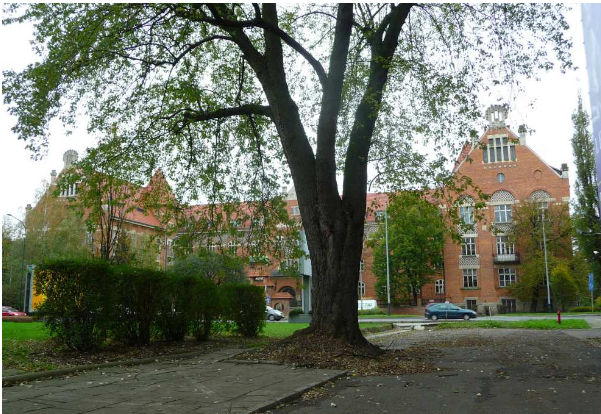
Fot. nr 126 (126-127). Gmach dawnej Szkoły Przemysłowej przy alei Mickiewicza 5. (01.11.2017)
