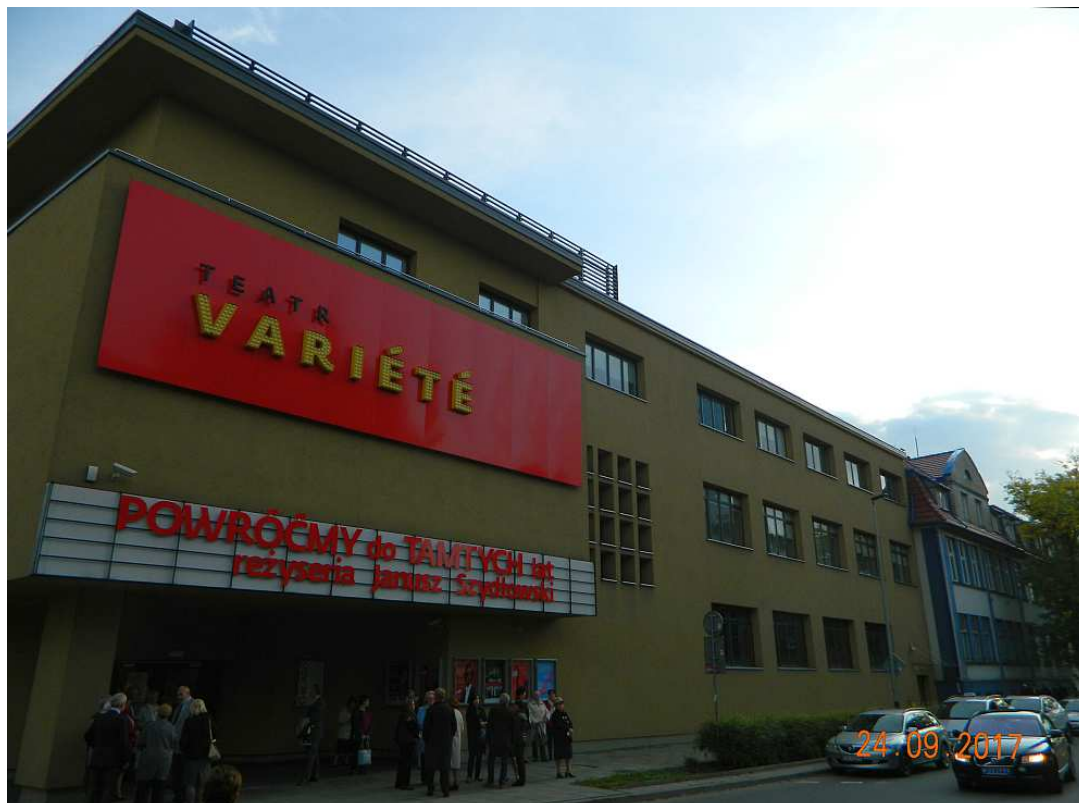
Fot. nr 237 (237-238). Teatr Varieté i budynek administracyjny dawnej fabryki Zieleniewskiego.
