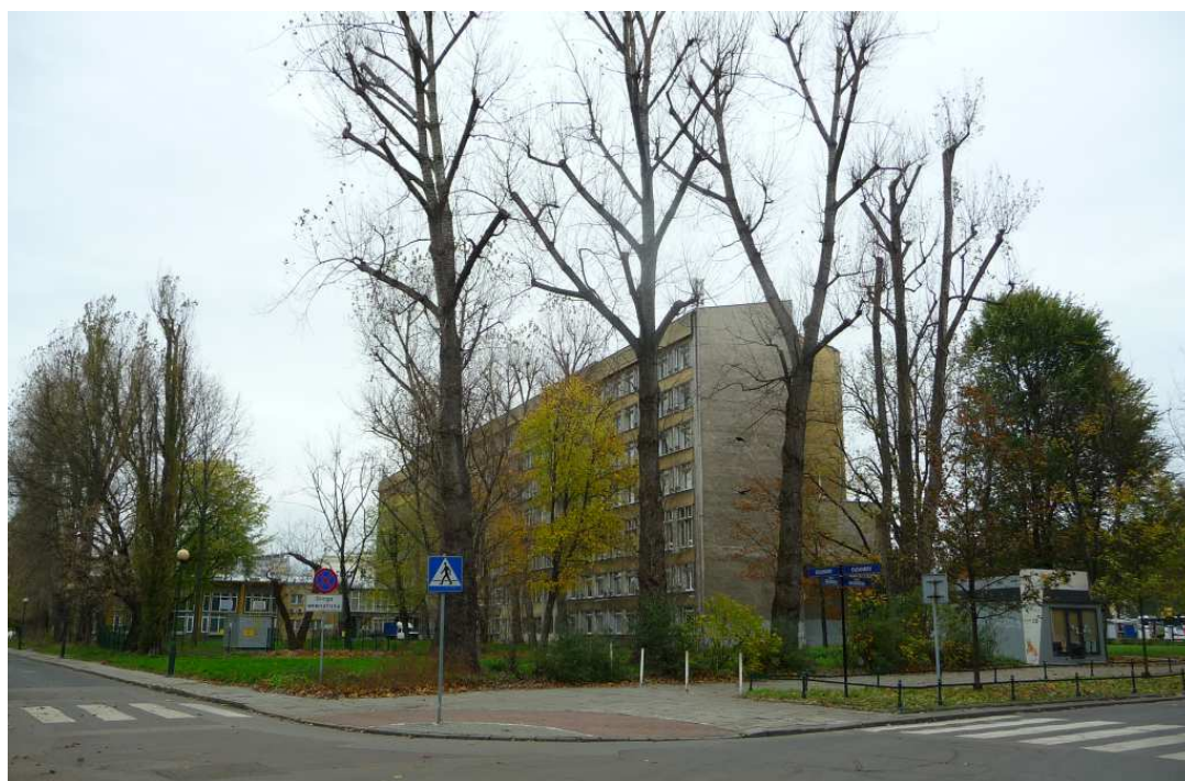
Fot. nr 138. Nowy gmach „Wysrołu” w ujęciu od strony ulicy Oleandry. (01.11.2017)
