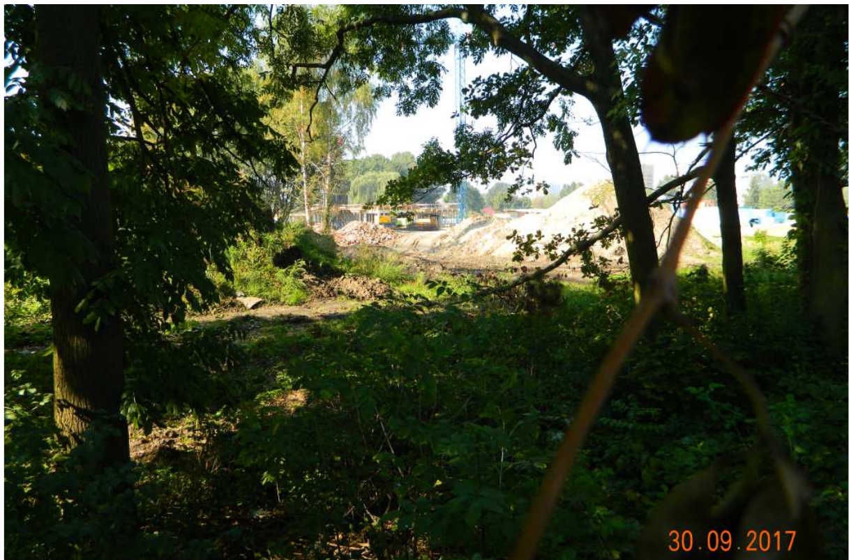
Fot. nr 164 (164-166). Plac budowy blokowiska mieszkalnego w miejscu dawnego stadionu lekkoatletycznego w Cichym Kąciku i przylegającego do niego kompleksu sportowo-rekreacyjnego. To największy „przekręt” w Krakowie w dziejach III RP.
