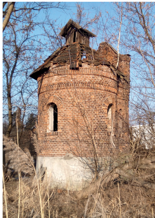
„Studnia zbiorcza” – pamiątka po historycznym Wodociągu Salinarnym z początku XX w.
