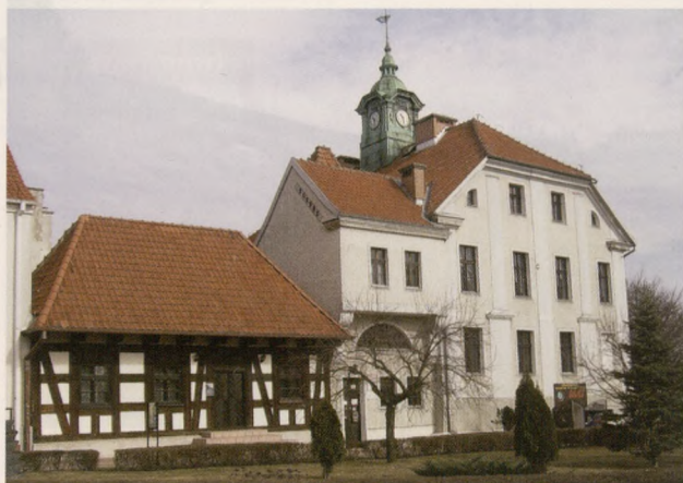
Ryc. 17. Szachulcowy budynek Strażnicy Bośniackiej przy Ratuszu Mrą- gowa. Fot. M. Olszowska.
