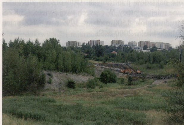
Ryc. 5. Budowa drogi dojazdowej. Fot. Mateusz Okrutniak
