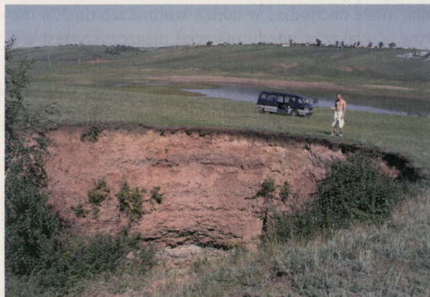
Ryc. 7. Zapadlisko sufozjno-krasowe na wybrzeżu Zbiornika Brackiego. Fot. M. Rzętała.
