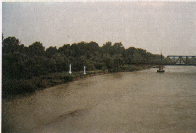
Ryc. 7. Koryto i lewobrzeżna równia zalewowa Skawy w Wadowicach. Przebieg przekroju wodowskazowego na równi zalewowej pokazano strzałkami, wskazującymi krawędź brzegu rzeki i podnóże skłonu terasy nadzalewowej. Bezpośrednio powyżej linii przekroju wodowskazowego na równi zalewowej widoczne wyłożone wikliny
