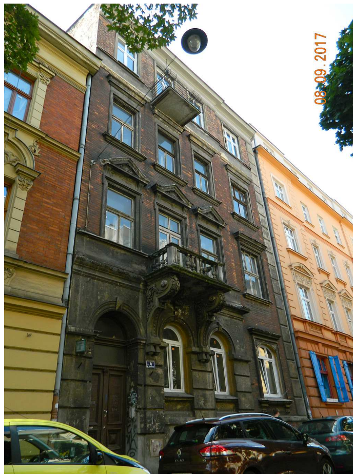
Fot. nr 171 (171-172). Eklektyczna kamienica z ul. Małej 4 z ostatniej kwarty XIX wieku.
