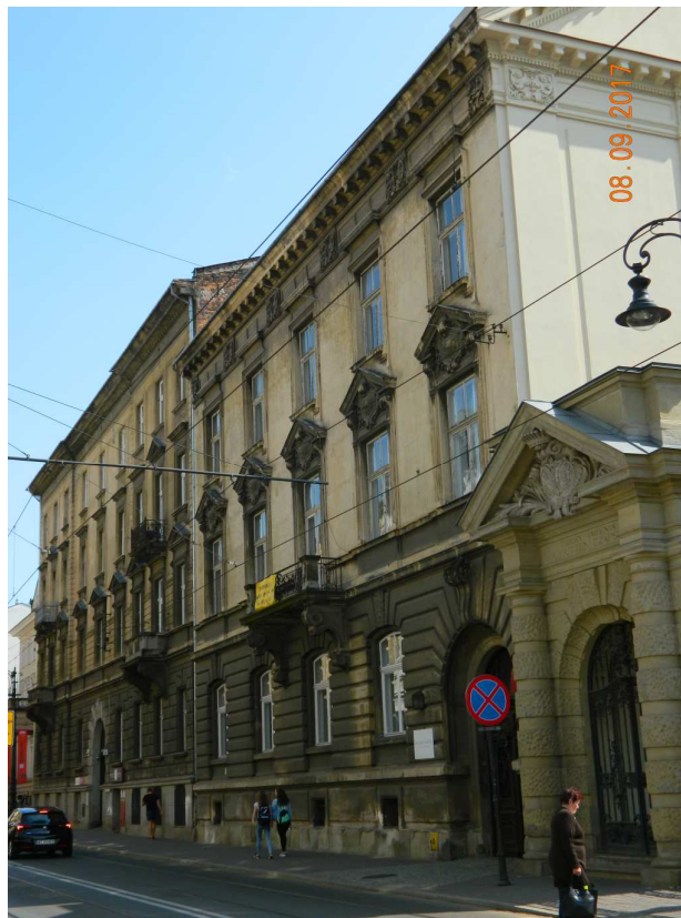
Fot. nr 8. Kamienice z ulicy Piłsudskiego pod nr 6 i 8. Ta pierwsza pochodzi z lat 1892-93 (proj. Jan Zychoń), zaś druga z roku 1896 (proj. Tadeusz Stryjeński i Zygmunt Hendel).
