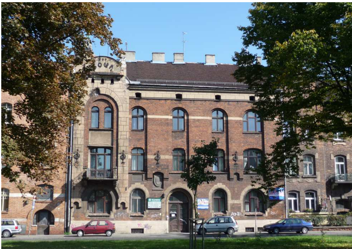
Fot. nr 32. Kamienica Pod Sową spod nr 21 oddana do użytku z roku 1907. Autorami jej projektu byli: Roman Bandurski i Piotr Kozłowski. (01.10.2011)
