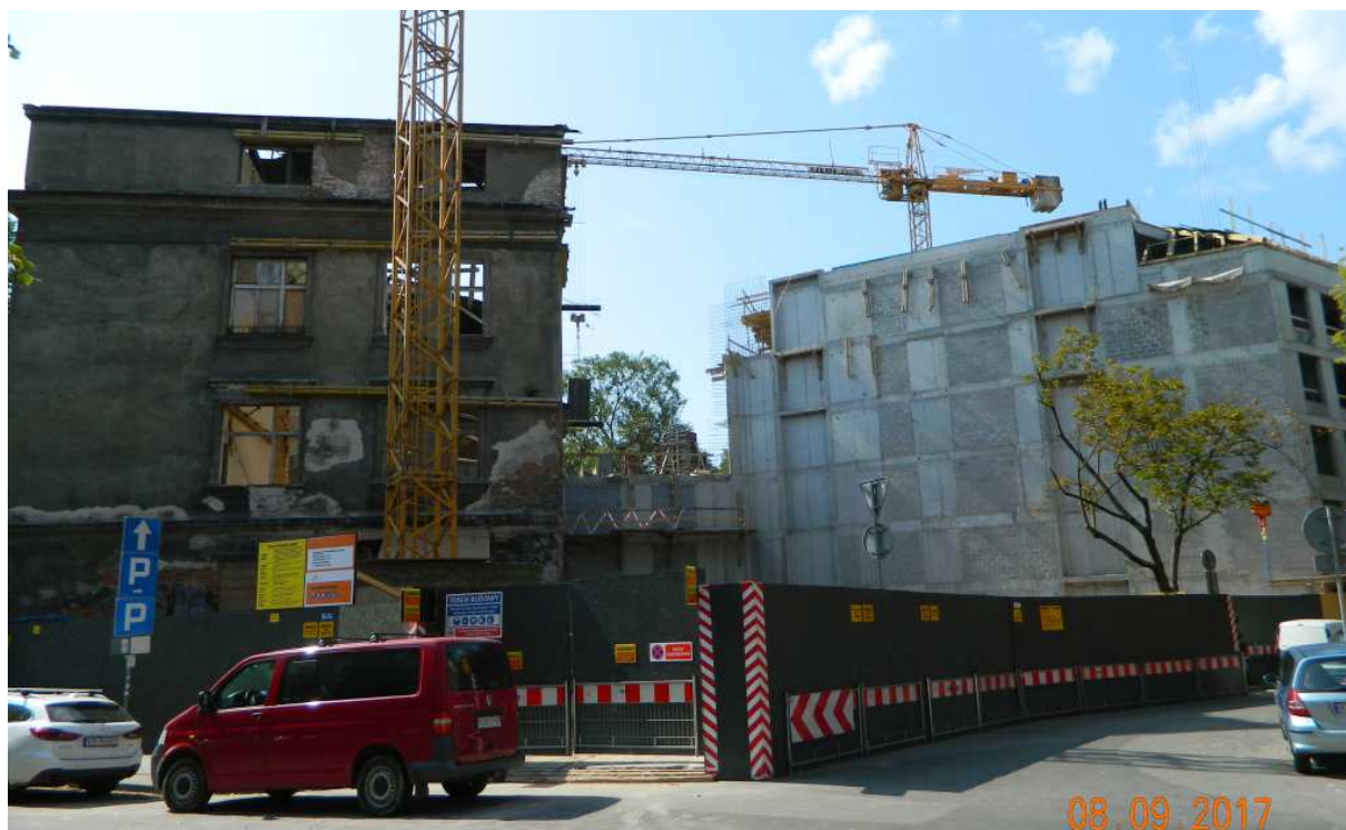
Fot. nr 65 (65-68). Stan w trakcie przebudowy (i rozbudowy) na hotel. Inwestorem jest Adam Bachleđa Curuś, kontrowersyjna postać z Zakopanego.
