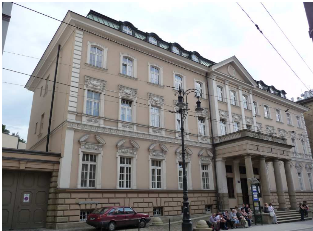
Fot. nr 5 (5-7). Pałac Ogińskich i Potulickich spod nr 4. Pałac powstał w latach 1874-75, a jego projektantami byli: Leandro Markoni i Filip Pokutyński. (28.07.2011)
