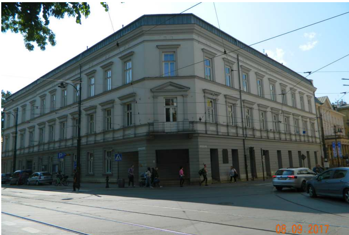
Fot. nr 4. Kamienica spod nr 2, ukończona w roku 1878.
