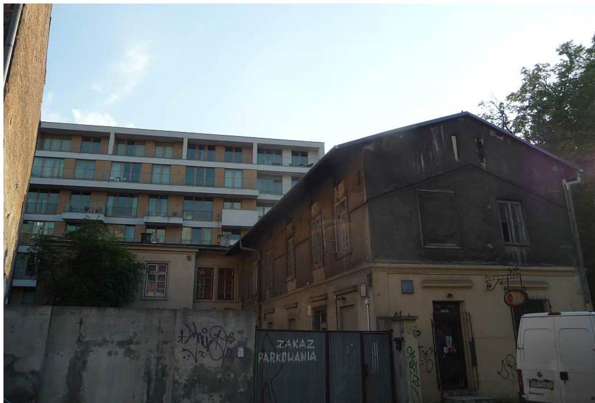
Fot. nr 203. Originalne ośmiopolowe okna drewniane, otwierane na zewnątrz, charakterystyczne dla klasycystycznych budynków. To dziś w Krakowie prawdziwa rzadkość, choć w obrazie Krakowa dominowały w III ćwierci XIX wieku. (06.06.2014)
