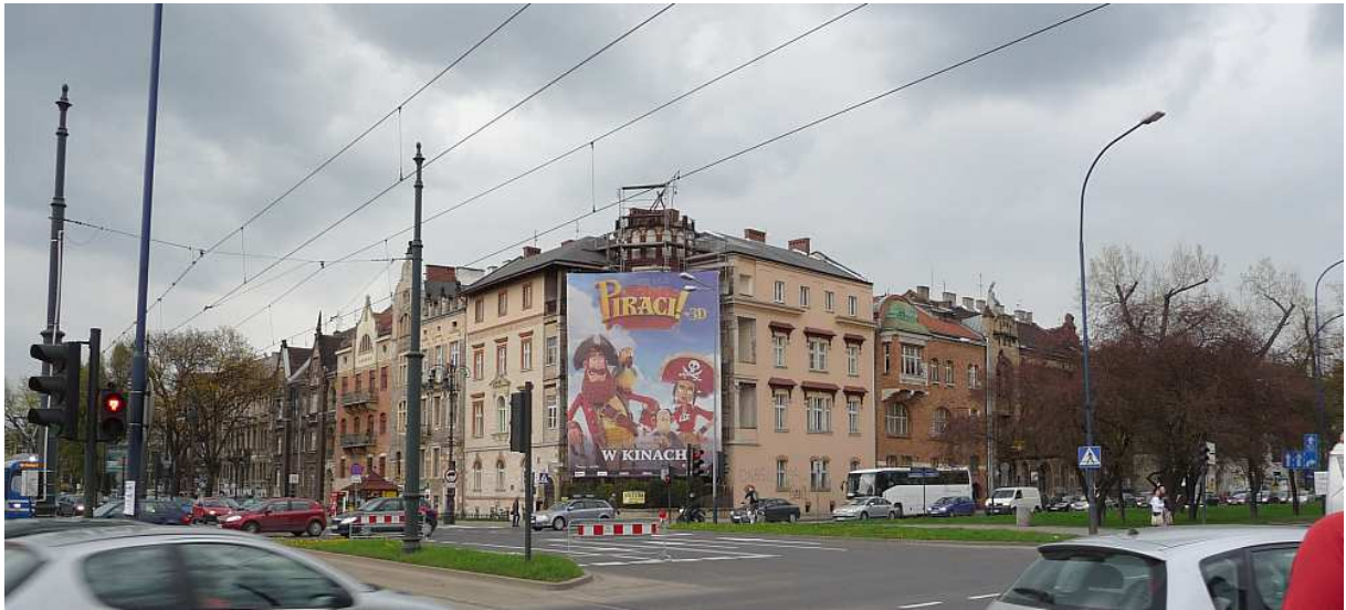
Fot. nr 29 (29-29a). Naroże ulicy Piłsudskiego i alei Krasińskiego. Kamienica narożna to dom własny Władysława Ekielskiego z dobudowanym w latach 30-tych XX wieku trzecim piętrem, które przytłumiło okrągłą wieżę widokową. (21.04.2012)
