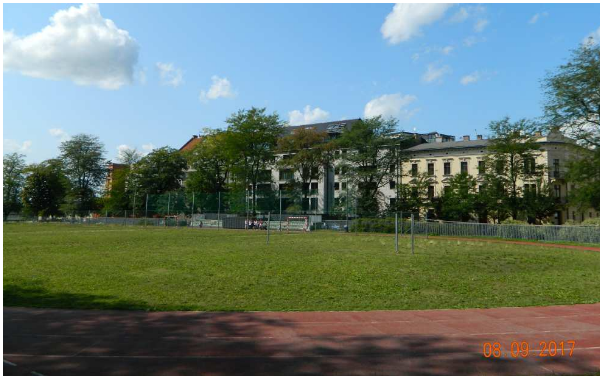
Fot. nr 75 (75-76). Północna pierzeja placu Na Groblach o nr 2-6 ponad szkolnym boiskiem i bieżnią.
