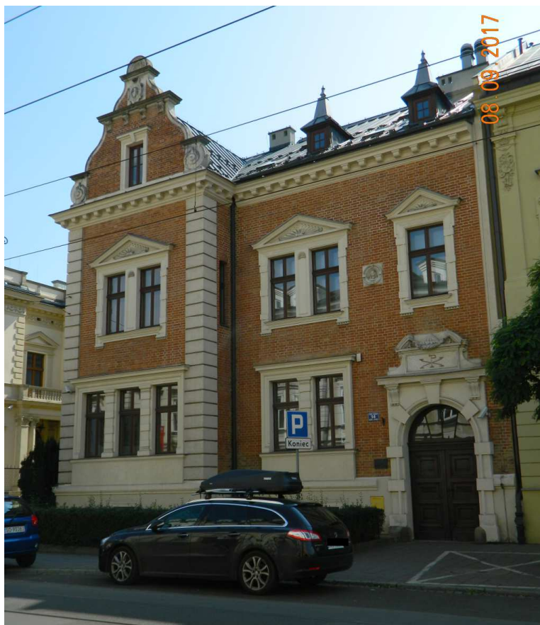
Fot. nr 14. Fasada domu spod nr 14.
