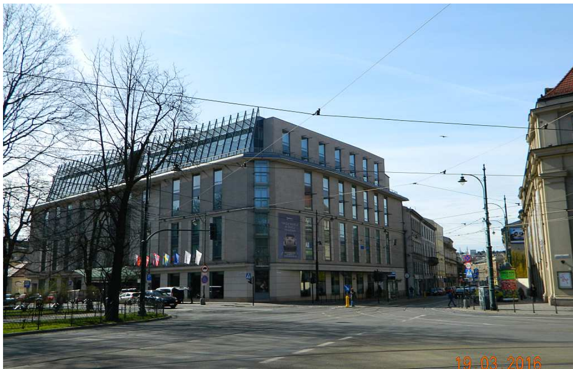
Fot. nr 197. Betonowo-szklany budynek spod nr 2, który powstał w miejscu dawnej drukarni Anczyca. Od początku lat 70-tych XX wieku był tam pusty plac, który z czasem został wykorzystywany jako parking
