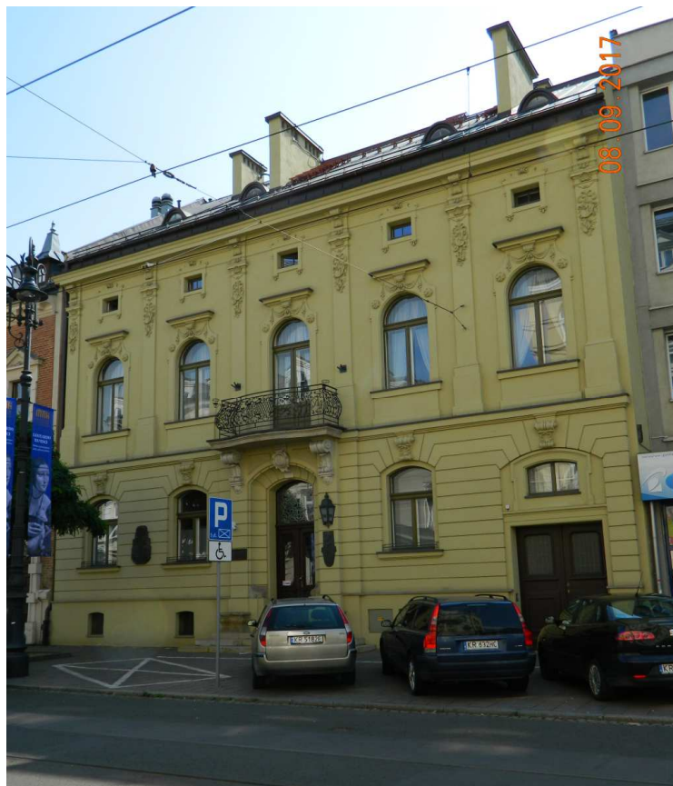
Fot. nr 15. Fasada domu spod nr 16.
