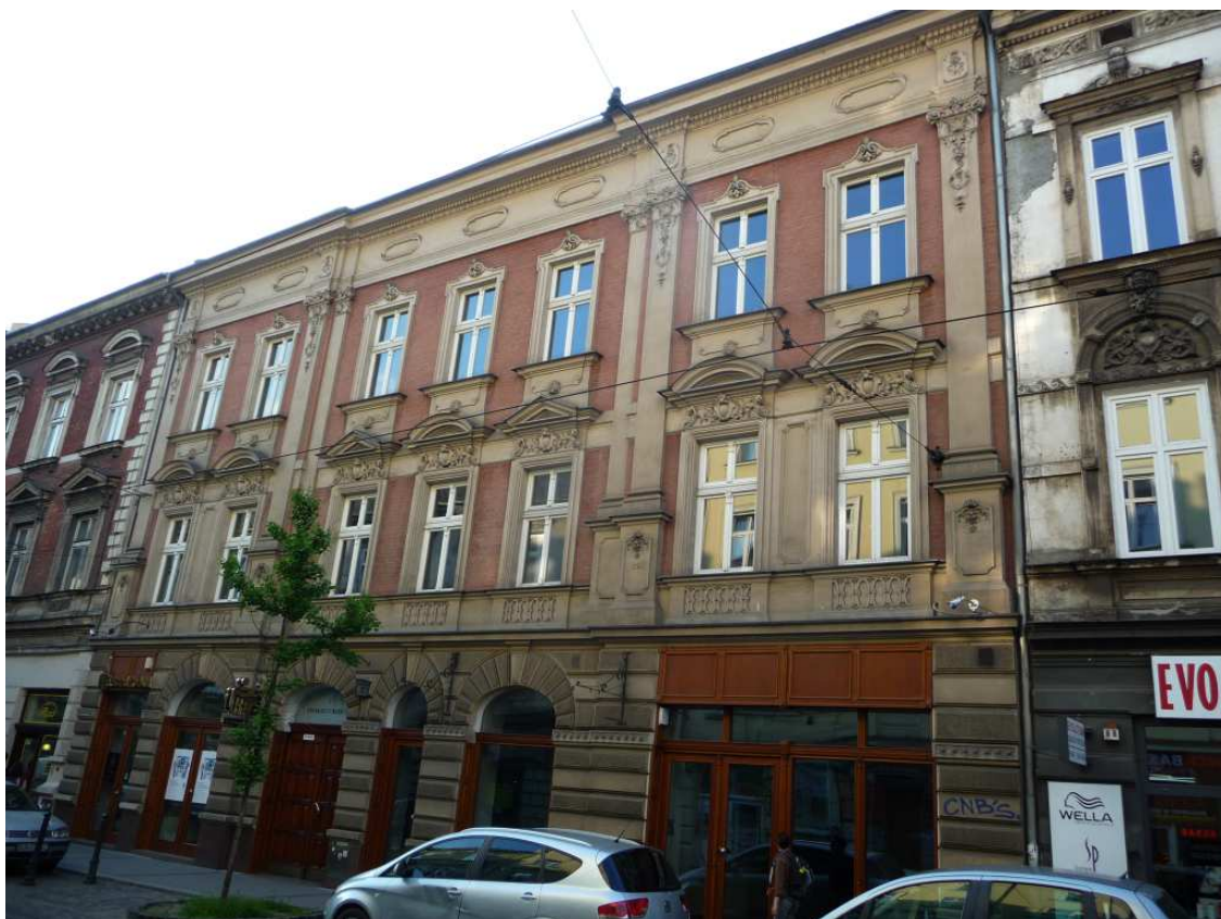
Fot. nr 195. Odnowiona kamienica spod nr 7, która powstała w roku 1892 wg projektu Beniamina Torbe. (06.06.2014)
