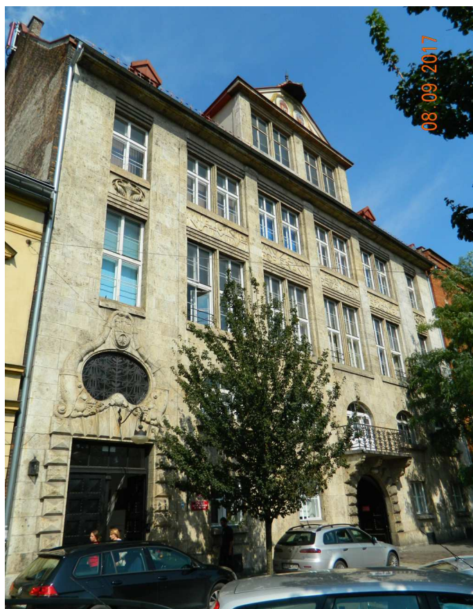
Fot. nr 150 (150-152). Gmach dawnego Muzeum Techniczno-Przemysłowego spod nr 9, gdzie obecnie mieści się Wydziału Form Przemysłowych ASP. (1908-1914)
