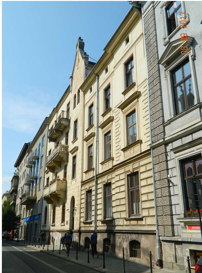
Fot. nr 155 (155-156). Kamienica pod nr 23 z ostatniej ćwierci XIX wieku.
