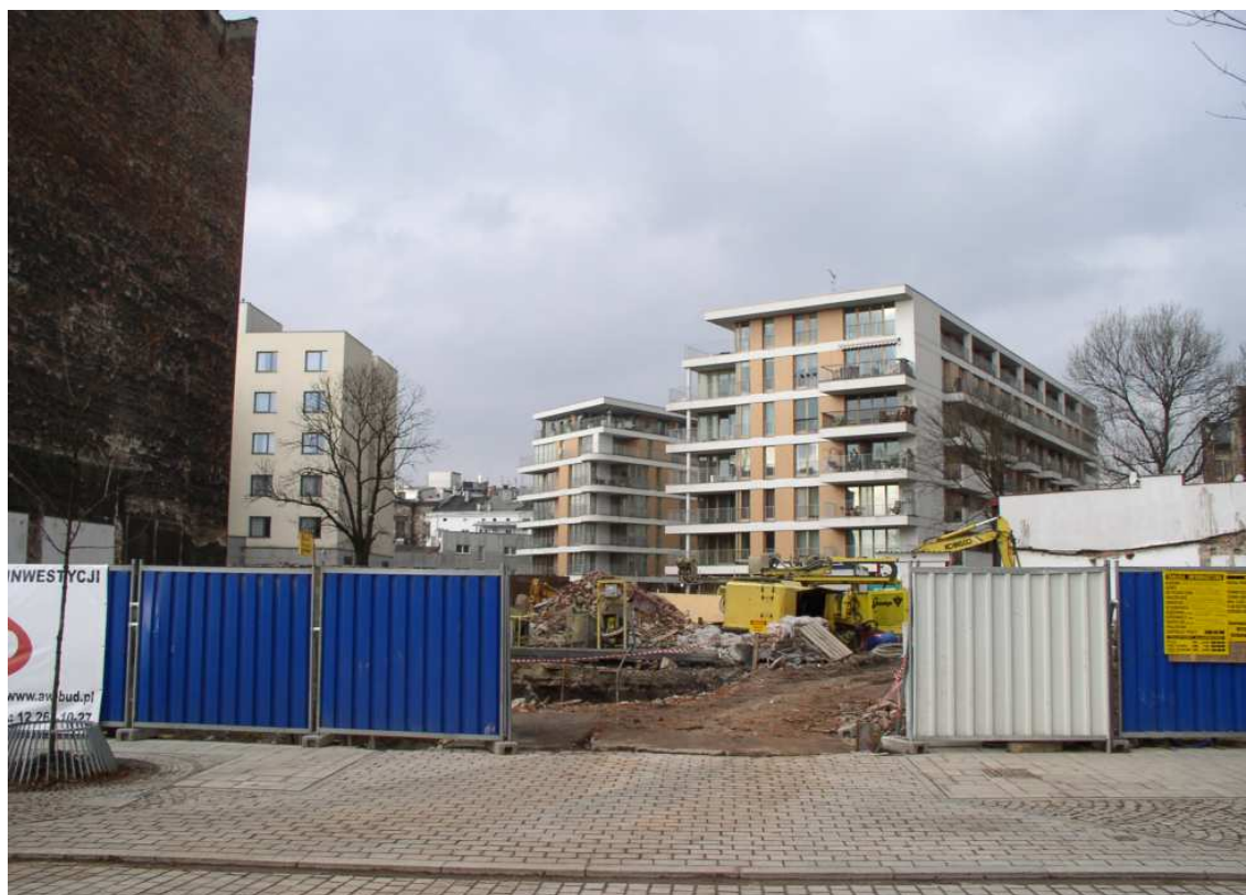
Fot. nr 74. Spojrzenie w kierunku nowych bloków z ulicy Zwierzynieckiej przez wolną przestrzeń po wyburzonych właśnie budynkach pod nr 4 i 5. (25.01.2010)
