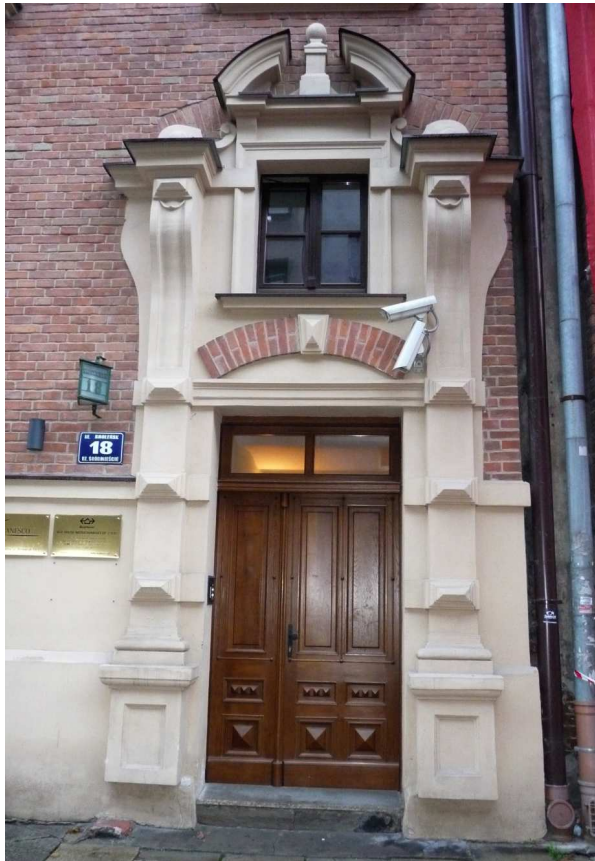
Fot. nr 165. Odnowiony portal. (07.09.2011)
