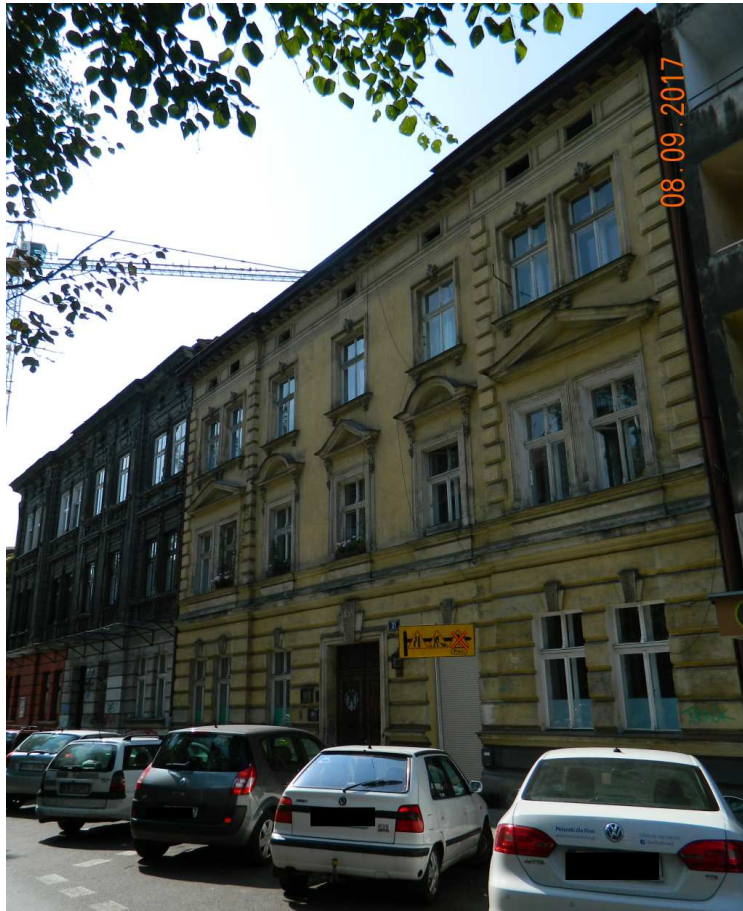
Fot. nr 145. Zabudowa ulicy pod nr: 21-23, która powstała w ostatniej dekadzie XIX w.
