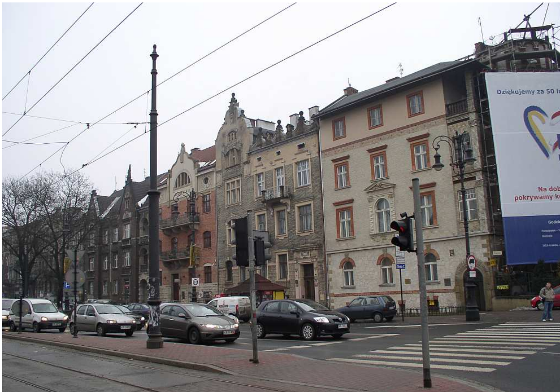
Fot. nr 23 (23-24). Fragment zabudowy ulicy Piłsudskiego o numerach 30-40. Widoki od strony alei Trzech Wieszczów. (11.01.2011)
