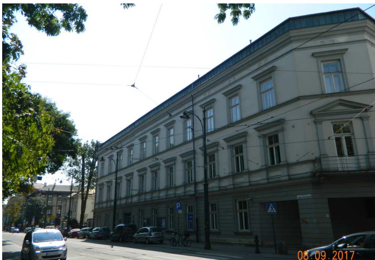
Fot. nr 232 (232-233). Kamienica z naroża ulic Straszewskiego 22 i Piłsudskiego 2, gdzie obecnie mieści się PWST. Powstała w roku 1878 wg projektu Jacka Matusińskiego.
