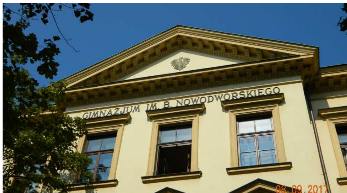
Fot. nr 70. Zwieńczenie ryzalitu fasady.
