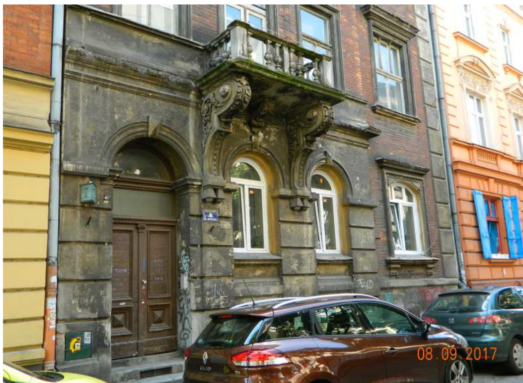
Fot. nr 172. Detale parteru.
