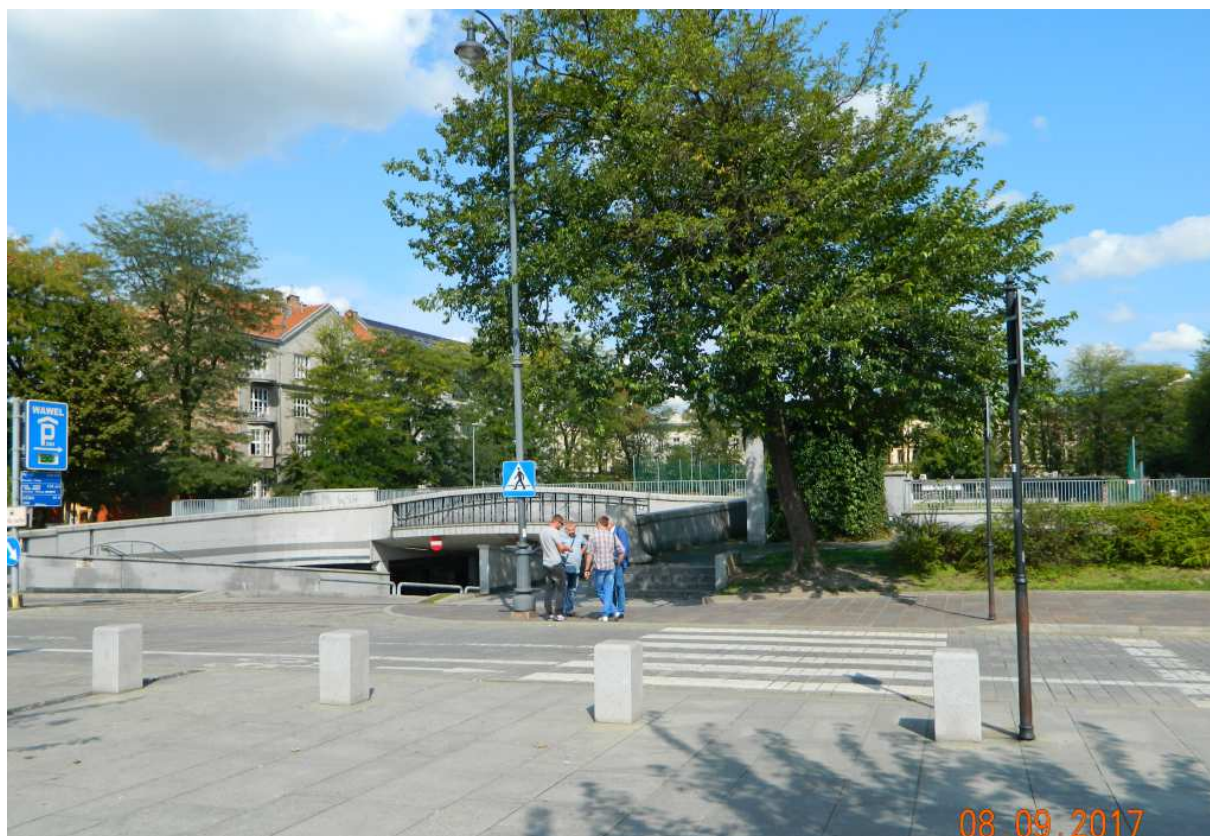
Fot. nr 77. Wjazd na podziemny parking pod placem Na Groblach (nr 24) od strony ulicy Powiśle.
