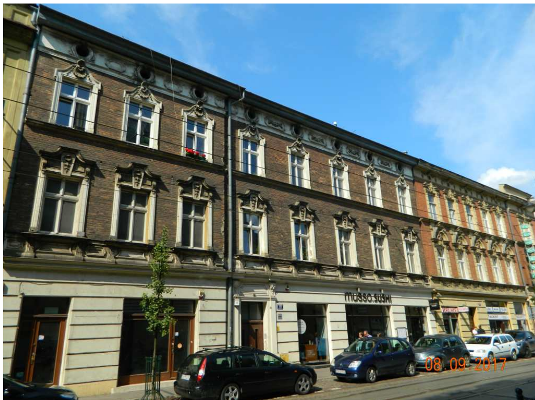
Fot. nr 185. Kamienice pod nr: 21 i 23, wybudowane w ostatniej dekadzie XIX wieku.
