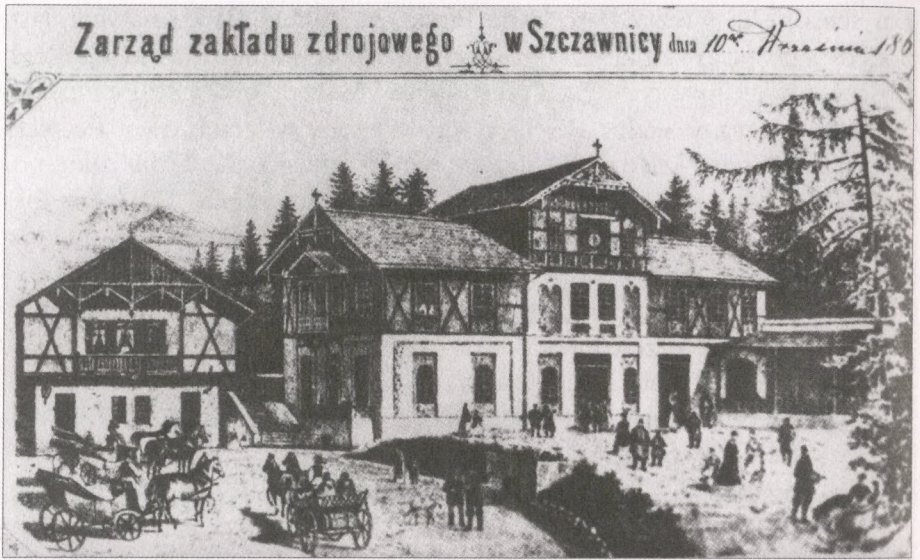
Zarząd zakładu zdrojowego w Szczawnicy, 10 września 1869 r. (ze zbiorów autora)
