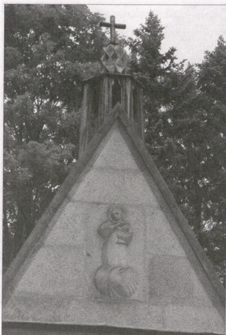
Szczyt elewacji frontowej mauzoleum po renowacji (fot. Zbigniew Moździerz, 2009)
