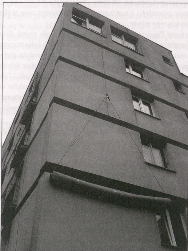
Budynek przy ul. Traugutta 4 w Krakowie, gdzie mieści się na ostatnim piętrze siedziba PTT. Fot. Nikodem Frodyma
