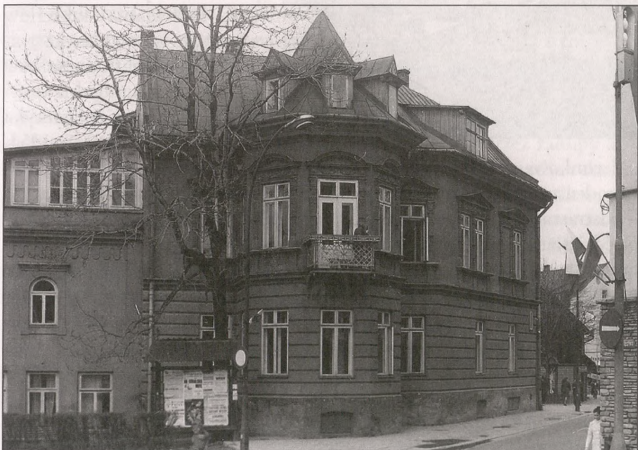
Budynek – o nazwie „Kresy” – w którym mieściła się Biblioteka Publiczna do 1995 roku
