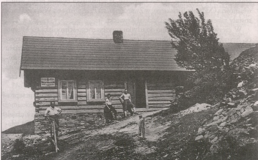
Stacja turystyczna Oddziału Babiogórskiego na Żarze nad Międzybrodziem (761) m.
