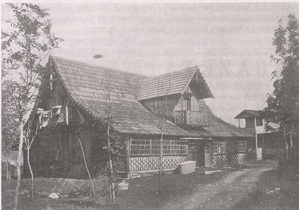
Pierwsza willa na Krupówkach, zbudowana w 1877 r. przez Walerego Eljasza, nabyta w 1881 r. przez Balbinę Zalewską z Warszawy, zgorzała w czasie pożaru w Zakopanem dnia 21 stycznia 1899 r. Fotografia z roku 1891. Fot. Walery Eljasz
