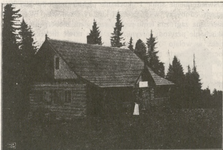
Schronisko Oddziału Babogórskiego Tow. Tatr. na Markowych Szczawinach pod Babią Górą, zbudowane w r. 1906.
