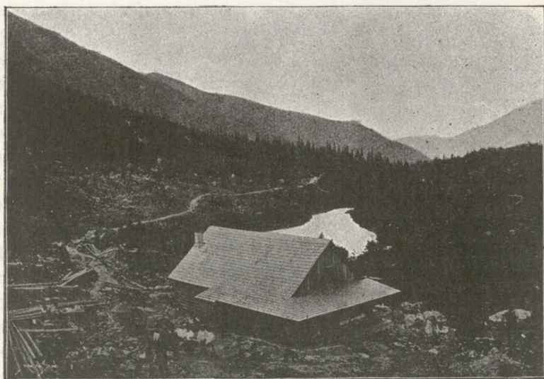
Tymczasowe schronisko Tow. Tatr. nad Morskiem Okiem w r. 1899.
