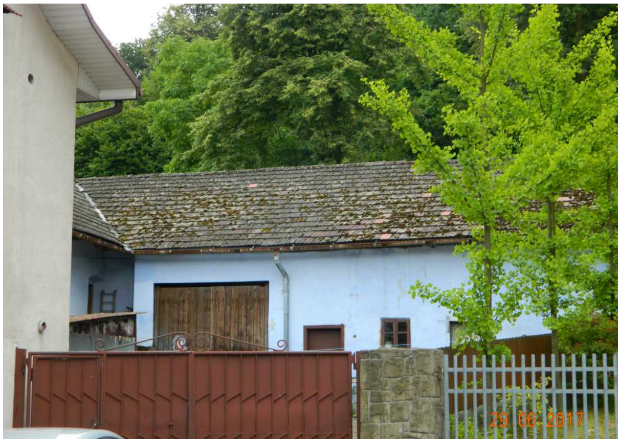
Fot. nr 139. Archaiczne zaplecze kamieniczki z Rynku 35, do dziś tradycyjnie bielonej.
