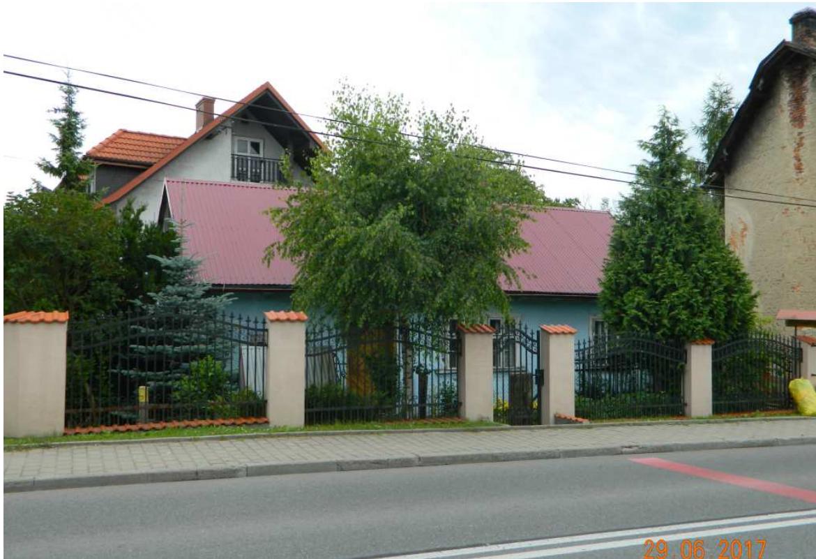
Fot. nr 139. Widok współczesny na przysłoniętą fasadę.
