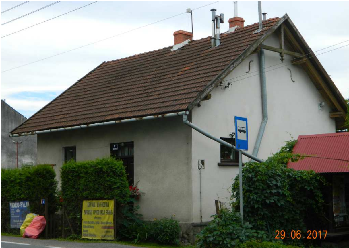
Fot. nr 236. Oryginalna więźba dachowa.
