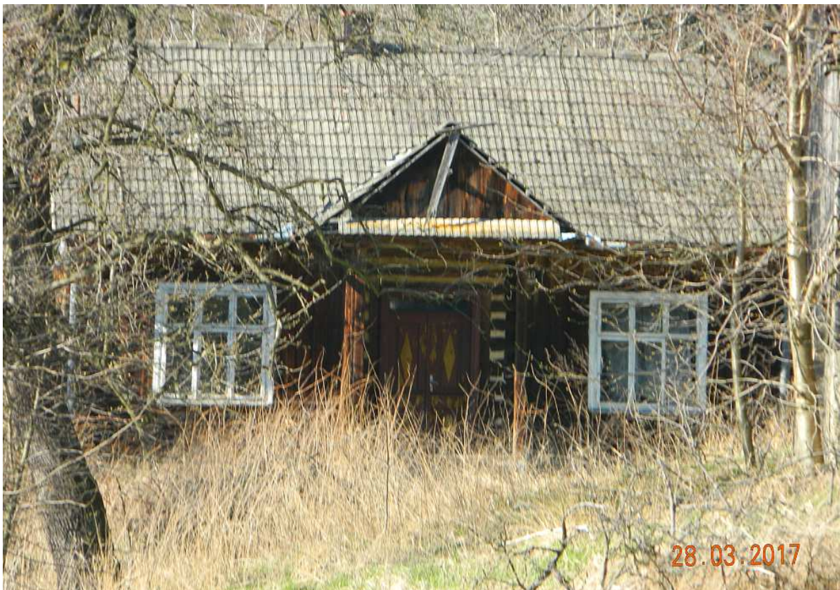
Fot. nr 298 (298-306). Opuszczony dom pod nr 10 i jego detale. Można przypuszczać, że powstał jeszcze przed II wojną światową bądź niedługo po jej zakończeniu.
