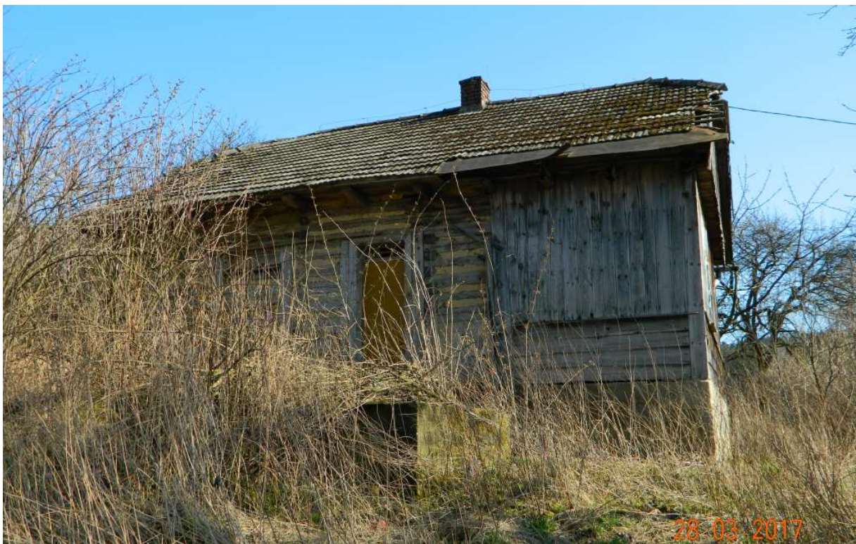
Fot. nr 304. Tylna domu, do której zapewne przylegało gnojowisko.
