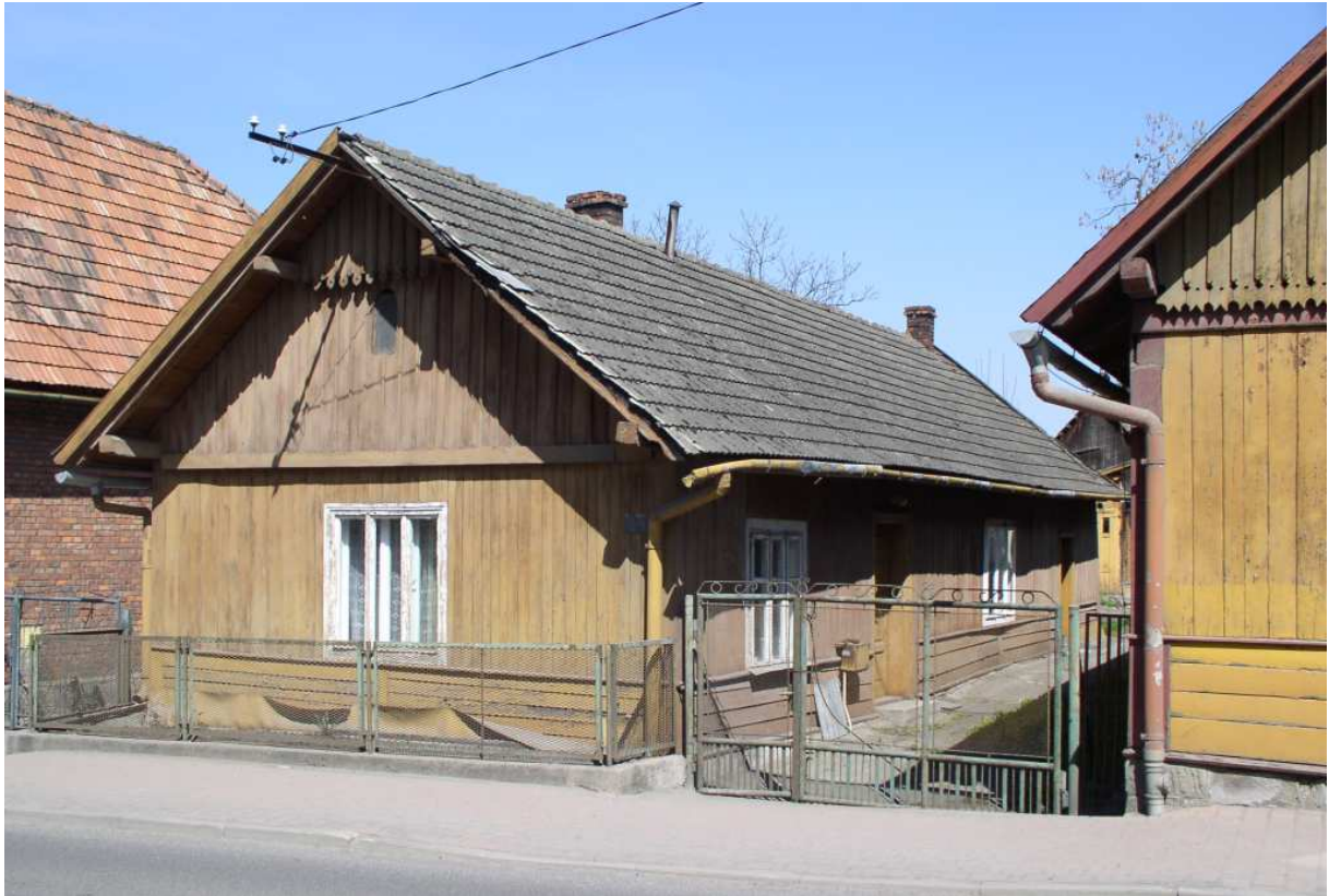
Fot. nr 149. Przykład zabudowy ulicówki o charakterze szczytowo-frontowym. Zapewne stuletni dom pod nr 22. (15.04.2009)
