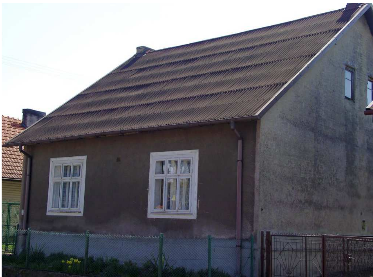
Fot. nr 166. Skromny, zapewne już powojenny domek spod nr 55. (15.04.2009)
