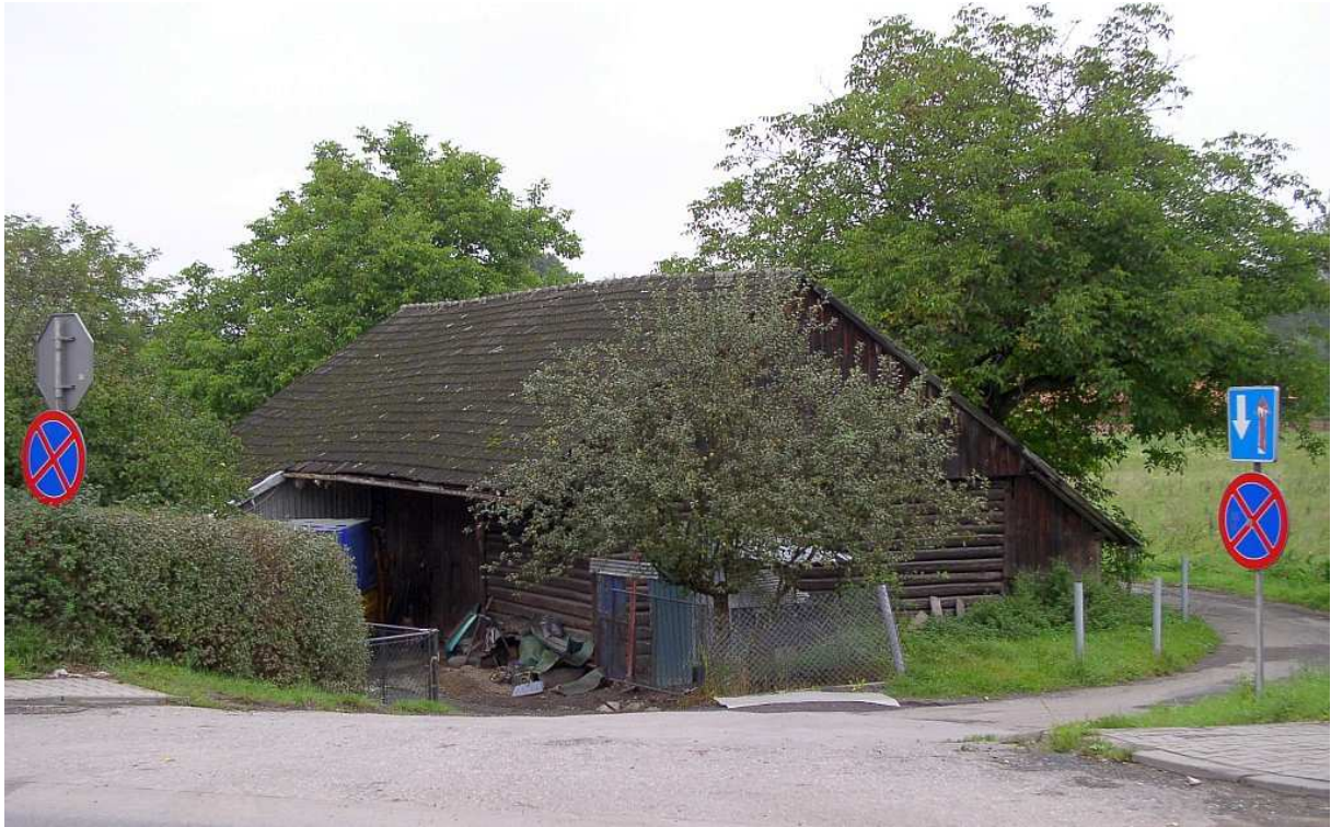
Fot. nr 25 (25-27). Oryginalna stodoła z sąsiedztwa Raby z naroża ulic Mostowej i Turystycznej, element zagrody spod nr 1. (12.09.2010)
