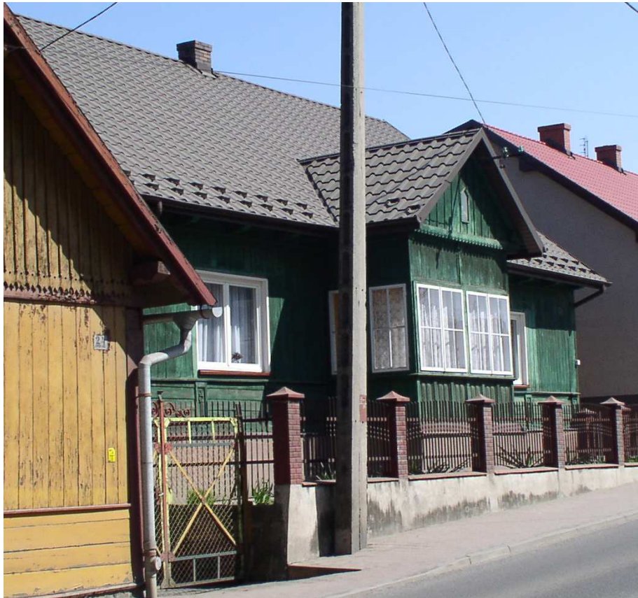
Fot. nr 151. Zapewne blisko stuletni dom z werandą spod nr 26. (15.04.2009)
