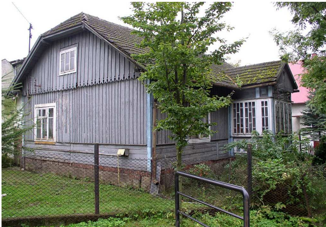
Fot. nr 216. Lewy narożnik. Zewnętrzna boazeria zapewne oryginalna. (12.09.2010)
