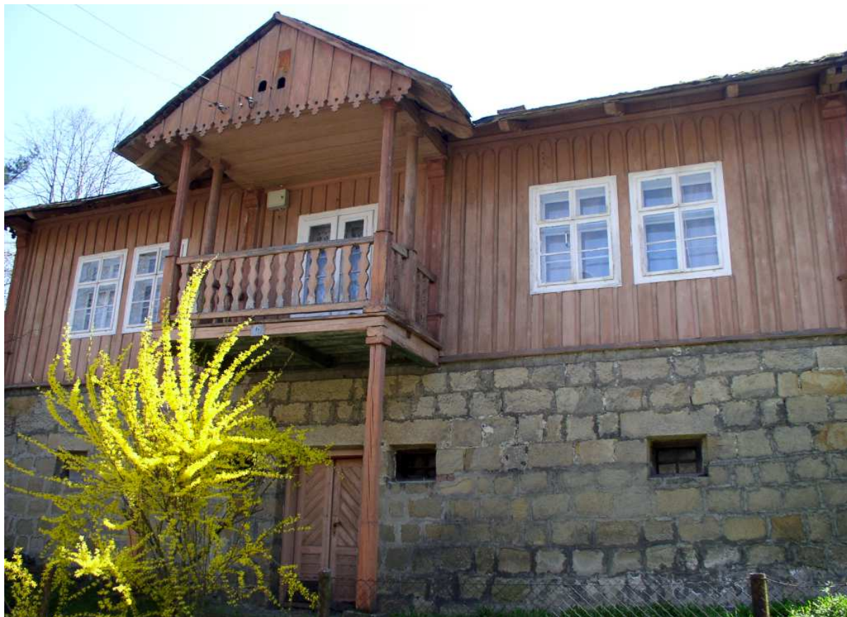
Fot. nr 77. Fasada willi i jej podmurowane przyziemie. (15.04.2009)
