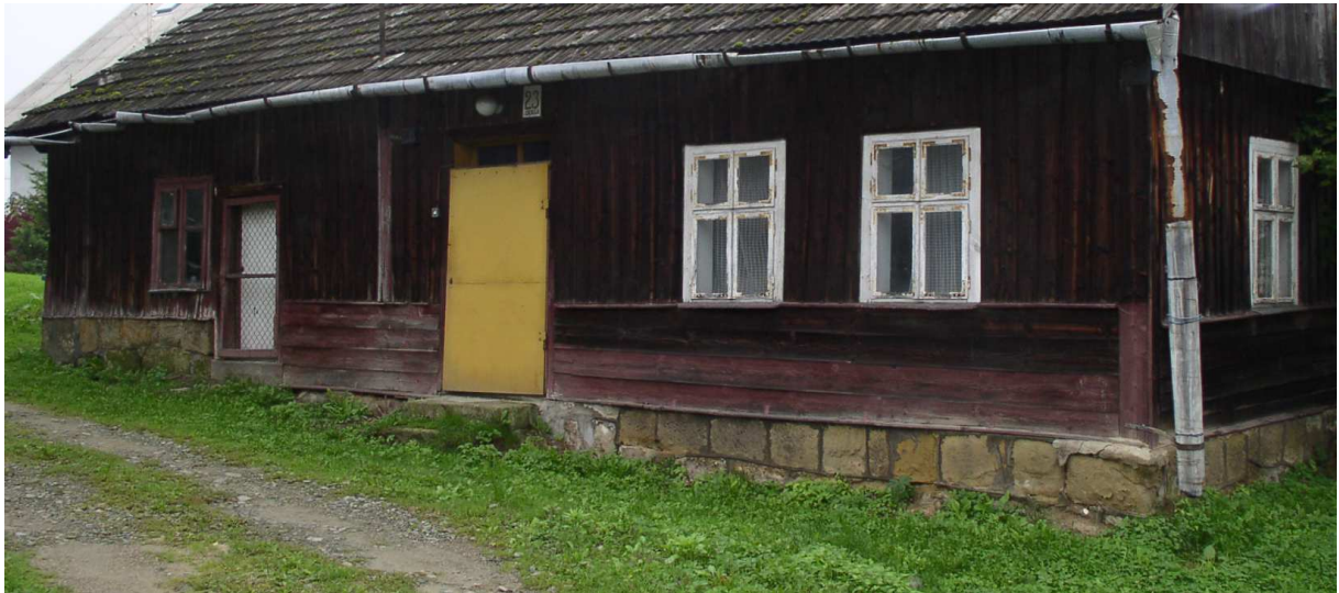
Fot. nr 185. Detale fasady z oryginalną stolarką okienną sprzed wielu dekad. (12.09.2010)
