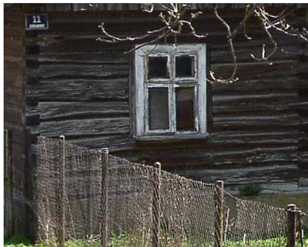
Fot. nr 244. Oryginalne detale: okno i poprzeczne belki drewniane. (15.04.2009)
