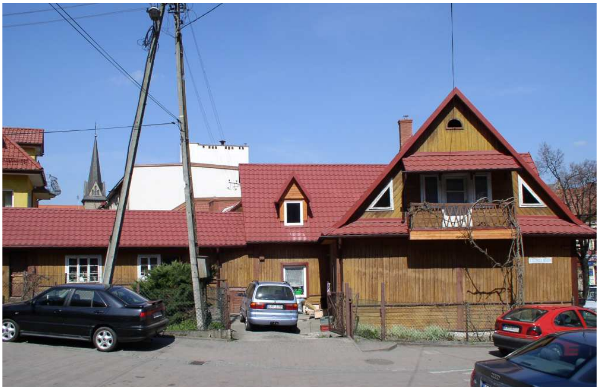
Fot. nr 72 (72-73). Stary kompleks mieszkalno-gospodarczy z naroża Rynku 33 i ulicy Kazimierza Wielkiego, pochodzący zapewne z początku XX wieku. (15.04.2009)
