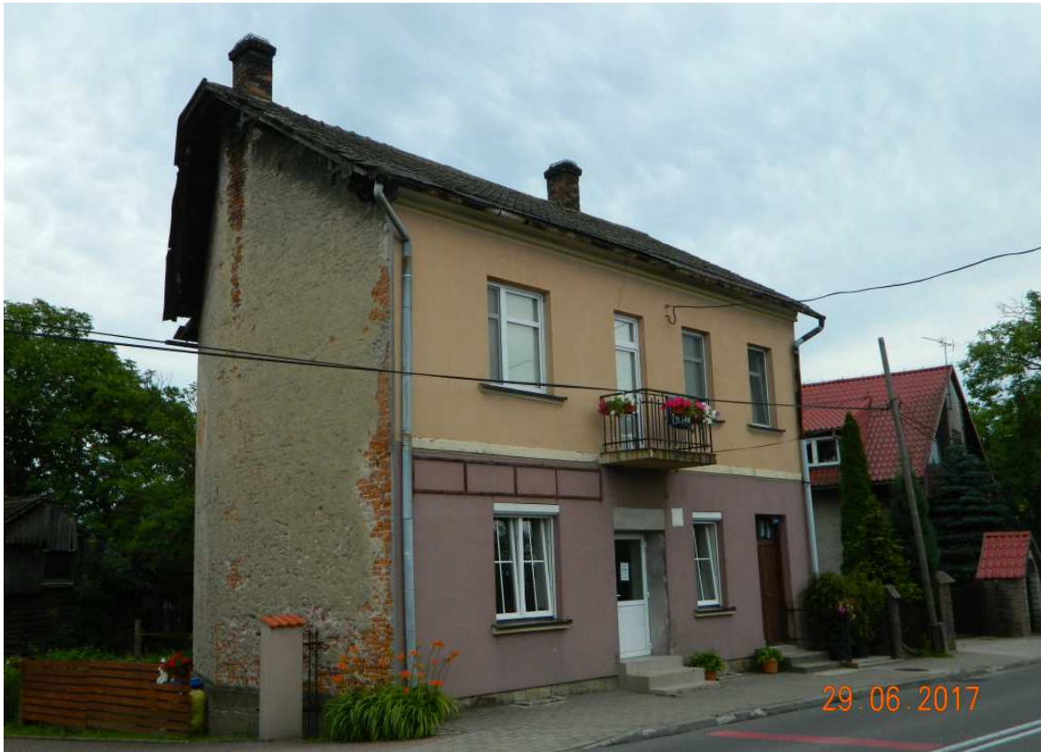
Fot. nr 237. Przedwojenna „kamieniczka” spod nr 55.
