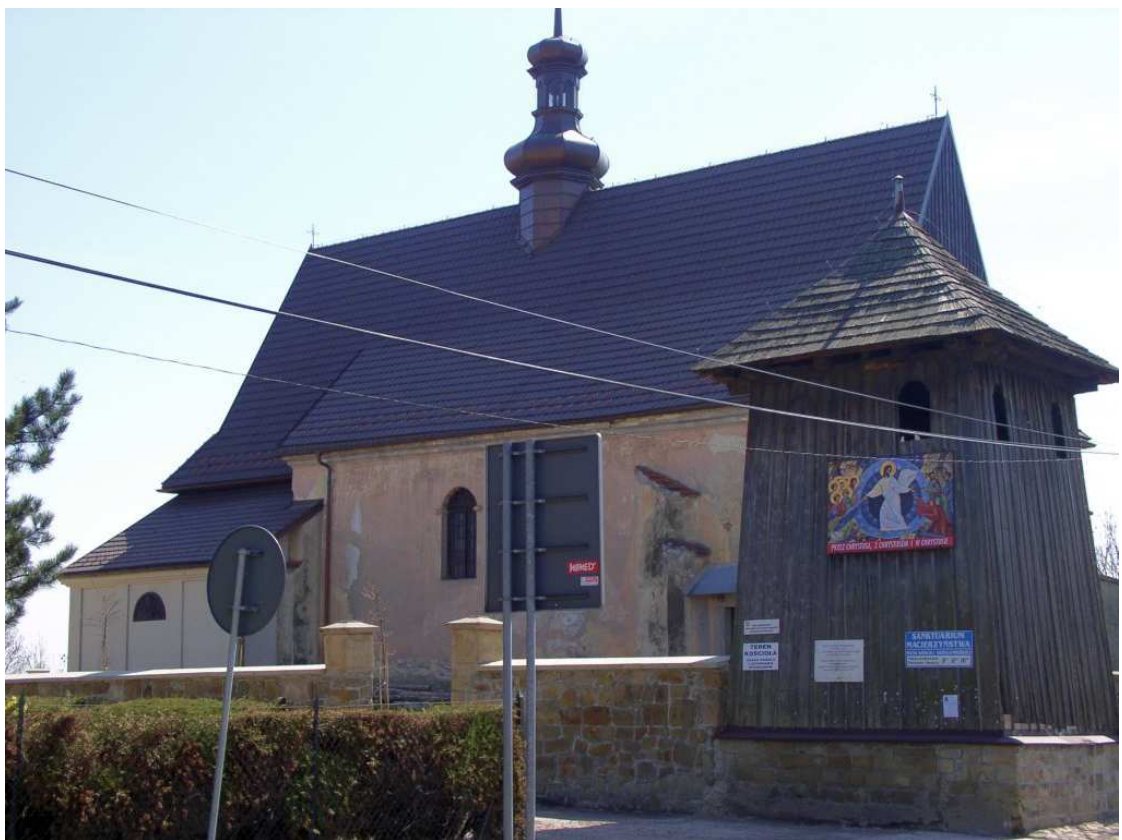
Fot. nr 222. Widok na przebudowaną w XVII wieku nawę główną kościoła i drewnianą dzwonicę. (15.04.2009)
