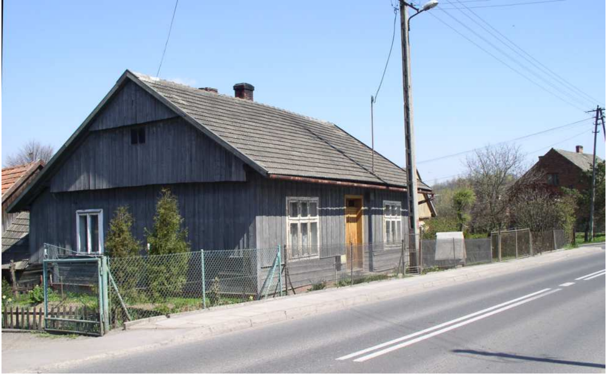
Fot. nr 179. Oryginalny, zapewne już powojenny dom spod nr 82. (15.04.2009)
