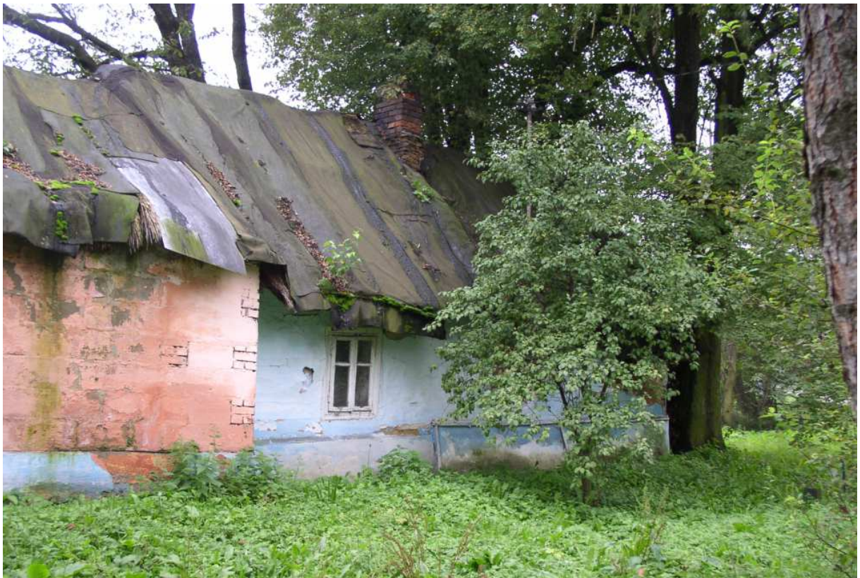
Fot. nr 202. Zapewne ponad stuletnia część mieszkalna, gdzie pod papą kryła się jeszcze strzecha. (12.09.2010)
