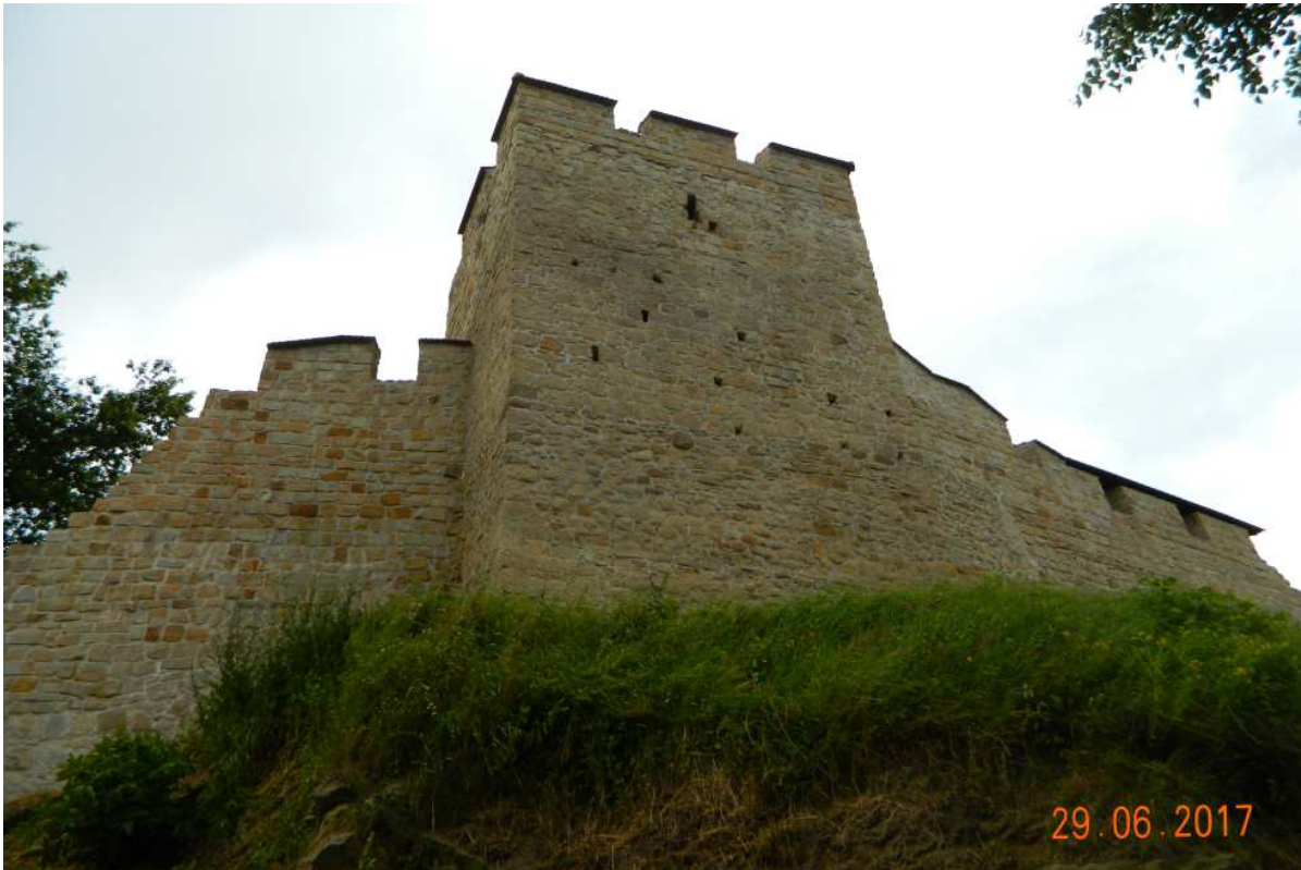
Fot. nr 85 (85-88). Częściowo rekonstruowane mury obronne starych Dobczyc na styku ulic: Kasztelana Dobka i Przedbronie. Pośrodku baszta.
