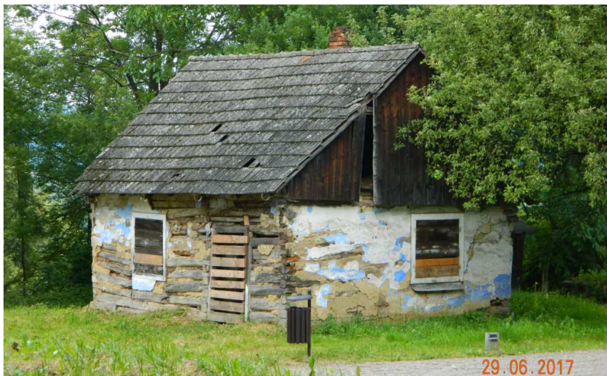
Fot. nr 93 (93-94). Archaiczny budynek gospodarczy w sąsiedztwie willi.
