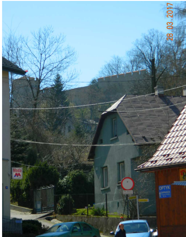
Fot. nr 81. Widok na mury obronne starych Dobczycy ponad ulicą kasztelana Dobka.
