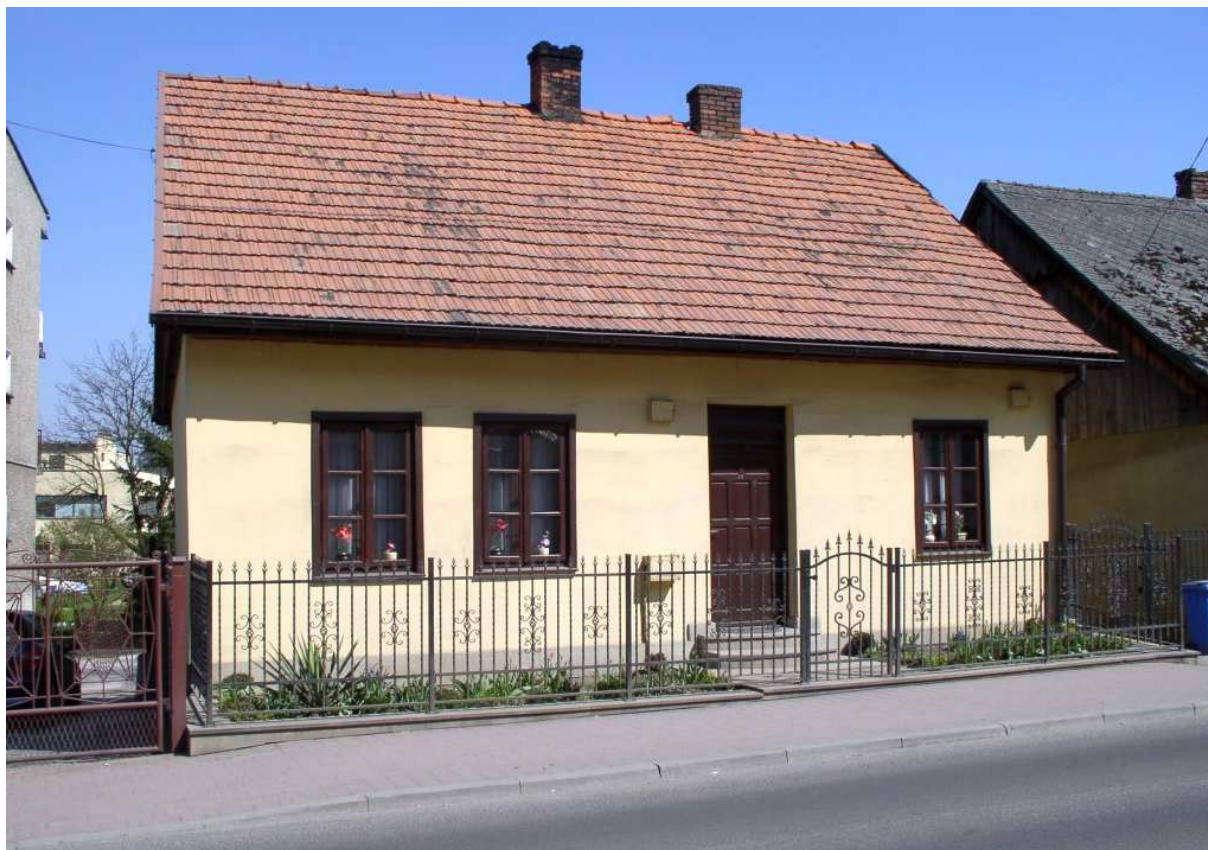
Fot. nr 147. Przebudowana, stara chałupa pod nr 14 z zachowaną stolarką okienną. (15.04.2009)
