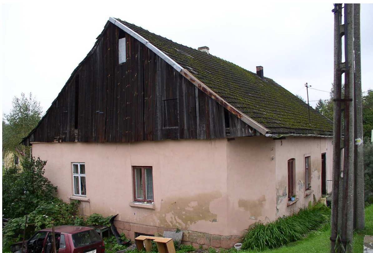
Fot. nr 28 (28-30). Przedwojenny, murowany budynek mieszkalny z sąsiedztwa mostu. (12.09.2010)
