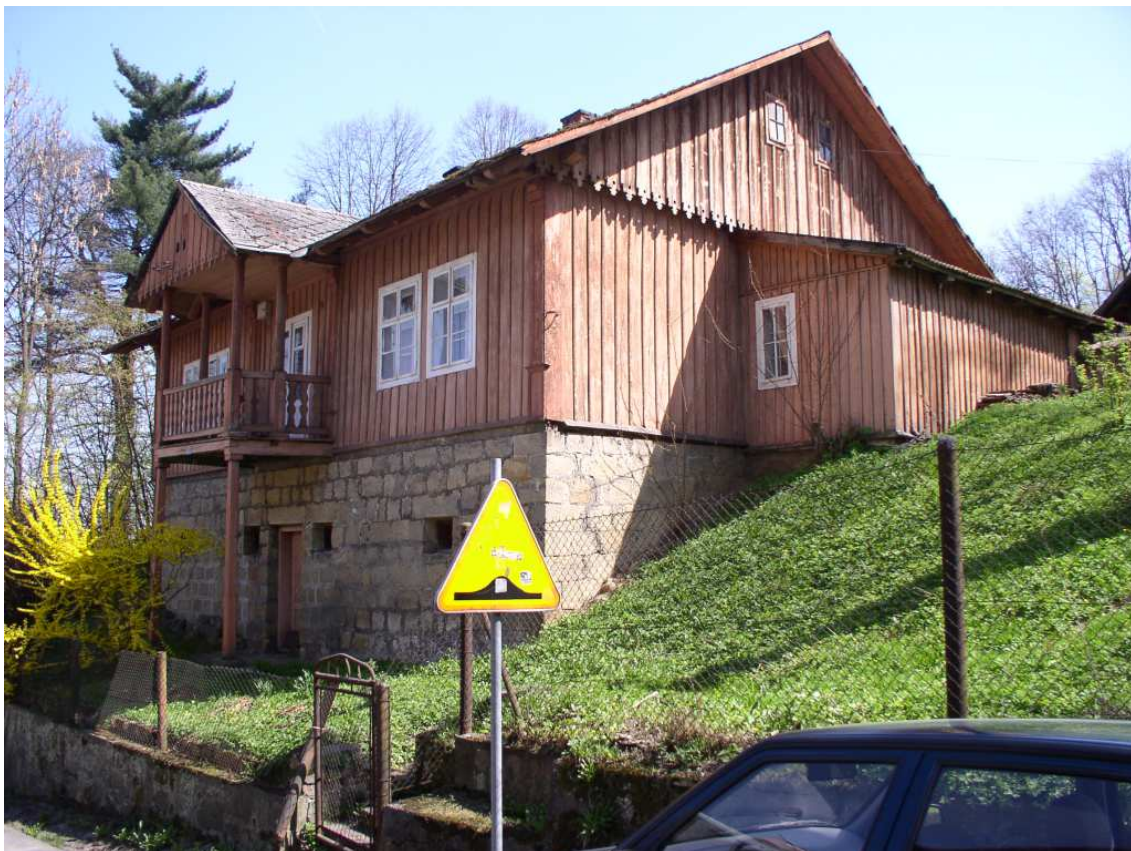
Fot. nr 76 (76-79). Oryginalna, drewniana willa z ulicy Kazimierza Wielkiego 6, która mogła powstać gdzieś w okolicy II dekady XX wieku. Stan z oryginalnymi jeszcze oknami. (15.04.2009)
