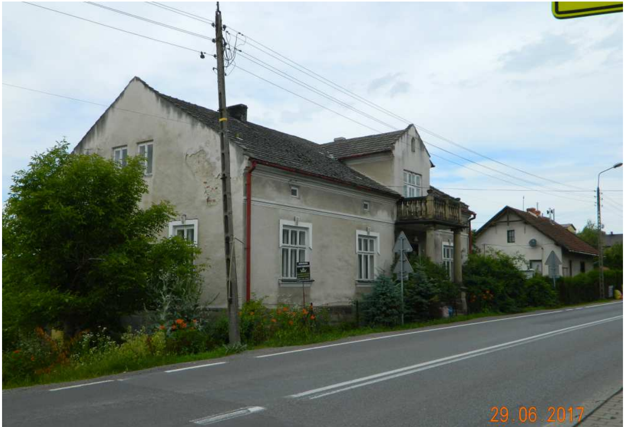
Fot. nr 229 (229-232). Zapewne przedojenny dom spod nr 8.
