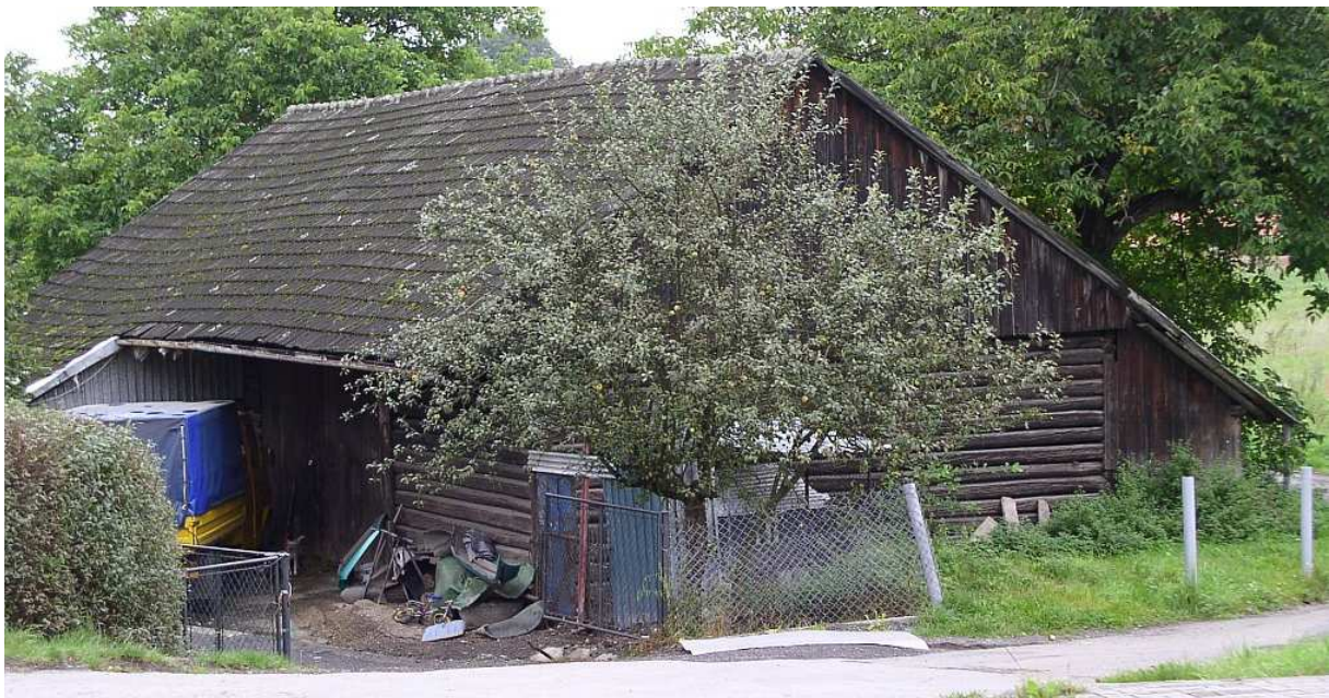
Fot. nr 26. Stodoła typowa dla lat przedwojennych i jeszcze wcześniejszych. Uwagę zwraca poprzecznie belkowa faktura uszczelniana słomianymi warkoczami. (12.09.2010)
