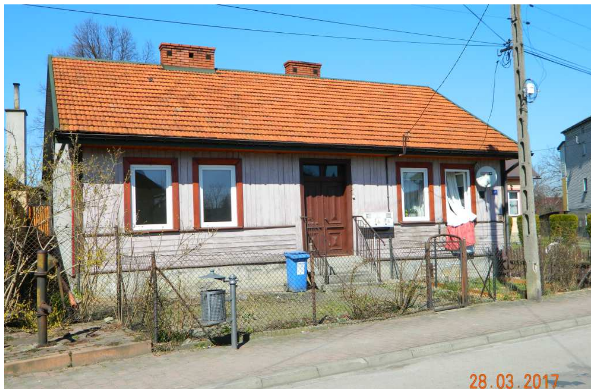
Fot. nr 38. Pozbawiony już oryginalnej stolarki okiennej stary dom z ulicy Piłsudskiego 18, który mógł powstać na początku XX wieku.
