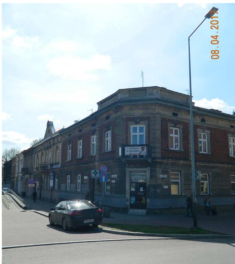
Fot. nr 62. Fragment zabudowy ulicy Konopnickiej (nr: 3-11) z końca XIX wieku.
