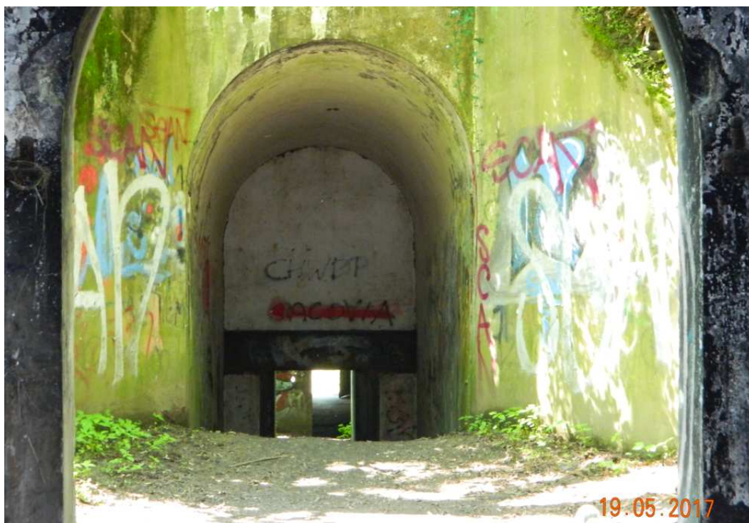
Fot. nr 180. Przejście pod schronem głównym – widok w stronę koszar.
