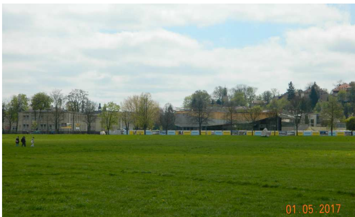
Fot. nr 21. Trwa zabudowa końcowego fragmentu Alei Focha, gdzie powstaje hala sportowa Comarchu-Cracovii.
