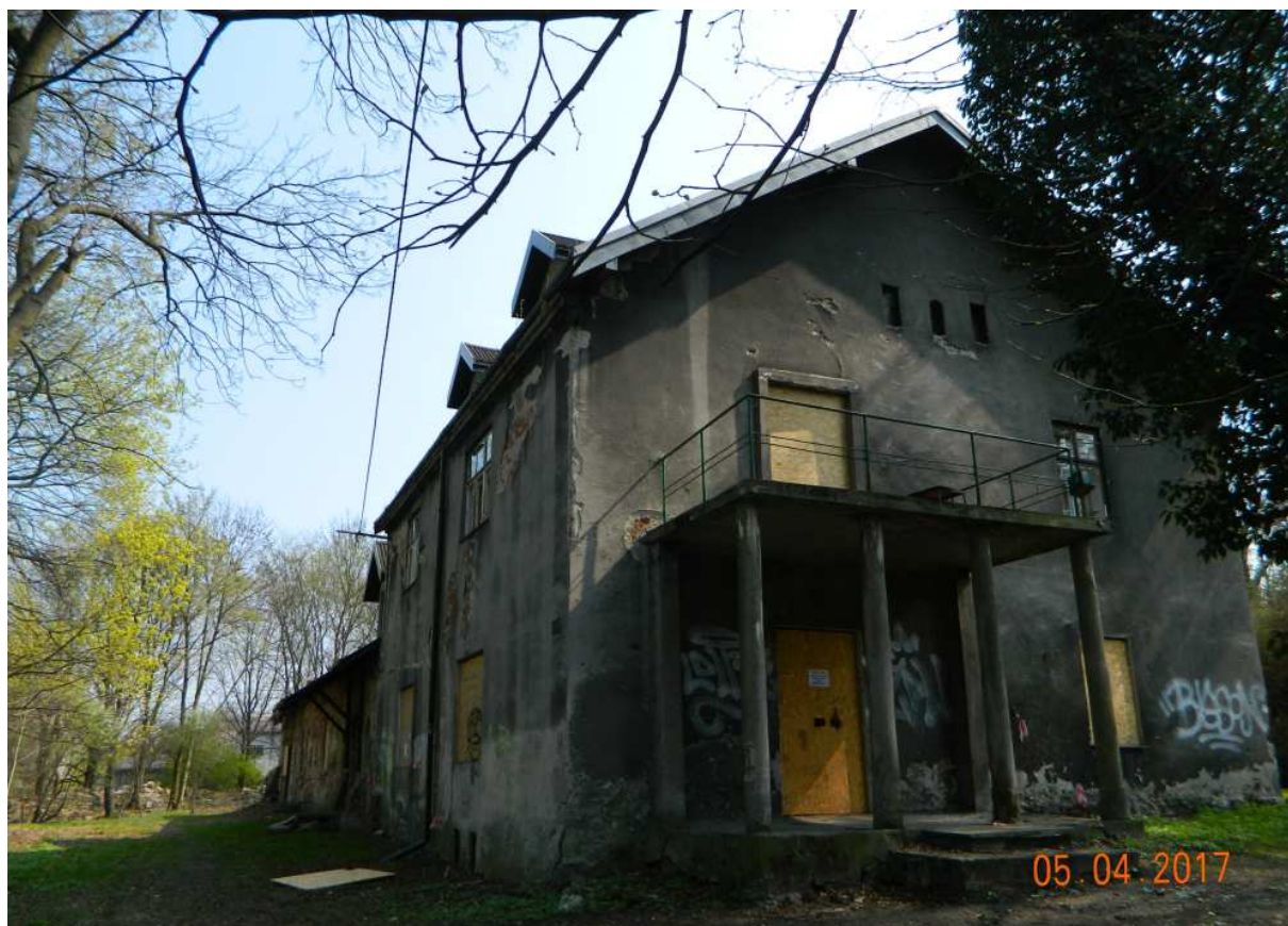
Fot. nr 116. Widok z drogi dojazdowej do dworu od strony ulicy Estońskiej..
