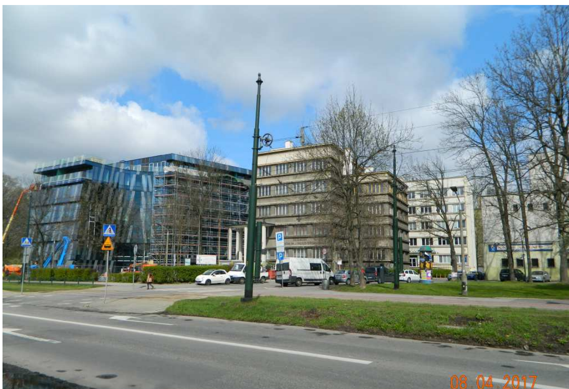
Fot. nr 6 (6-7). Krzywy dom, który powstaje w miejscu gmachu Petroinformu, przybiera realne kształty.
