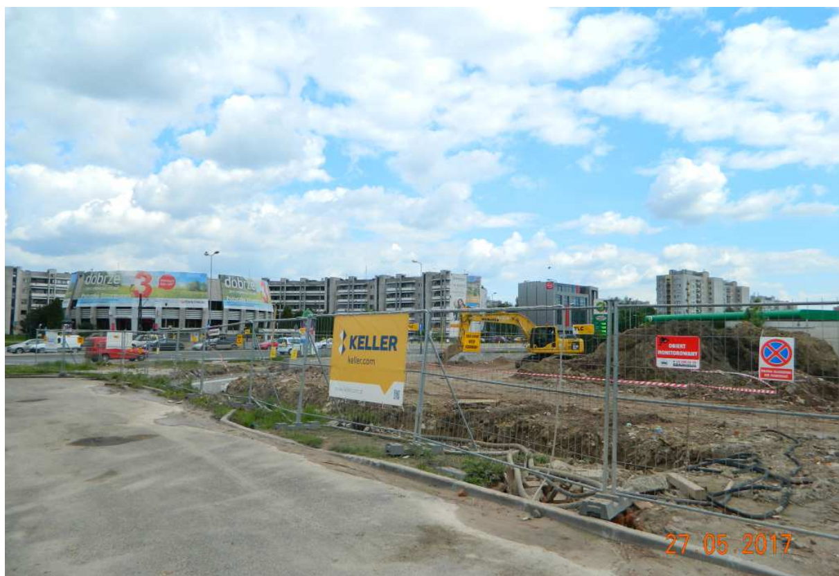
Fot. nr 89. Nowy plac budowy we fragmencie na styku ulic: Gen. Zielińskiego i Kapelanka.
