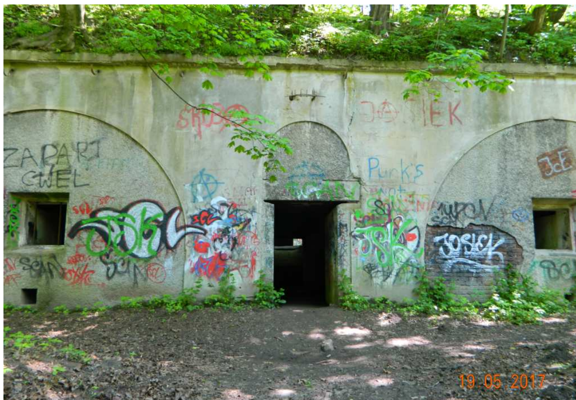
Fot. nr 178. Wejście do schronu.
