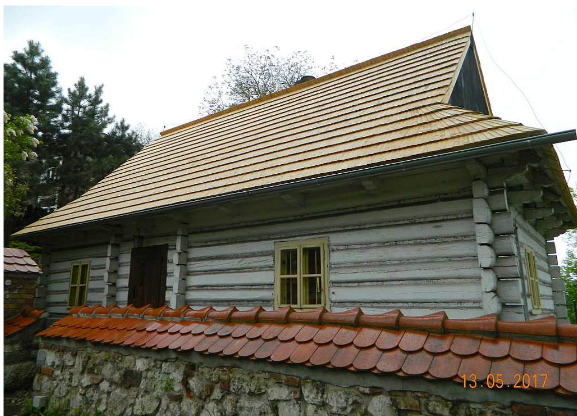
Fot. nr 29 (29-31). Zrekonstruowana kilka dekad temu chatka grabarza, który kiedyś obsługiwał cmentarz przy kościele św. Salwatora.
