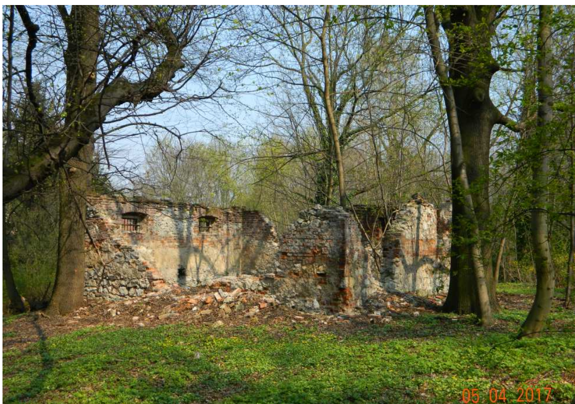
Fot. nr 114. Ruina budynku gospodarczego dawnego folwarku Duchaków przy starym Dworze Bemów – widok od strony ulicy Estońskiej.
