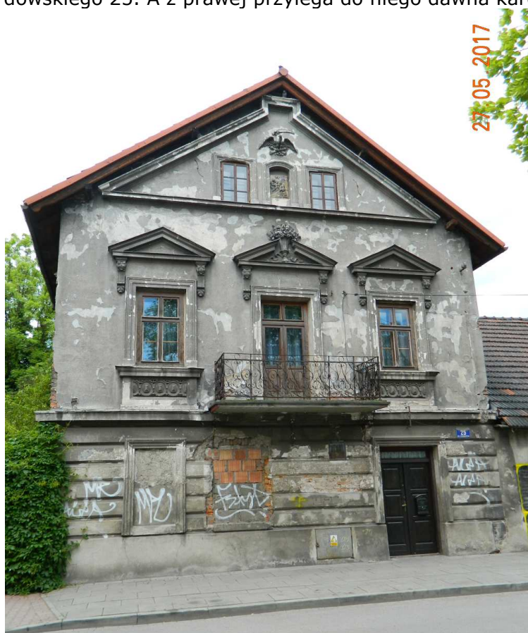
Fot. nr 75. Fasada dworu.
