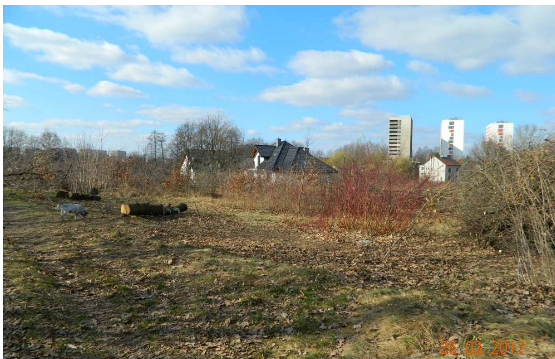
Fot. nr 130 (130-133). Współczesny plac budowy na terenie dawnych pól z pogranicza Piasków Wielkich i Prokocimia na styku ulic: Mokrej i Obronnej. Oczywiście i tutaj widać efekty obowiązywania Ustawy Szyszki. W tle akademiki UJ z ulicy Badurskiego.
