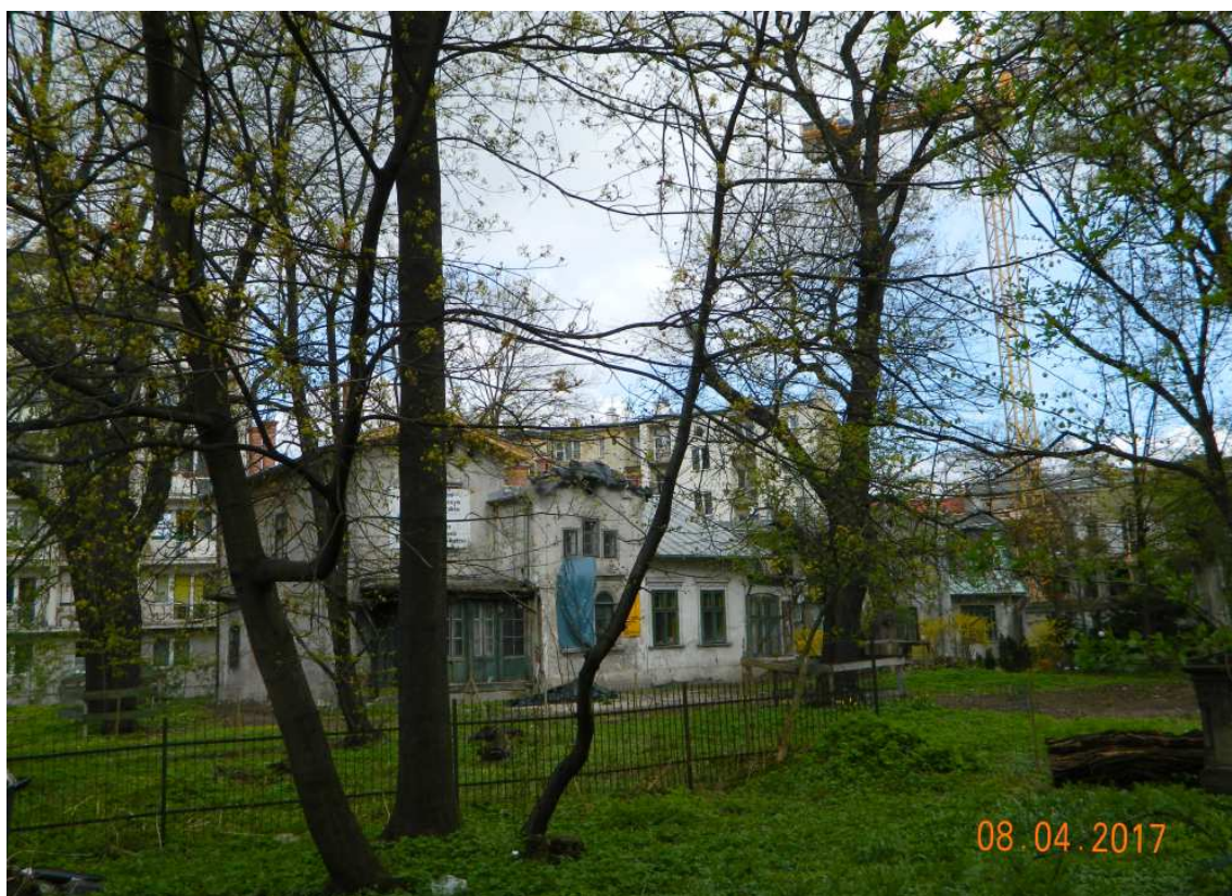
Fot. nr 2 (2-5). W Kossakówce wreszcie coś drgnęło. Trwa jej remont.
