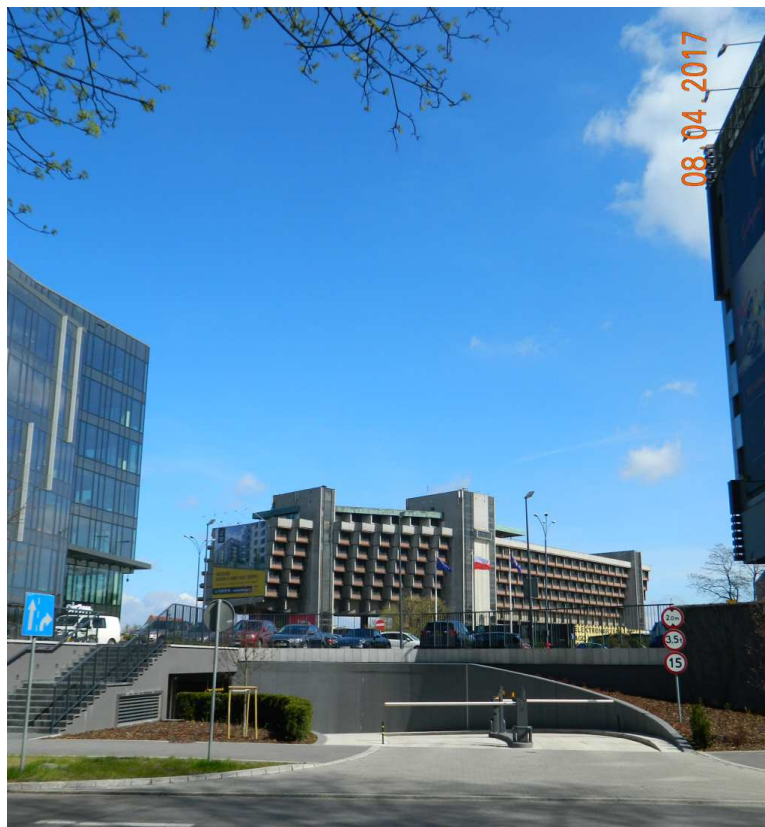
Fot. nr 104. Widok dawnego hotelu od strony Osiedla Podwawelskiego.
