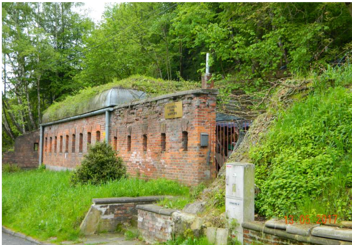
Fot. nr 36. Ostróg i fragment muru strzelniczego, czyli pozostałość po zespole bramnym 3b fortu Kościuszko, zlokalizowanym pośrodku ulicy Hofmana.
