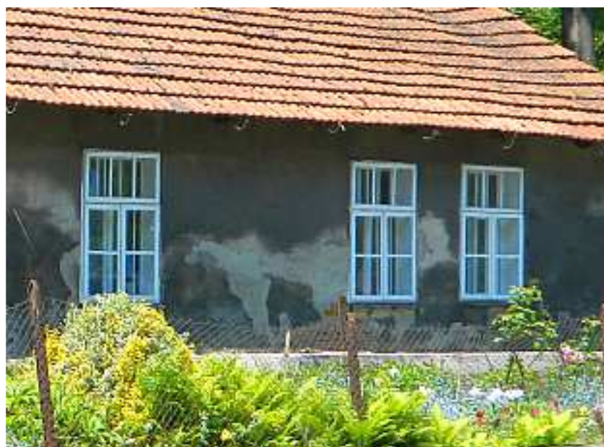
Fot. nr 161. Oryginalna stolarka okienna sprzed około 90 lat.
