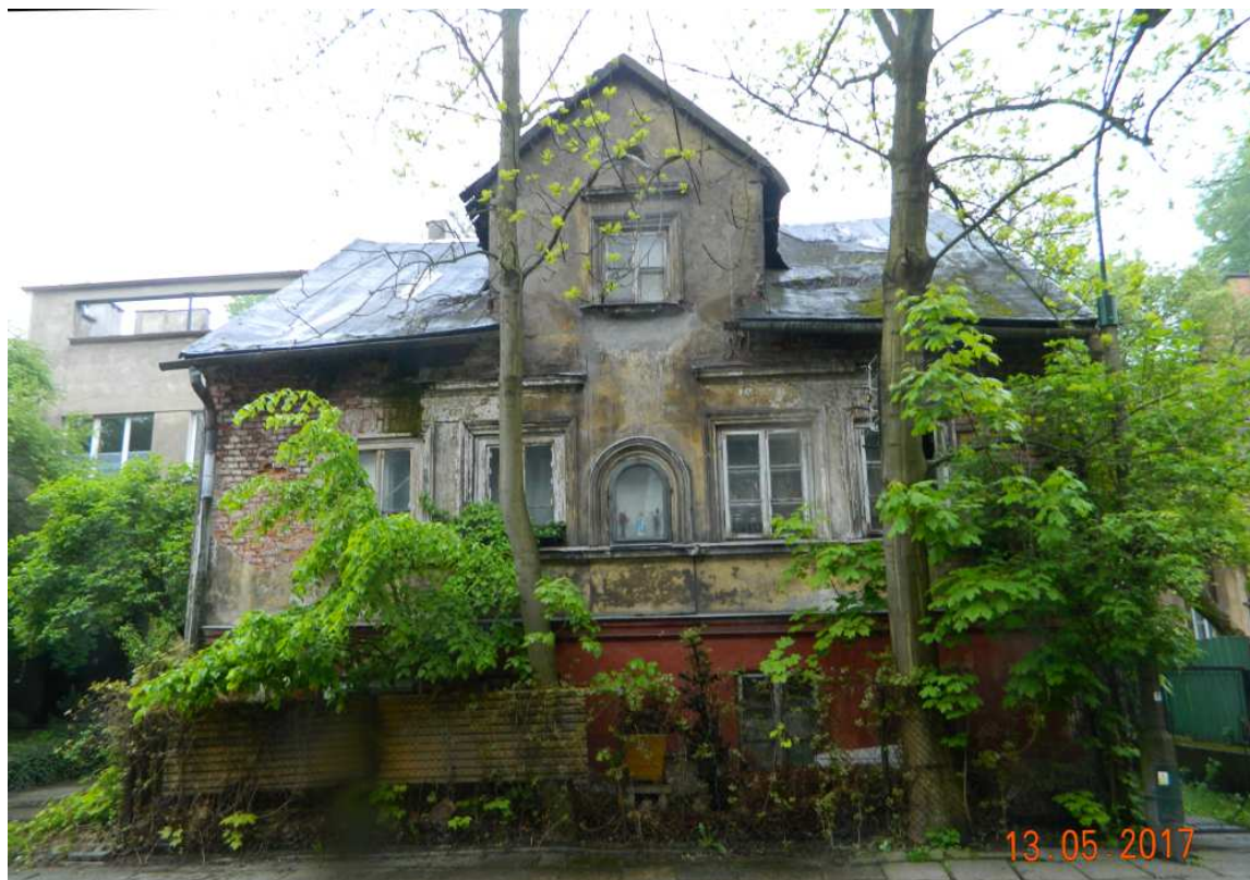
Fot. nr 55 (55-56). Kolejny relikw dawnej zabudowy ulicy Królowej Jadwigi (nr 24), który zapewne też niebawem zniknie. To przykład klasycystycznej zabudowy z końca XIX wieku
