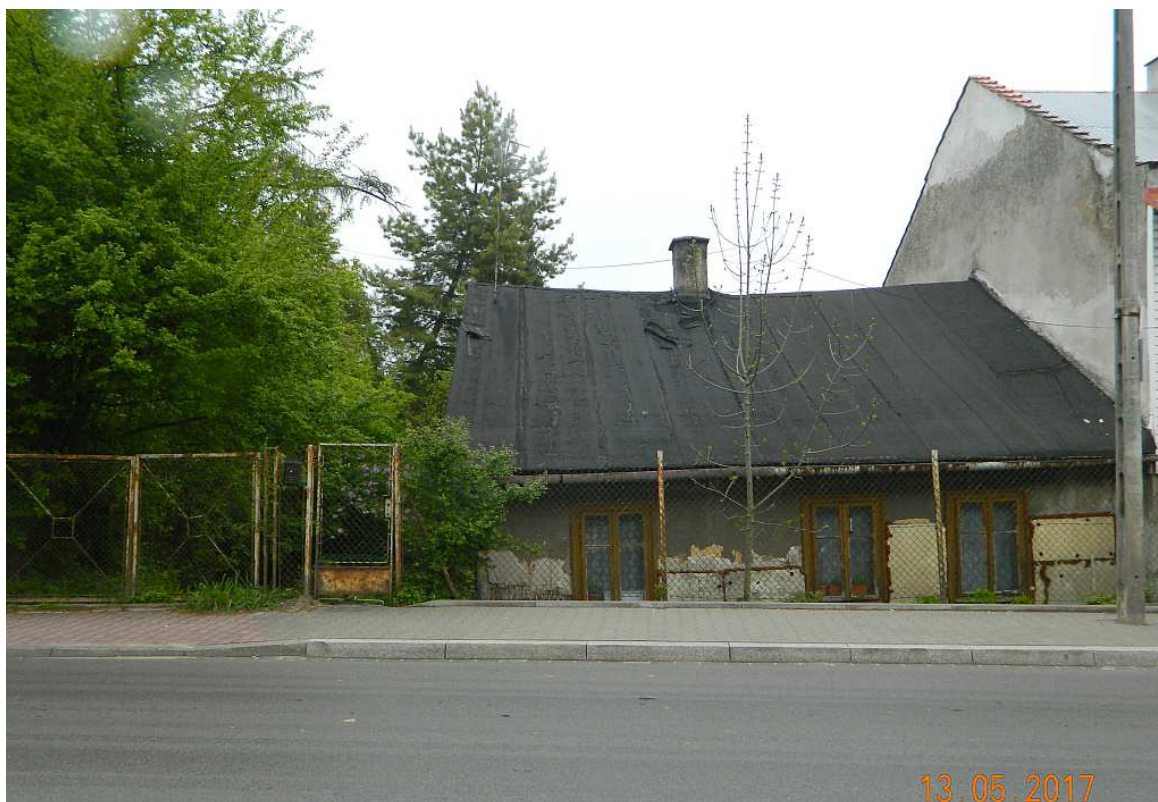
Fot. nr 39 (39-39a). Chatka z ulicy Królowej Jadwigi 127, która mogła powstać nawet w okolicy połowy XIX wieku. Czy przetrwa, czy raczej podzieli los innych chałup i starych domów z ulicy Królowej Jadwigi? Wiekowej Pani Czesi M. ani jej pasa kudłatego psa już nie widać w oknie a ni na ogrodzie.
