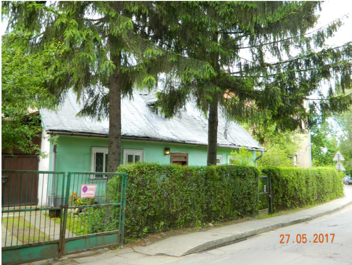
Fot. nr 82. Międzywojenny dom z ulicy Bocznej 11. Jeszcze trwa.
