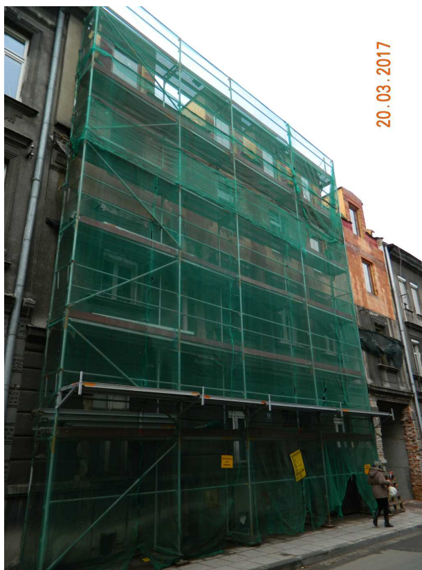
Fot. nr 149. Właśnie powstaje nadbudówka do piętrowego domu z ulicy Chodkiewicza 15, który powstał około 1900 roku
