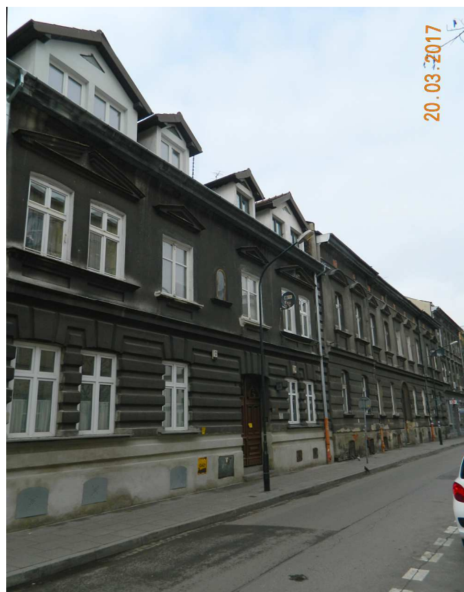
Fot. nr 151. Typowo podmiejska zabudowa fragmentu ulicy Chodkiewicza o numerach: 19-21, pochodząca z przełomu wieków XIX i XX. I tych domów nie omijają dobudówki.
