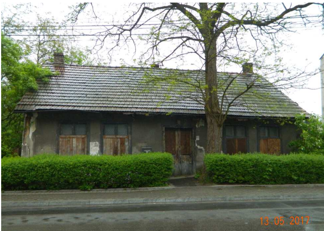
Fot. nr 50. Dawny dom Jana Florczyka, zwierzynieckiego mistrza budowlanego, z ulicy Królowej Jadwigi 43. I on najpewniej niebawem zniknie.
