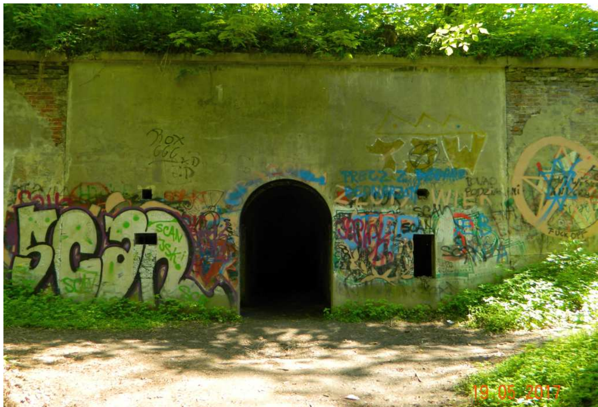
Fot. nr 182 (182-183). Tunel od strony schronu głównego do kaponiery środkowej.
