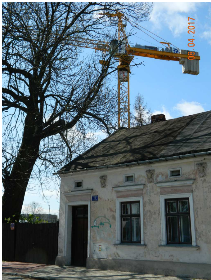
Fot. nr 68. Dom z ul. Kilińskiego 13, wybudowany na początku XX wieku– pełny oryginał.
