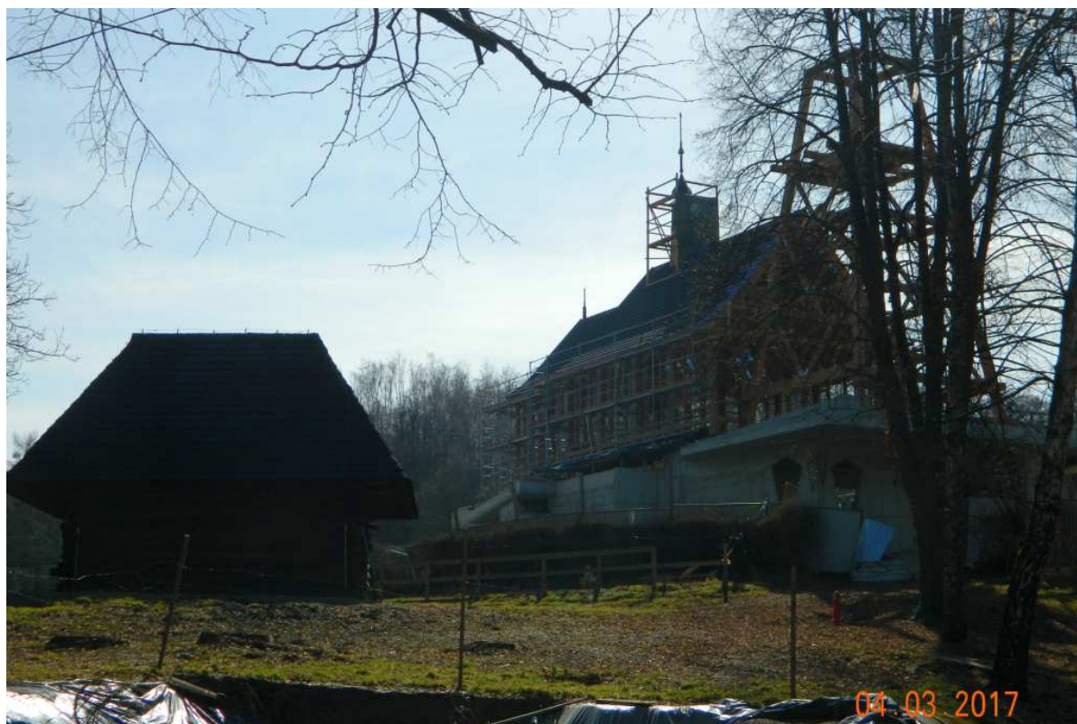
Fot. nr 98 (98-102). Pomimo protestów i batalii sądowych rozpoczęła się budowa murowanego kościoła w miejscu dwukrotnie spalonych, drewnianych obiektów.
