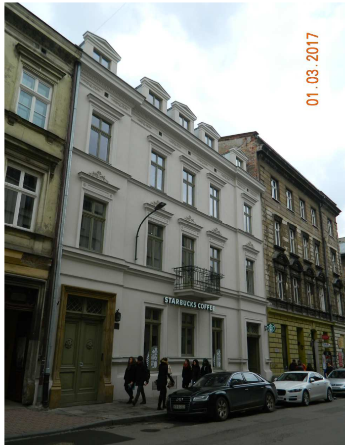
Fot. nr 58. Świeżo odnowiona i zgrabnie nadbudowana kamienica z ulicy Krupniczej 10.
