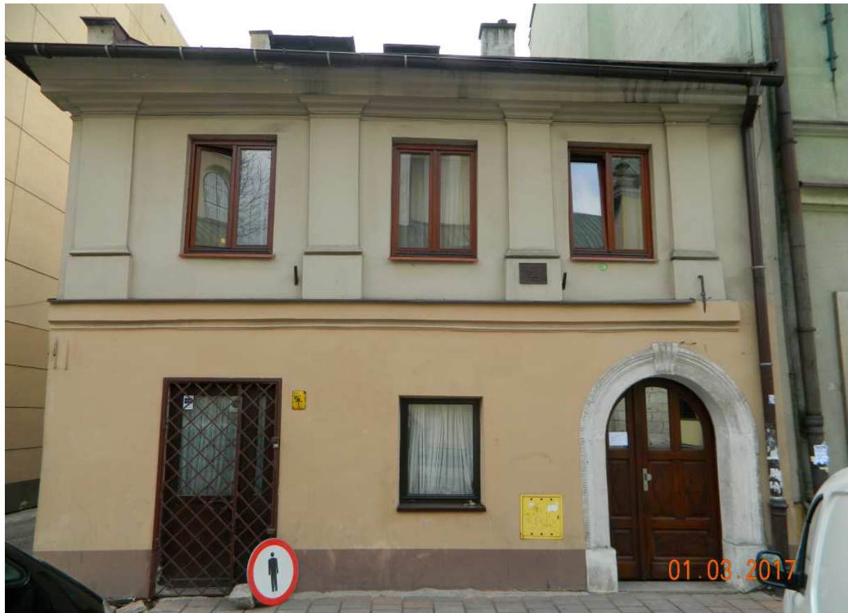
Fot. nr 44 (44-45). Dom z ulicy Garbarskiej 22, którego początek sięga roku 1826.
