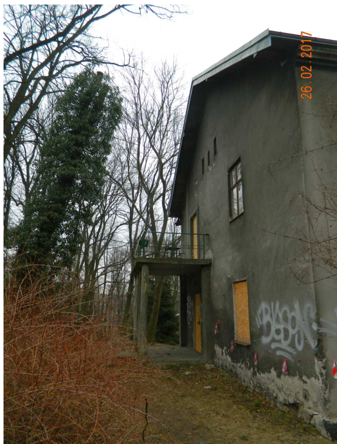
Fot. nr 153. Ściana boczna dworu od strony ulicy Estońskiej.
