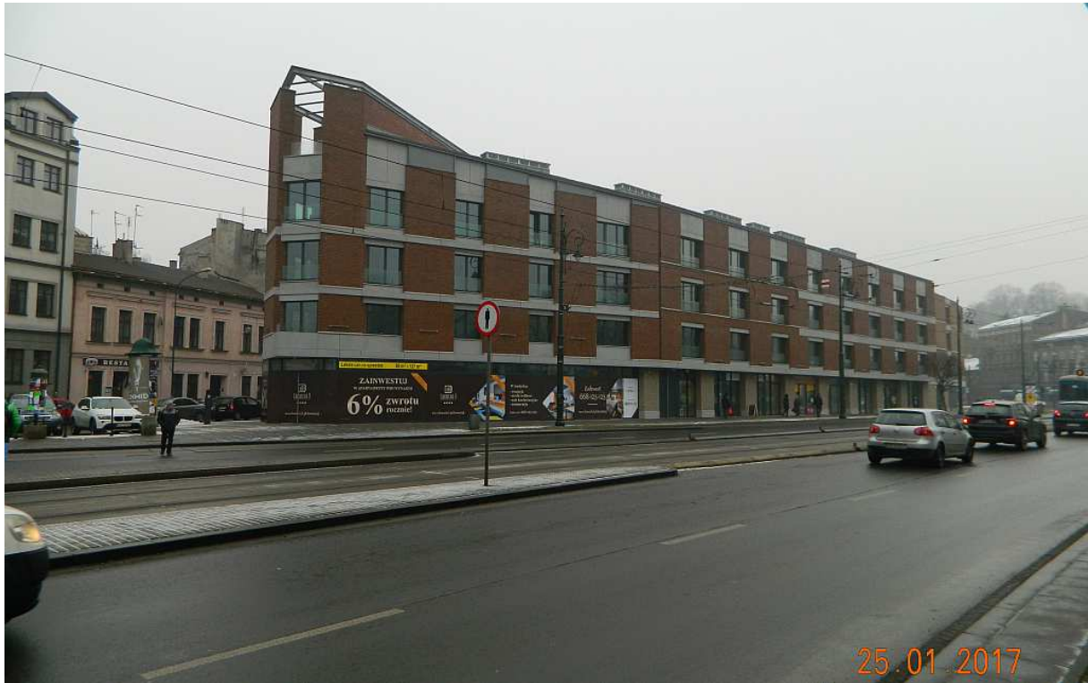
Fot. nr 122 (122-123). Nowy gmach na początku ulicy Na Zjeździe, który powstał za sprawą zamiany gruntów miejskich za teren Parku Duchackiego.
