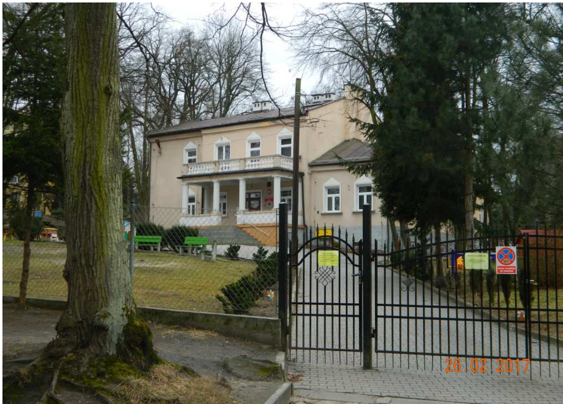
Fot. nr 142. Nowy dwór Bemów przy ulicy Estońskiej 2.
