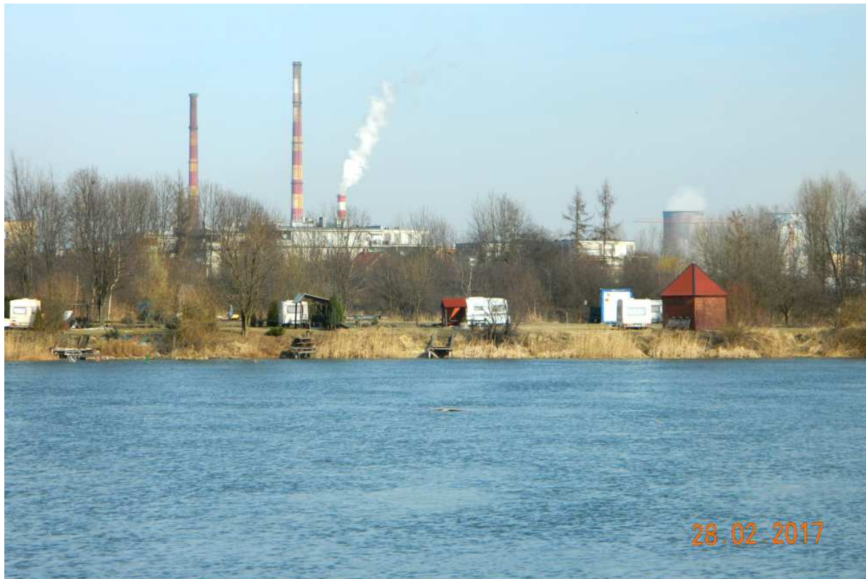
Fot. nr 182. W stronę elektrociepłowni w Łęgu.
