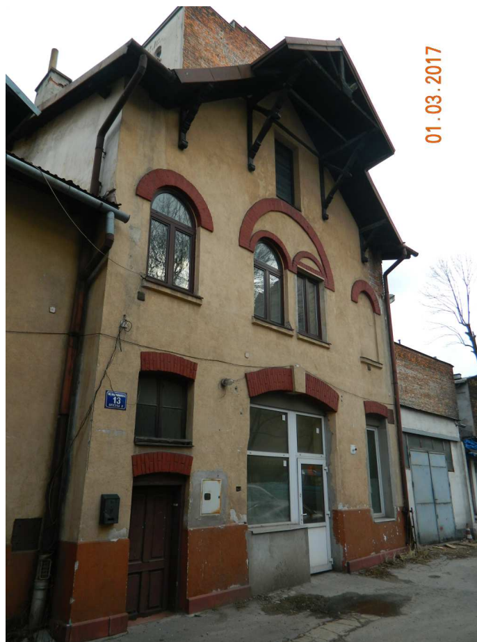
Fot. nr 46. Oficyna domu przy ulicy Karmelickiej 13, która sąsiaduje z domem przy ulicy Garbarskiej 22.
