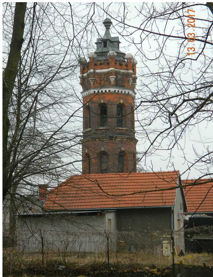
Fot. nr 237. Stylowa, ale bardzo zaniedbana wieża ciśnień z dawnego majątku.
