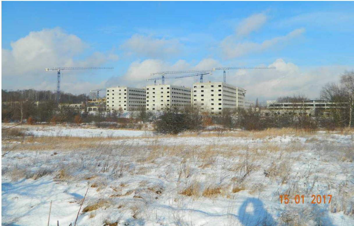
Fot. nr 320 (320-322). Widoki na plac budowy centrum medycznego AM od strony osiedla Rząka i ulicy Kosocickiej.
