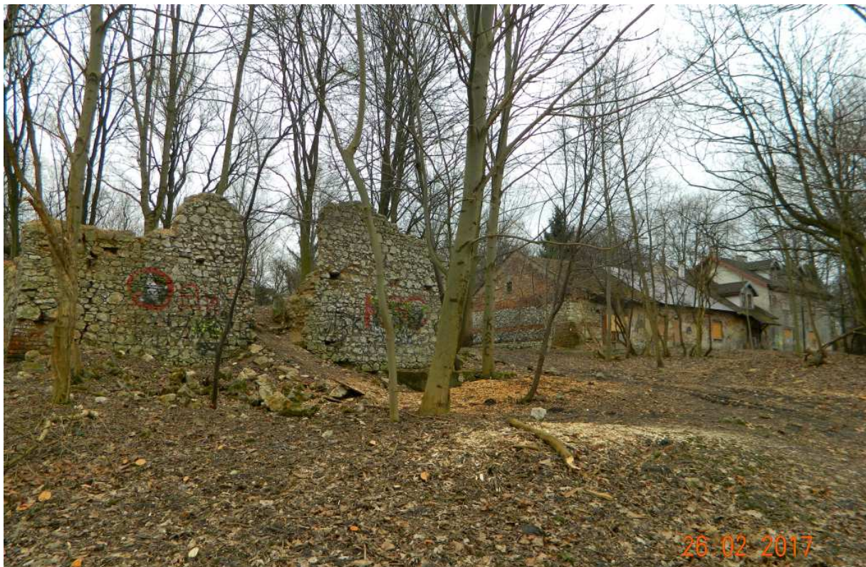
Fot. nr 167 (167-169). Ruina zabudowania gospodarczego w sąsiedztwie ulicy Albańskiej.
