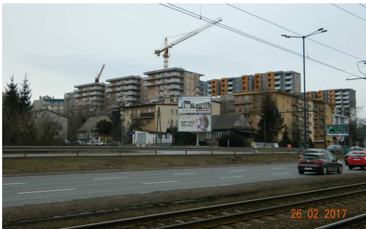
Fot. nr 225 (225-226). Trwa również rozbudowa osiedla mieszkaniowego na terenie dawnych zakładów zabawkarskich przy ulicy Polonijnej – widoki z ulicy Wielickiej.
