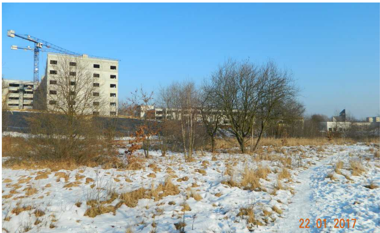
Fot. nr 313 (313-318). Plac budowy nowego centrum Medycznego AM – widoki z ulicy Słona Woda.
