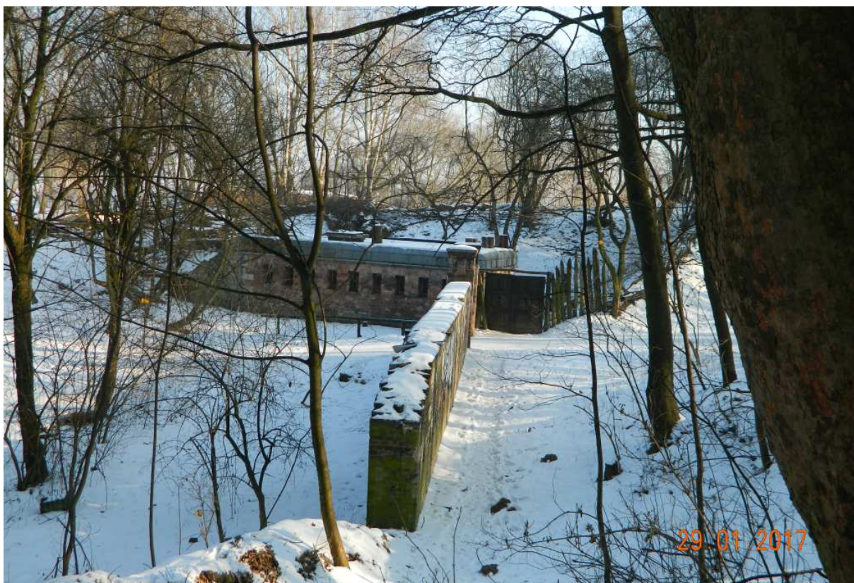
Fot. nr 84 (84-84a). Pozostałości zespołu bramnego ca fortu Kościuszko na styku ulic: Hofmana i Maleckiego.
