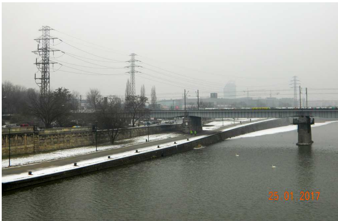
Fot. nr 111. Widok z III mostu (Powstańców Śląskich) na okolice Bulwaru Kurlandzkiego.
