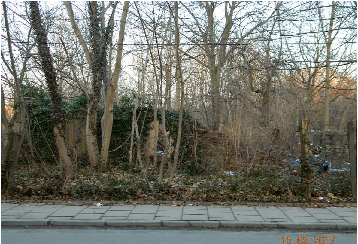
Fot. nr 372. Pokryta bluszczem ruina drewnianego domu na styku ulic: Ułanów i Fiołkowej.
