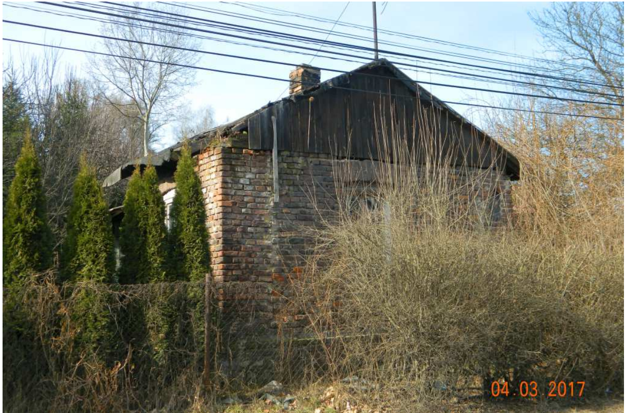
Fot. nr 108 (108-109). Dawna zabudowa ulicy Starowolskiej. Tu pozostałości po budynku spod nr 11.
