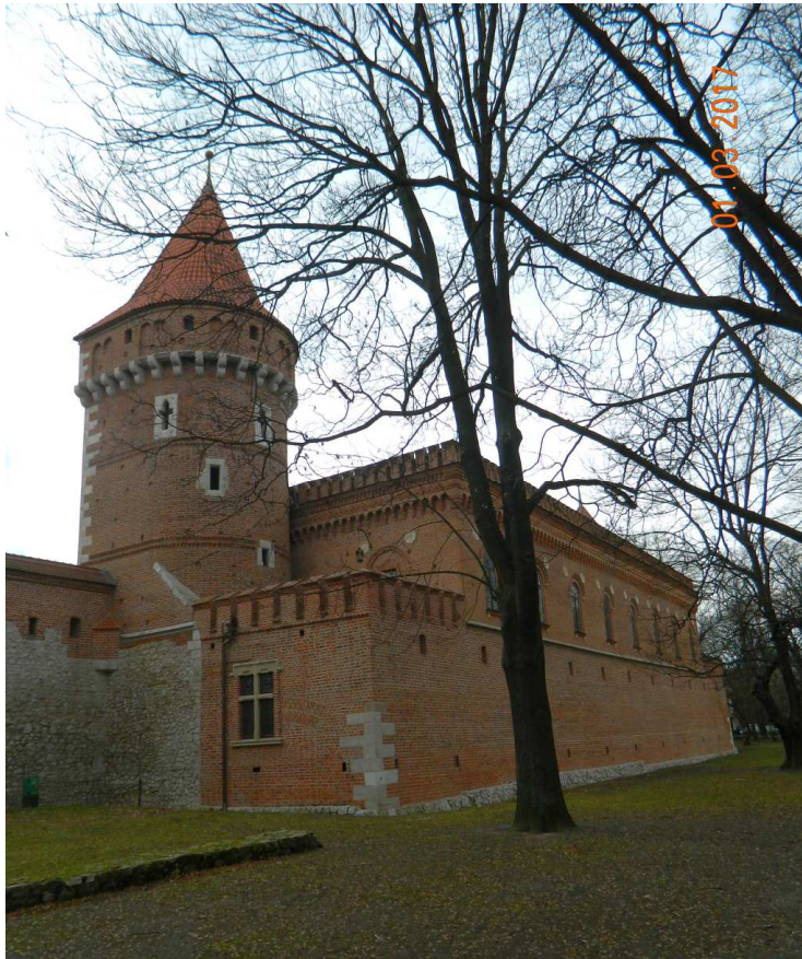
Fot. nr 28 (28-29). Fragment murów floriańskich w wieżami: Stolarska i Ciesielską oraz (pośrodku) Arsenalem Miejskim.
