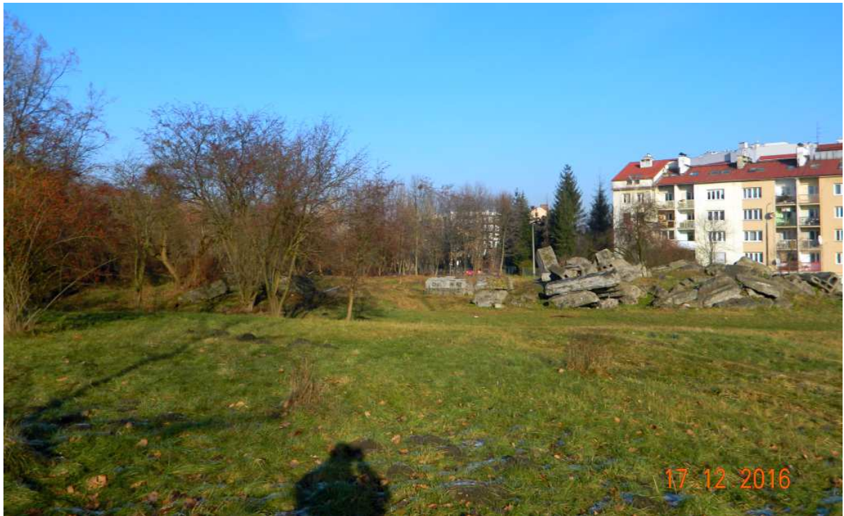
Fot. nr 126. Ruina przedwojennego, żydowskiego domu pogrzebowego w sąsiedztwie ulicy Jerozolimskiej.
