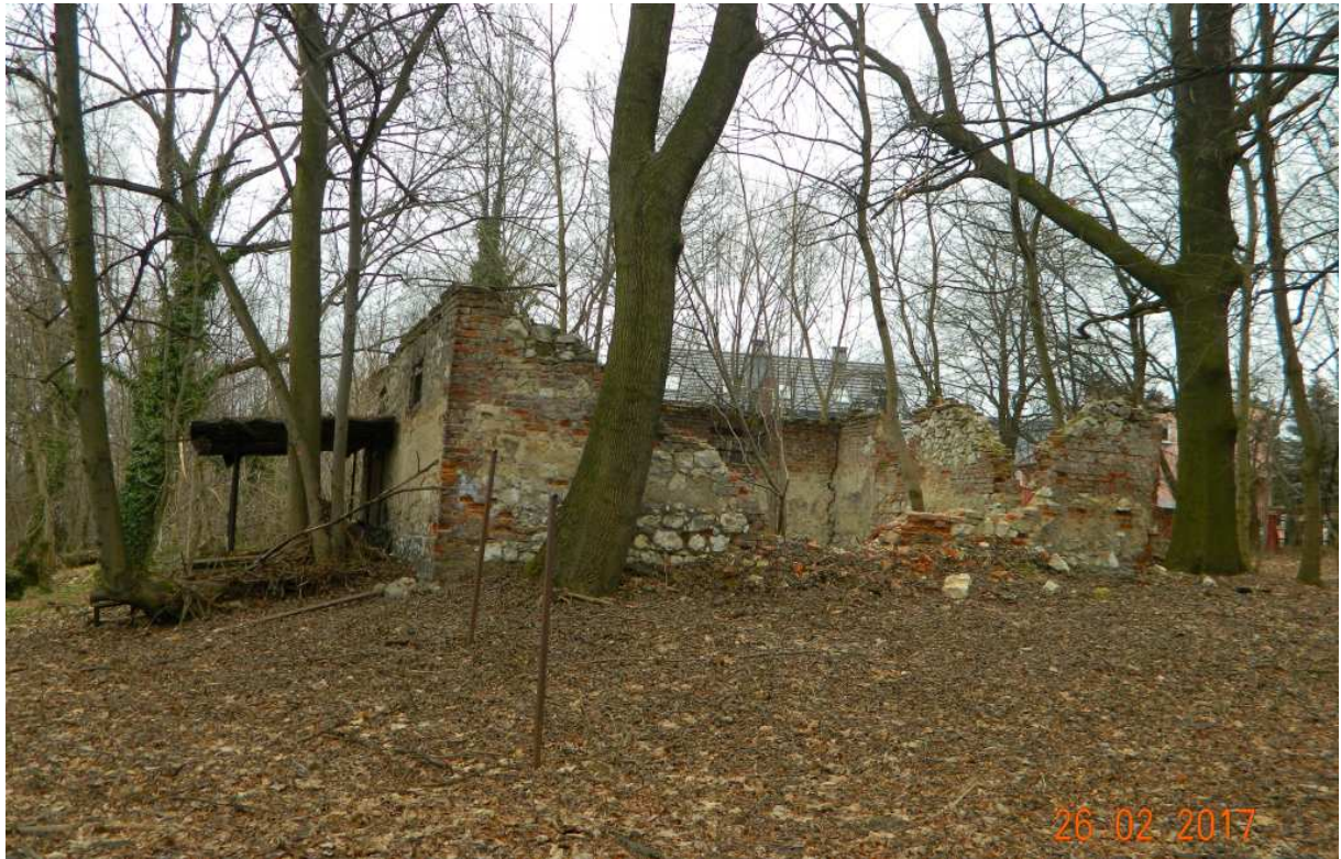
Fot. nr 148 (148-149). Ruina zabudowania gospodarczego naprzeciw nowego dworu Bemów.
