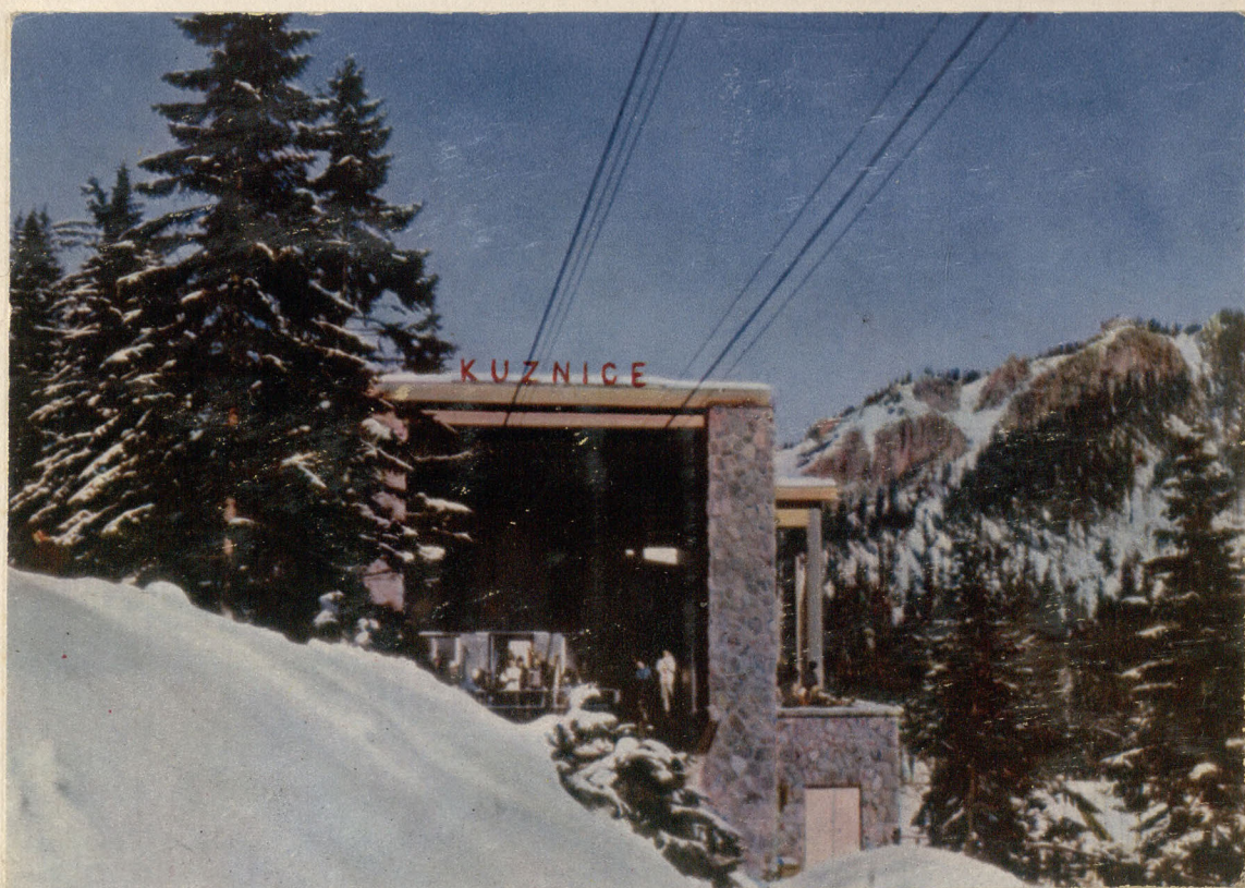
Kuźnice - stacja kolejki linowej
