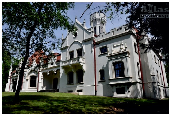
Pałac w Gorajowicach – stan obecny
