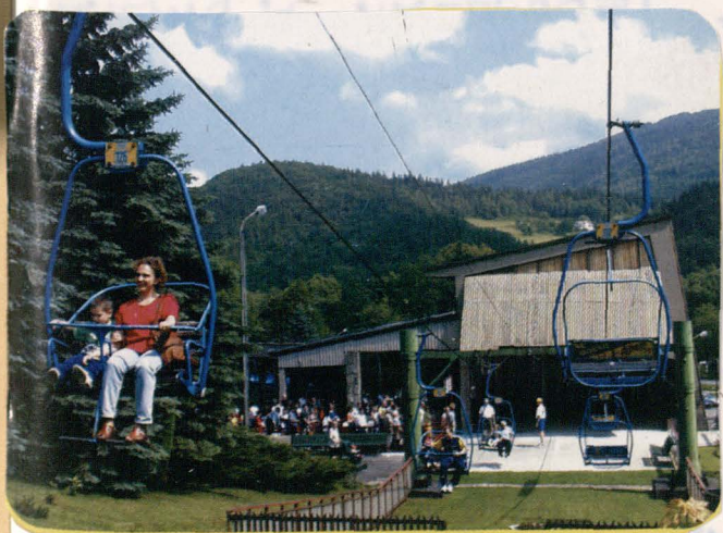
Widok na peron wyjazdowy stacji dolnej
