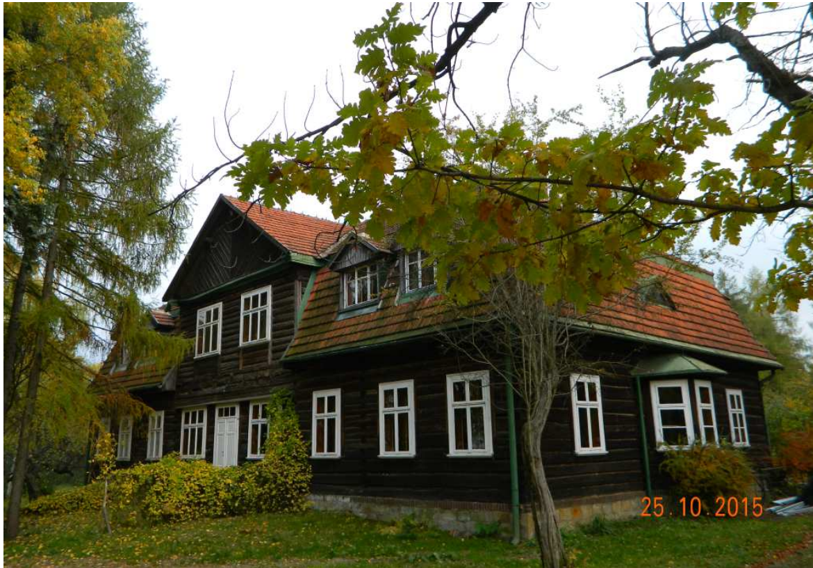
Fot. nr 40. Tylna część budynku dworskiego.
