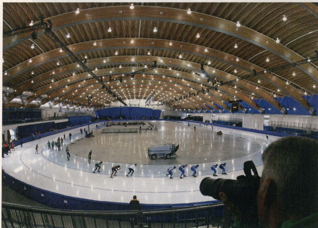
Dach nad torem Richmond Olympic Oval. Zamiast wycinać zdrowy las drewno uzyskano z chorych sosen
