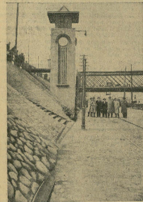
Samoczynny wodowskaz elektryczny, ustawiony powyżej mostu Kierbedzia w Warszawie.
