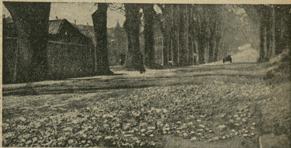
Szoza wysypana ostrymi, a nie ugniecionymi kamieniami, szczególnie niszczy opony gumowe samochodów.
