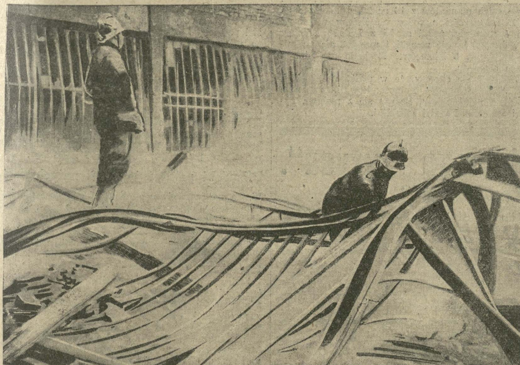
Konstrukcje żelazne powyginane żarem.
