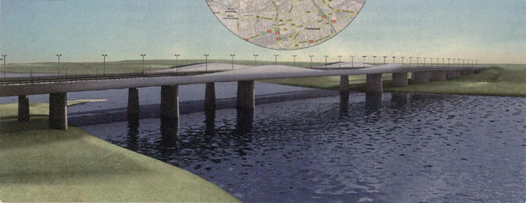
Planowany most Północny w Warszawie
