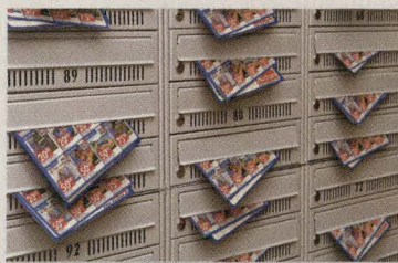
To, czy skrzynka zostanie wymieniona na nową, zależy od wspólnoty mieszkaniowej
