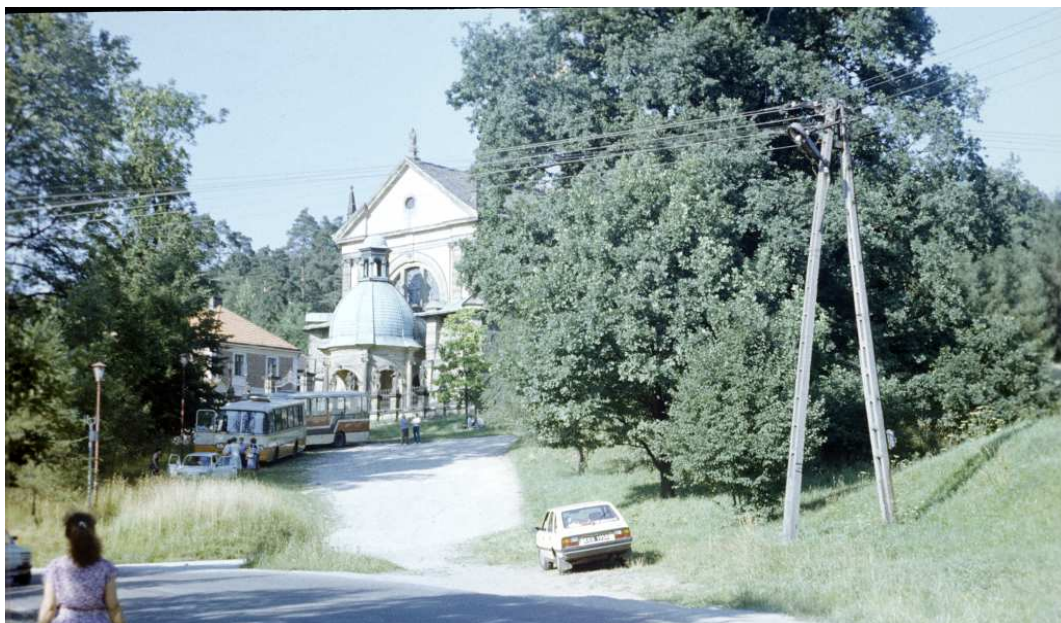
Fot. nr 160 (160-161). Fragmenty kościoła Bernardynów. Lato 1990.
