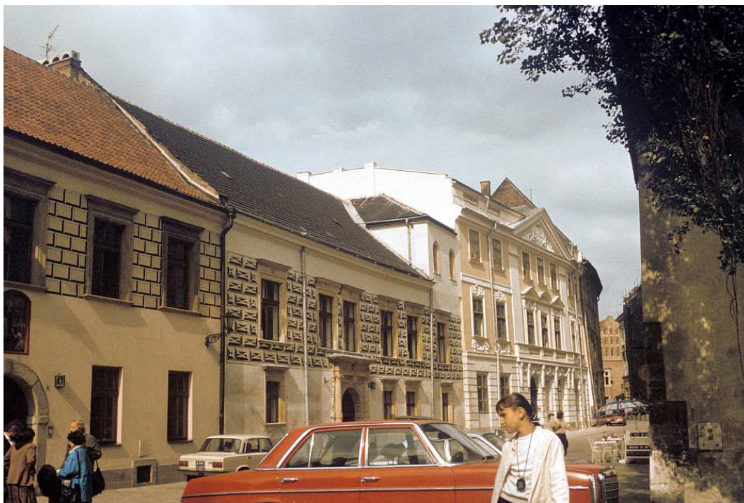
Fot. nr 14 (14-16). Końcowy fragment ulicy Kanoniczej – widoki od strony Wawelu i ulicy Podzamcze. Lato 1992.
