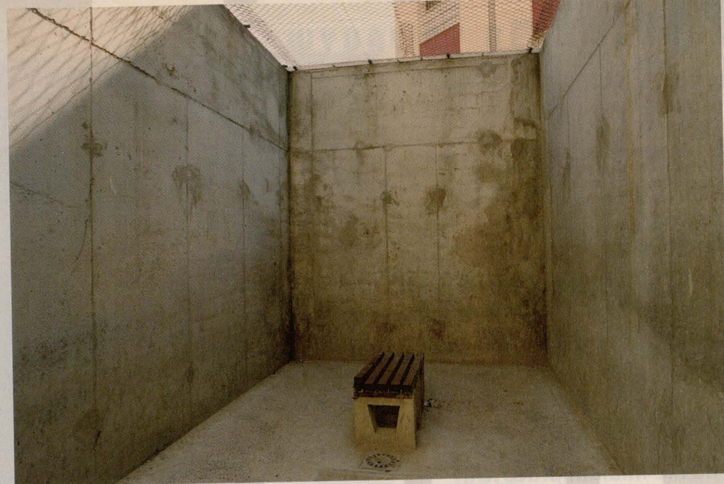
Ściany spacernika są z surowego betonu i mają 3,5 metra wysokości
