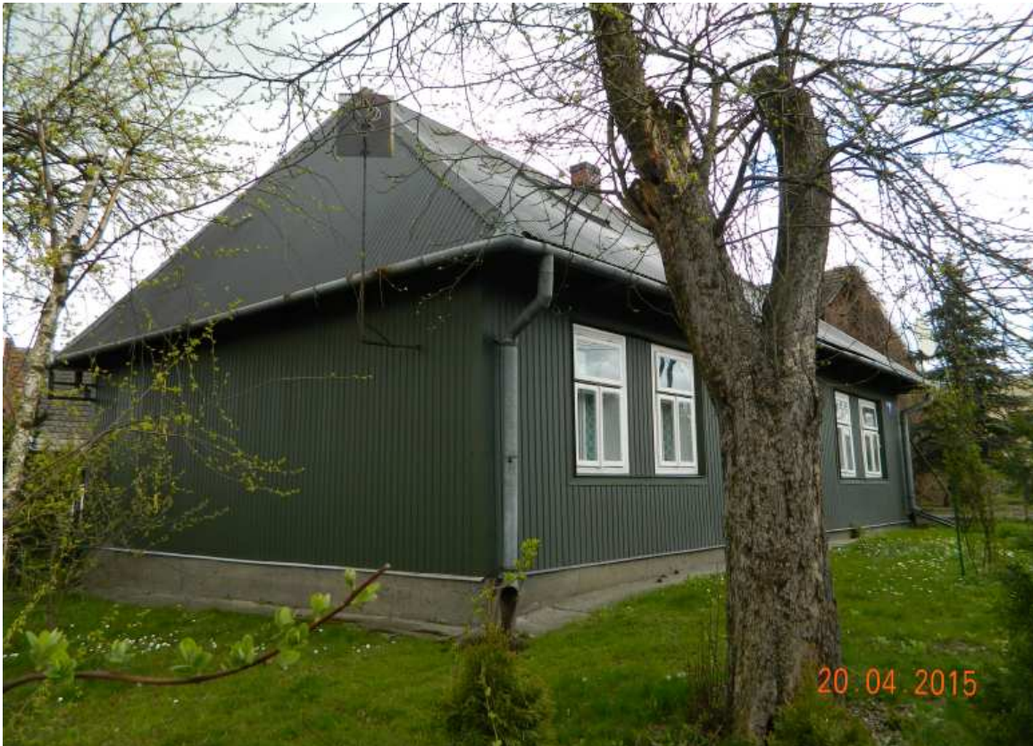
Fot. nr 177 (177-178). Ukryty pod sidingiem, zapewne przedwojenny dom spod nr 3, w którym zachowały się jedynie oryginalne okna.
