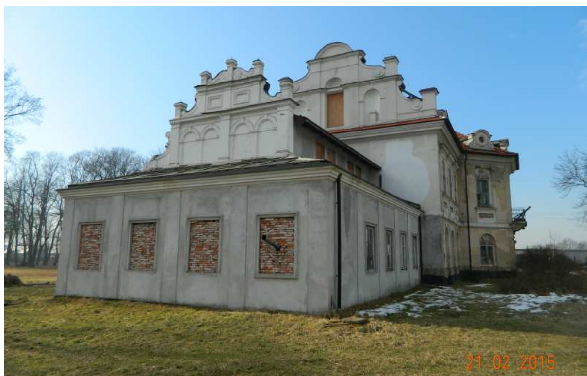
Fot. nr 208. Lewą, boczną ścianą.
