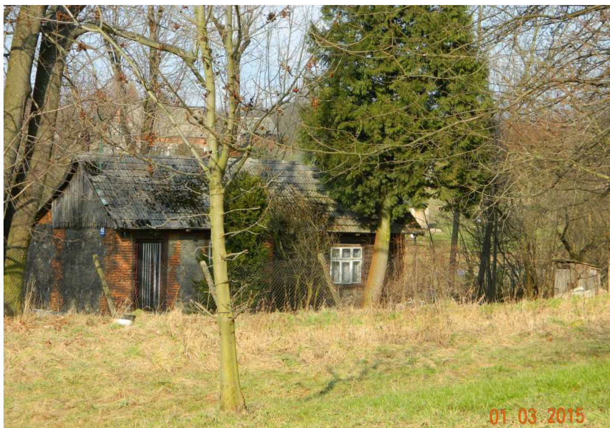
Fot. nr 254 (254-257). Przebudowywany i rozbudowywany dom pod nr 43.
