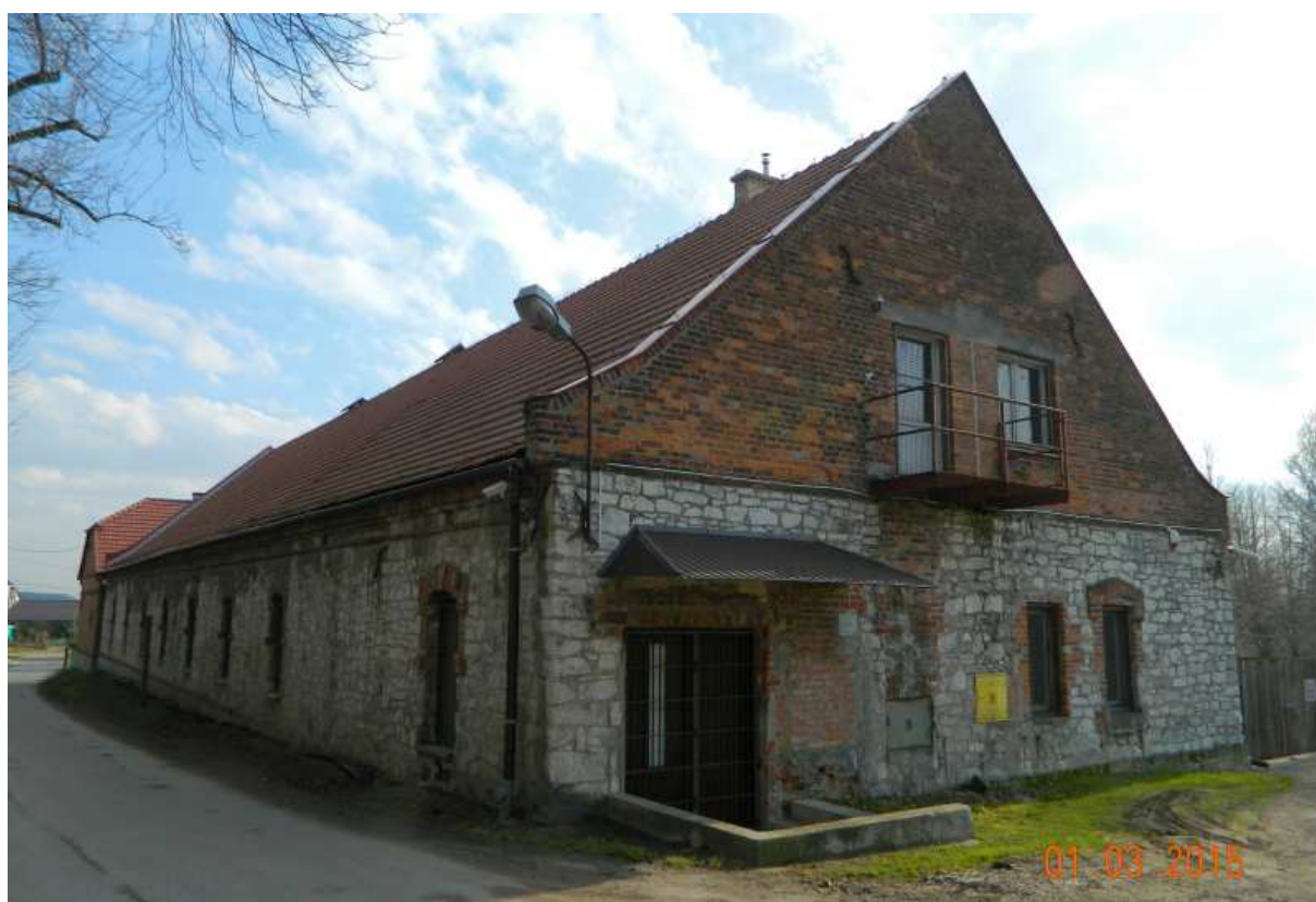
Fot. nr 228. Budynek gospodarczy przynależny do dawnego dworskiego folwarku.
