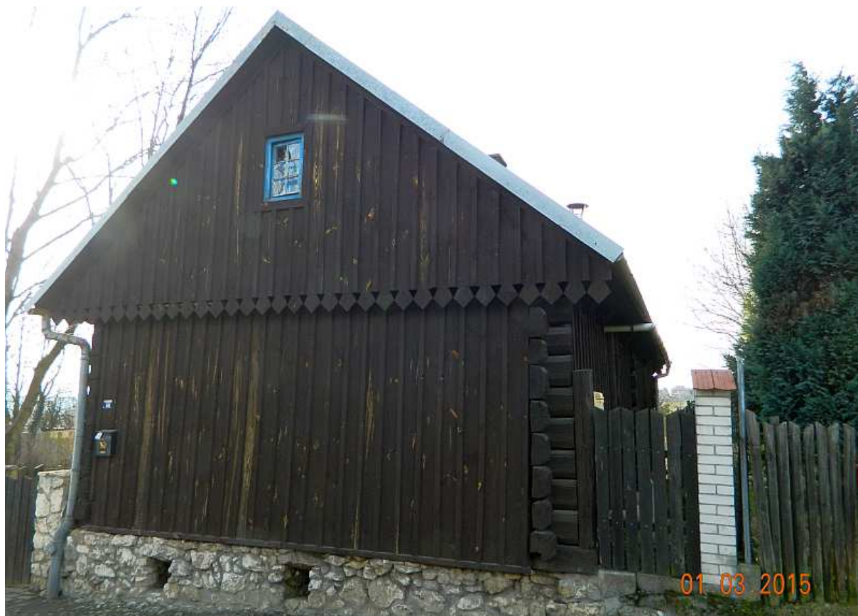
Fot. nr 245. Boczna ściana pokryta boazerią.
