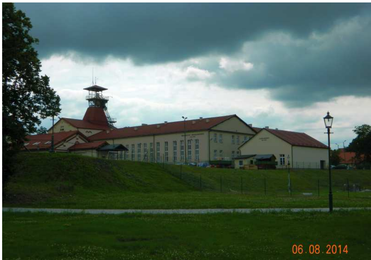
Fot. nr 32 (32-34). Budynki KSW (od klewej): szybu św. Kingi, warsztatu mechanicznego, parowozowni i stolarni – widoki z parku.
