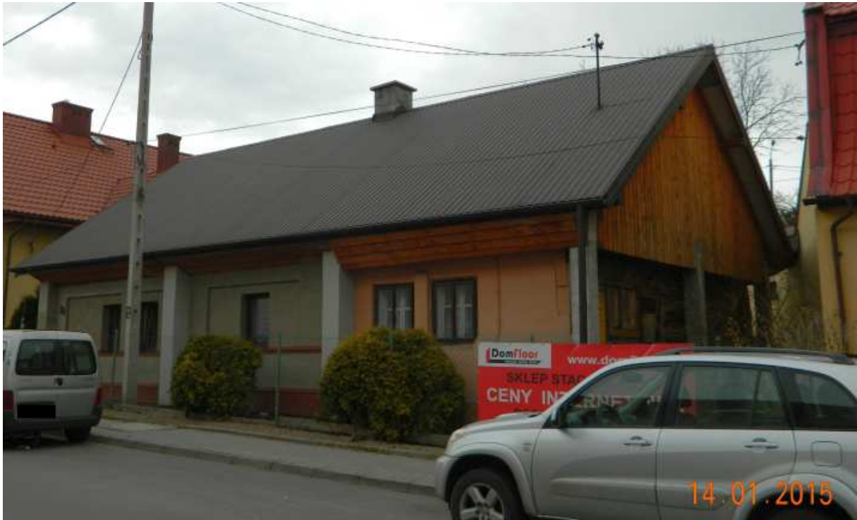
Fot. nr 48. Mocno już przebudowana dawna chałupa z ulicy Kosiby 22.
