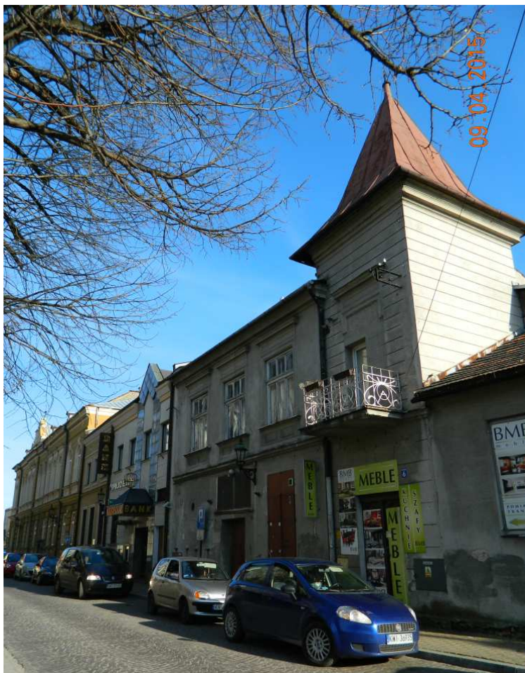
Fot. nr 117 (117-118). Eklektyczna kamienica pod nr 8.
