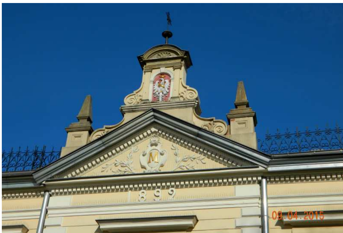
Fot. nr 72. Tympanon nad dawnym wejściem.
