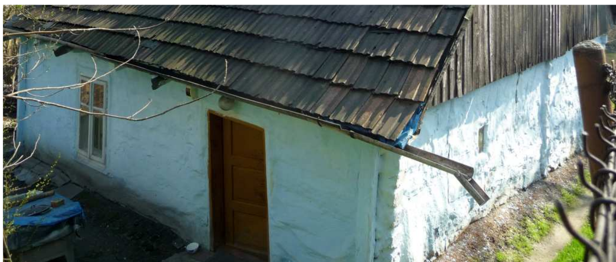
Fot. nr 128 (128-130). Tylna część chatki. (30.03.14)
