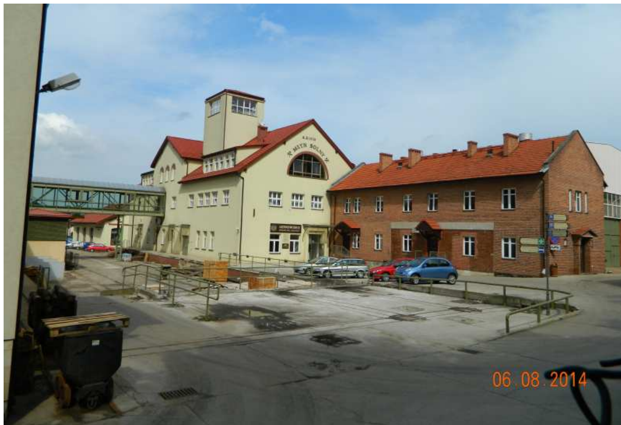
Fot. nr 12. Budynek dawnego młyna solnego.
