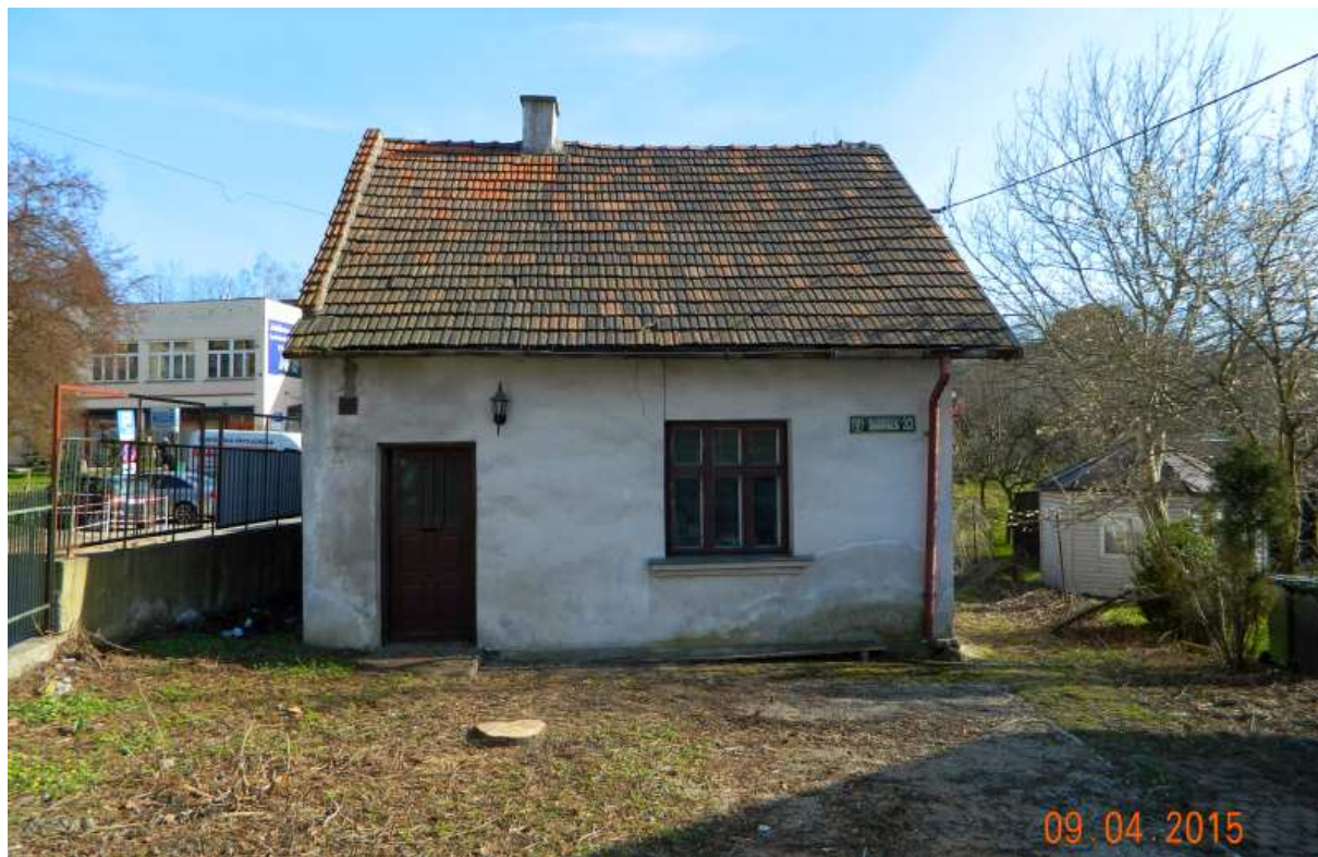
Fot. nr 78. Zapewne międzywojenny domek z ulicy Sienkiewicza 33.
