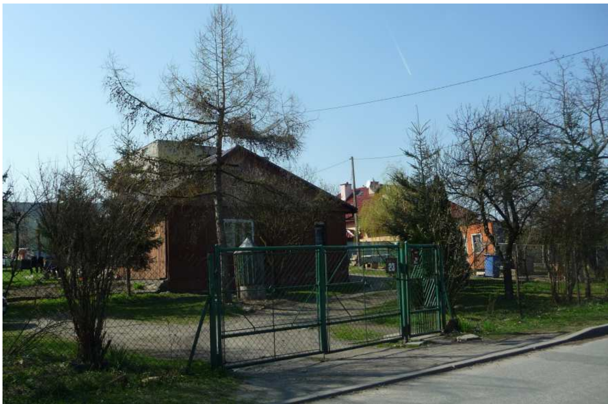
Fot. nr 125 (125-126). Chałupka z ulicy Różanej 23, jeszcze z oryginalnym oknem. (30.03.14)
