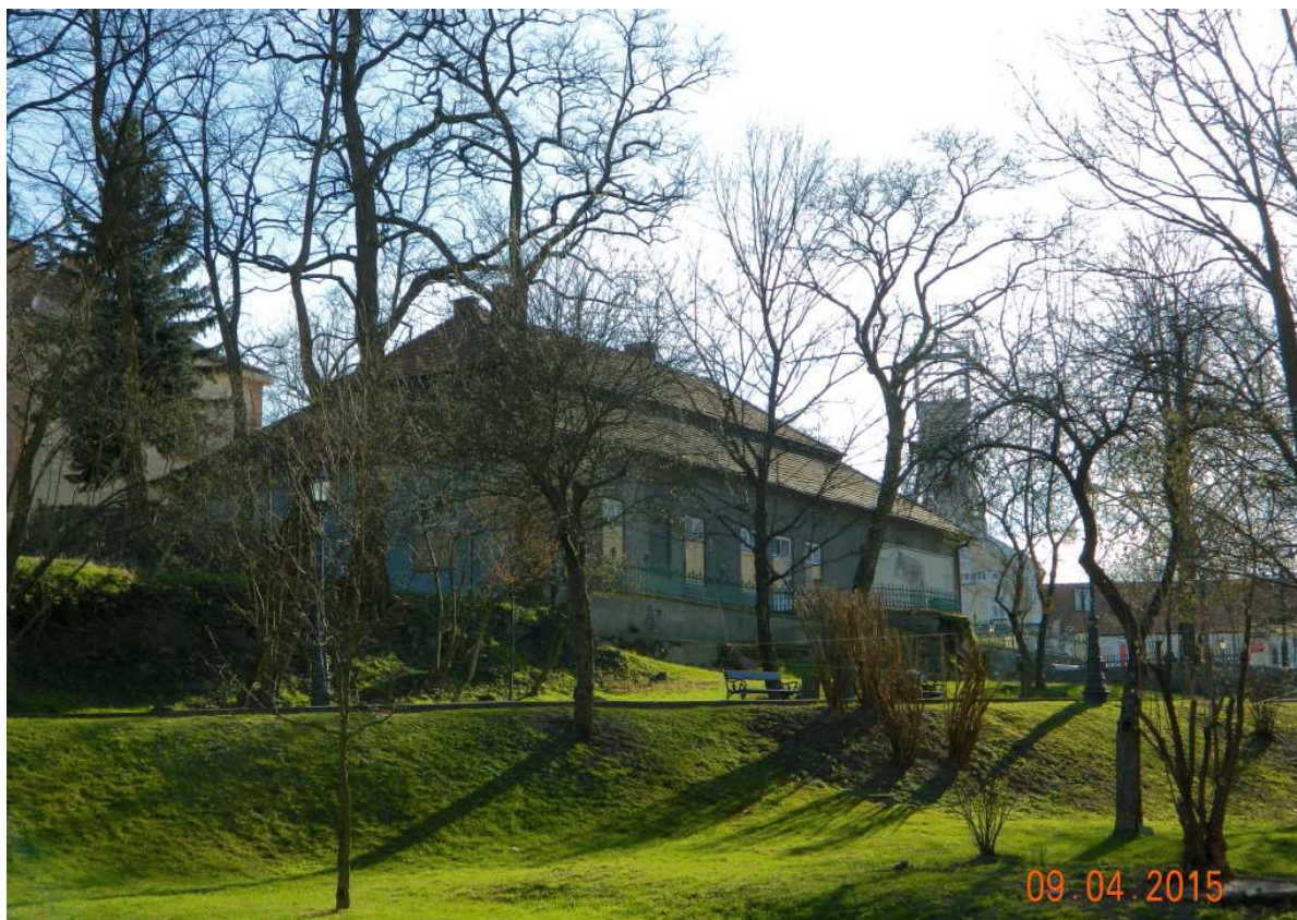
Fot. nr 106 (106-107). Ciągłe będąca w stanie ruiny tzw. „Markszajdrówka”, czyli budynek mierniczych górniczych z ulicy Daniłowicza 13.
