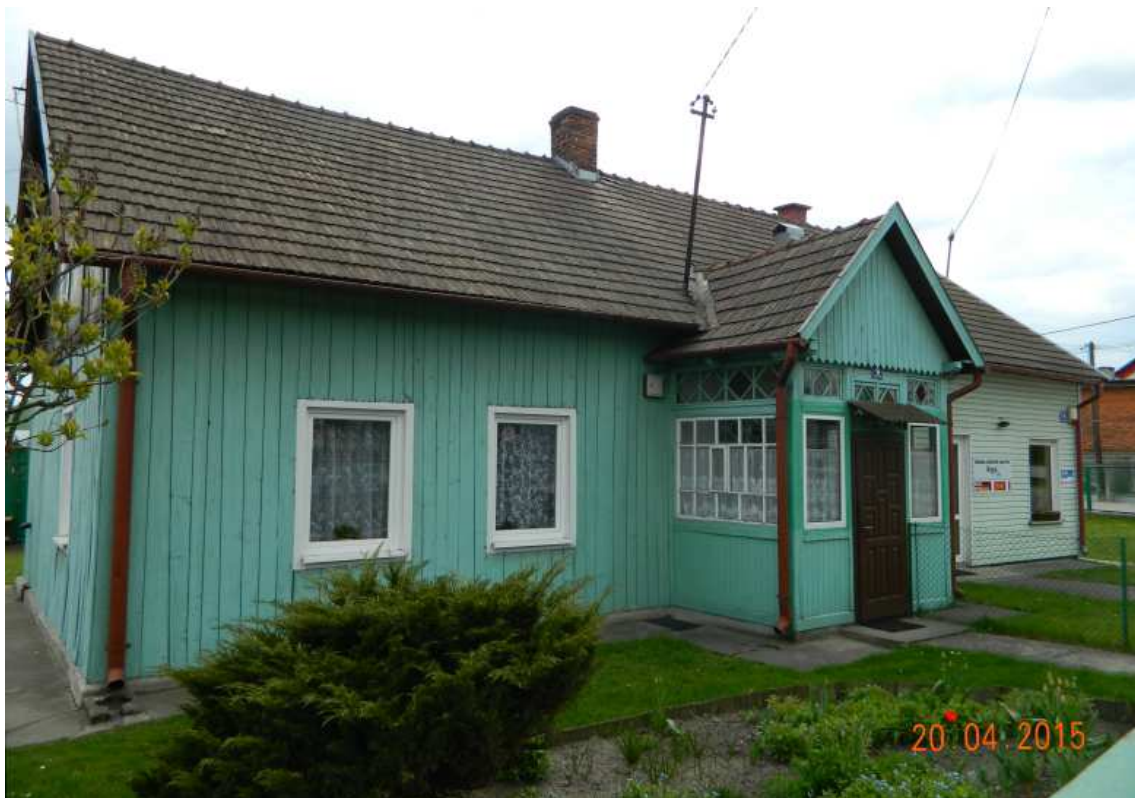
Fot. nr 167(167-168).Zniekształcona przez nowe okna fasada domu z ulicy Kościuszki 19.
