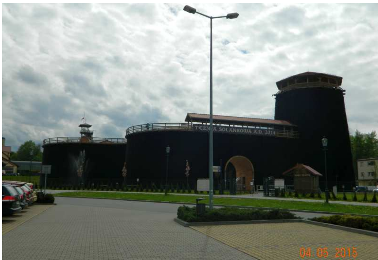
Fot. nr 26a. Obiekt już w eksploatacji.
