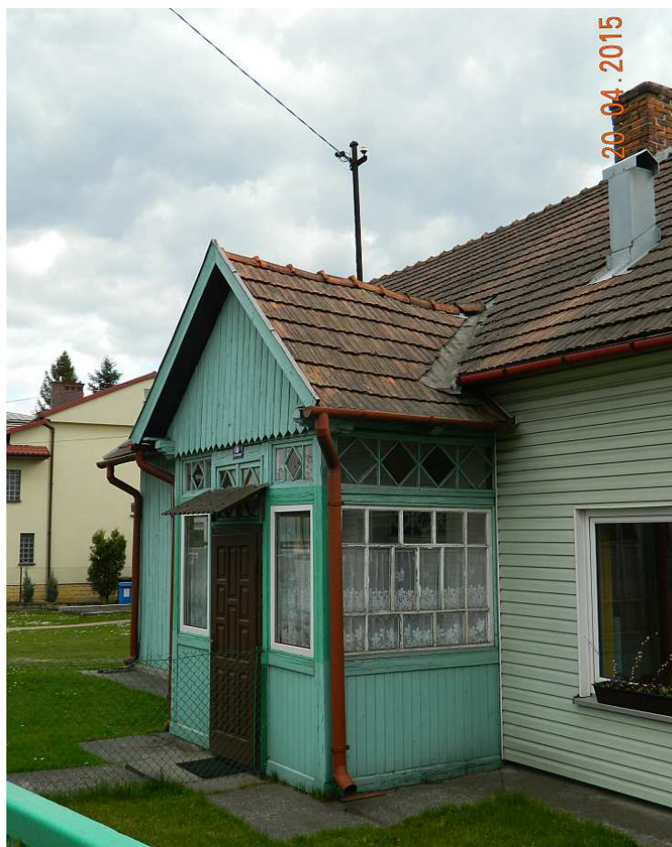
Fot. nr 168. Ciągłe bliska oryginałowi weranda.
