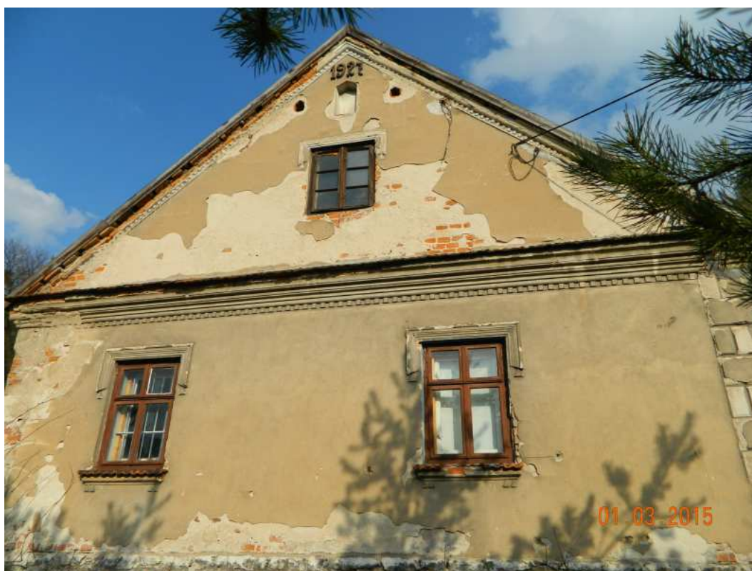
Fot. nr 234. Oryginalna boczna ściana.
