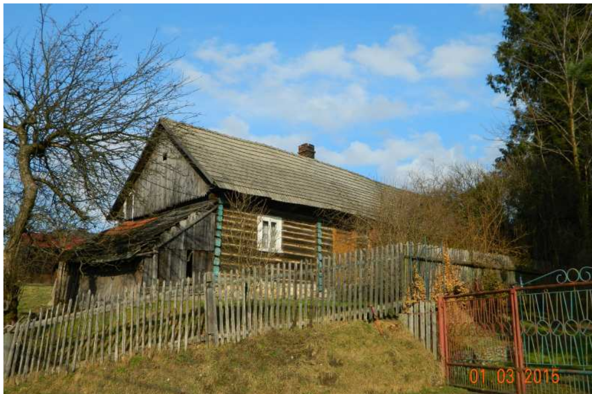
Fot. nr 259 (259-263). Oryginalna chałupa pod nr 40. Warto się jej bliżej przyjrzeć.
