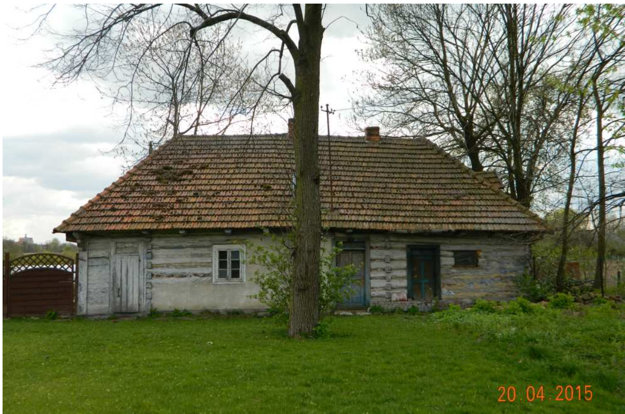
Fot. nr 174 (174-176). Prawdziwy rarytas, tylna część oryginalnej chałupy z ulicy Wielickiej 99(?).
