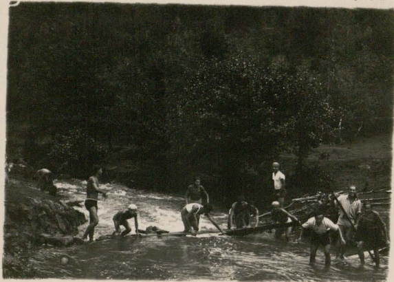
Lastek druka Stanka buduje kładki nad strumieniem
