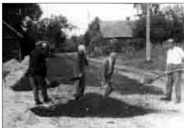
Przyborów, gmina Szczepanów. Prace przy drodze przez wieś.
