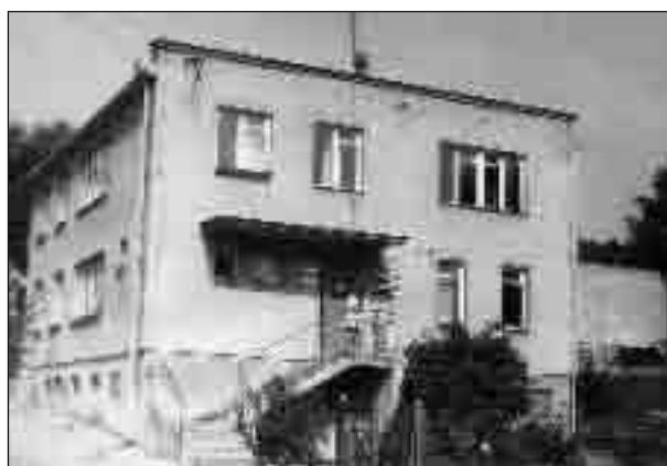
Porąbka Uszewska, gmina Dębno. Ośrodek Zdrowia.
