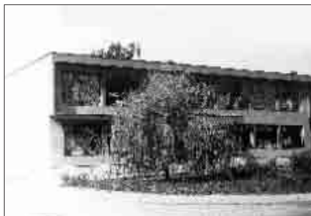
Szczurowa. Wiejski Dom Towarowy.
