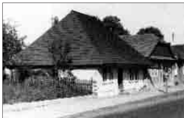
Zakliczyn. Zabytkowy dom przy ul. Jacka Malczewskiego.
