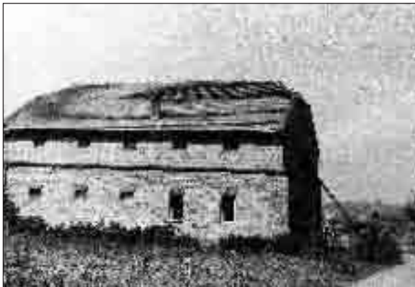
Filipowice, gmina Zakliczyn. Spichlerz i magazyn nawozów mineralnych Rolniczej Spółdzielni Produkcyjnej.
