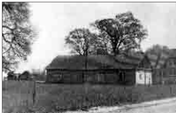
Szczepanów. Budynek starej karczmy w rynku.
