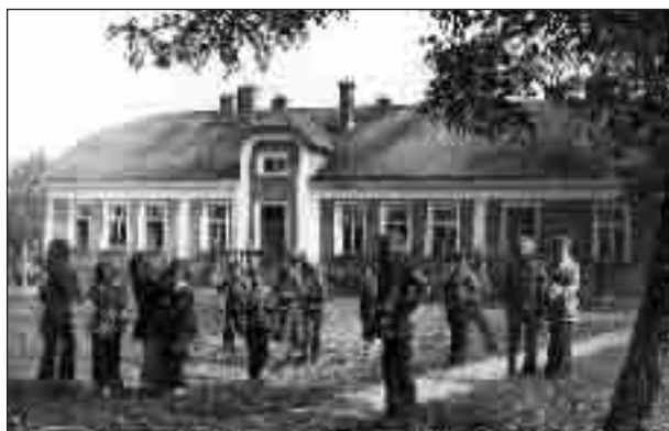
Bucze, gmina Szczepanów. Budynek Szkoły Podstawowej z lat międzywojennych.
