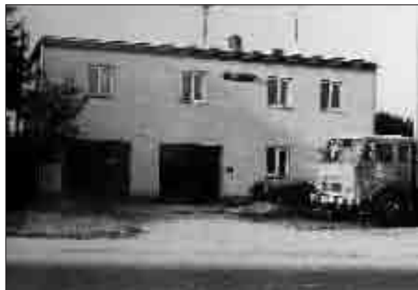
Dom Strażaka w Jadownikach, gmina Brzesko.
