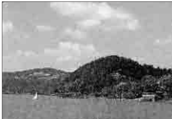
Czchów Zapora. Widok na Zalew Czchowski od strony wschodniej.
