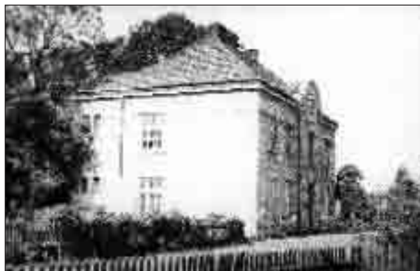
Strzelce Wielkie, gmina Szczurowa. Dom Ludowy.
