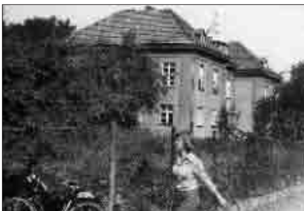
Szkoła Podstawowa Nr 1 w Jadownikach, gmina Brzesko.
