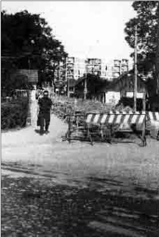
Prace przy kanalizacji prowadzone na ulicy Ogrodowej w Brzesku.
