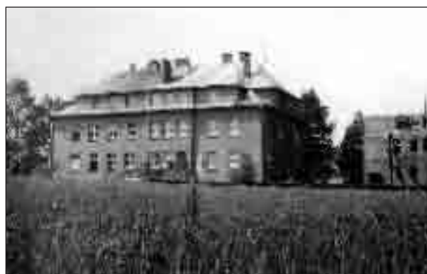
Iwkowa. Ośrodek Zdrowia, obok w budowie dom dla pracowników służby zdrowia.
