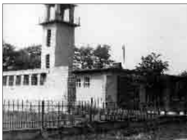
Zaborów, gmina Szczurowa. Remiza Straży Pożarnej.
