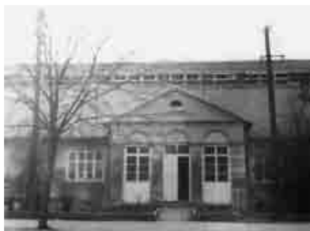
Budowany nowy gmach Prezydium PRN – na pierwszym planie widać stary budynek byłego Starostwa.
