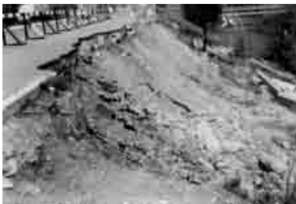
Powódź w 1970 r. Fragment uszkodzonej szosy Kraków-Tarnów w Brzesku na odcinku przed mostem kolejowym bocznicą okocimską.
