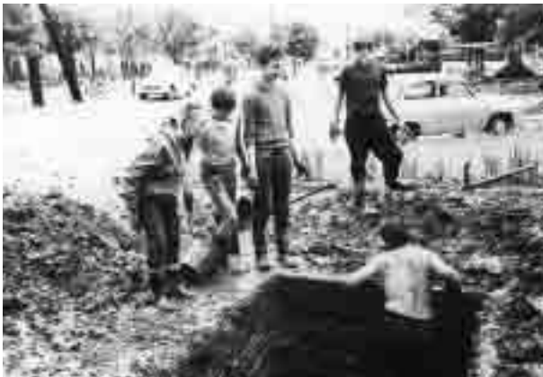
Miejscowa młodzież w czynie społecznym wykonuje wykopy.
