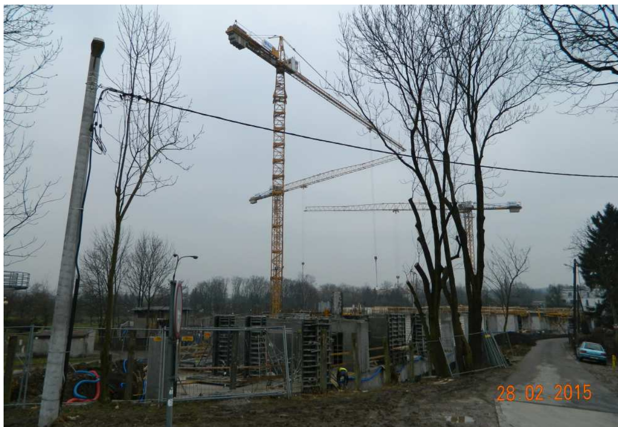
Fot. nr 220 (220-221). Trwa zabudowa otuliny Parku Dębickiego przez deweloperską firmę ECHO – widok od strony Wisły.
