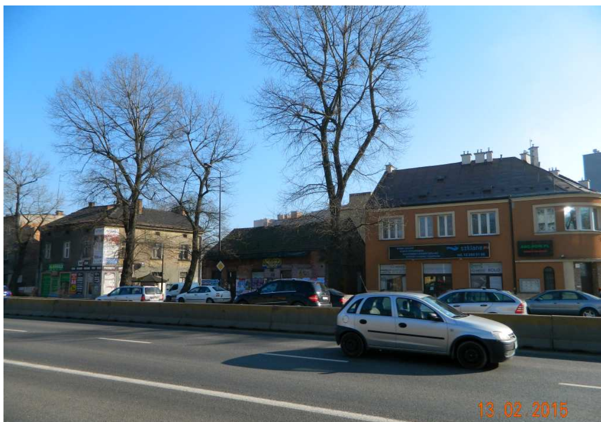
Fot. nr 11. Fragment niskiej zabudowy ulicy 29-Listopada (nr 75-77) przy wlocie ulicy Wiśniowej (dom narożny pod nr 2)
