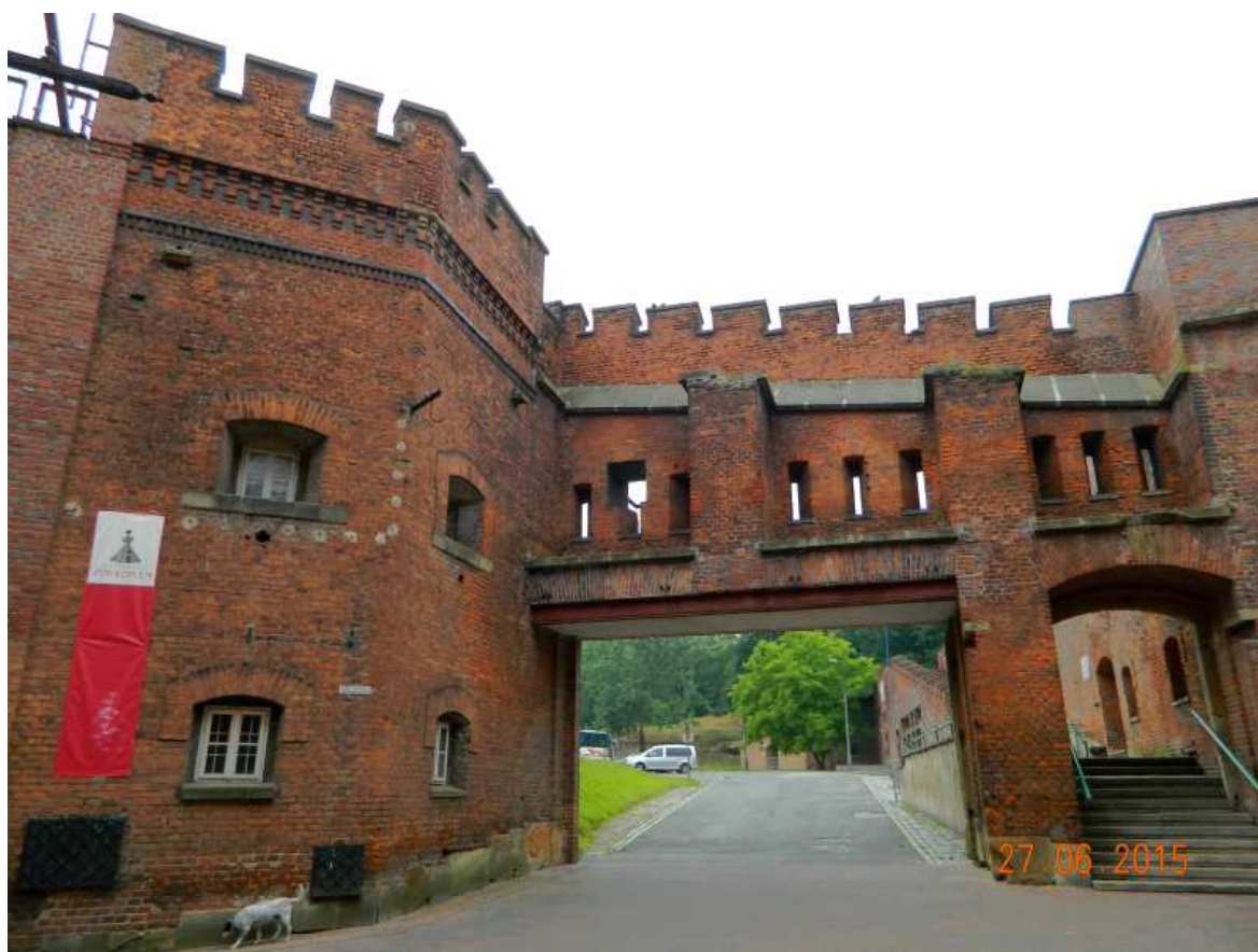
Fot. nr 176 (176-177). Wjazd na dziedziniec koszar; tu widok od strony wewnętrznej.
