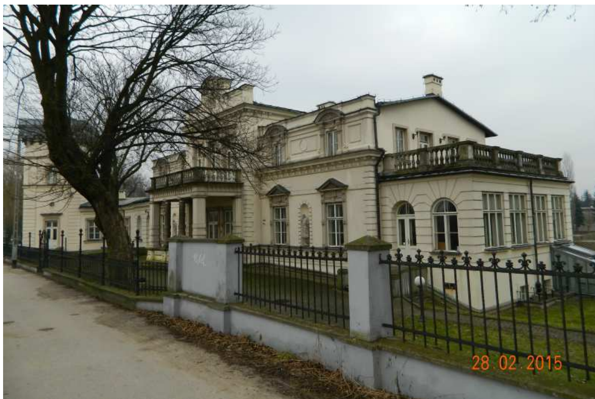
Fot. nr 216 (216-218). Pałac Lasockich. Fot. nr: 216-217 – fasada od strony Wisły.
