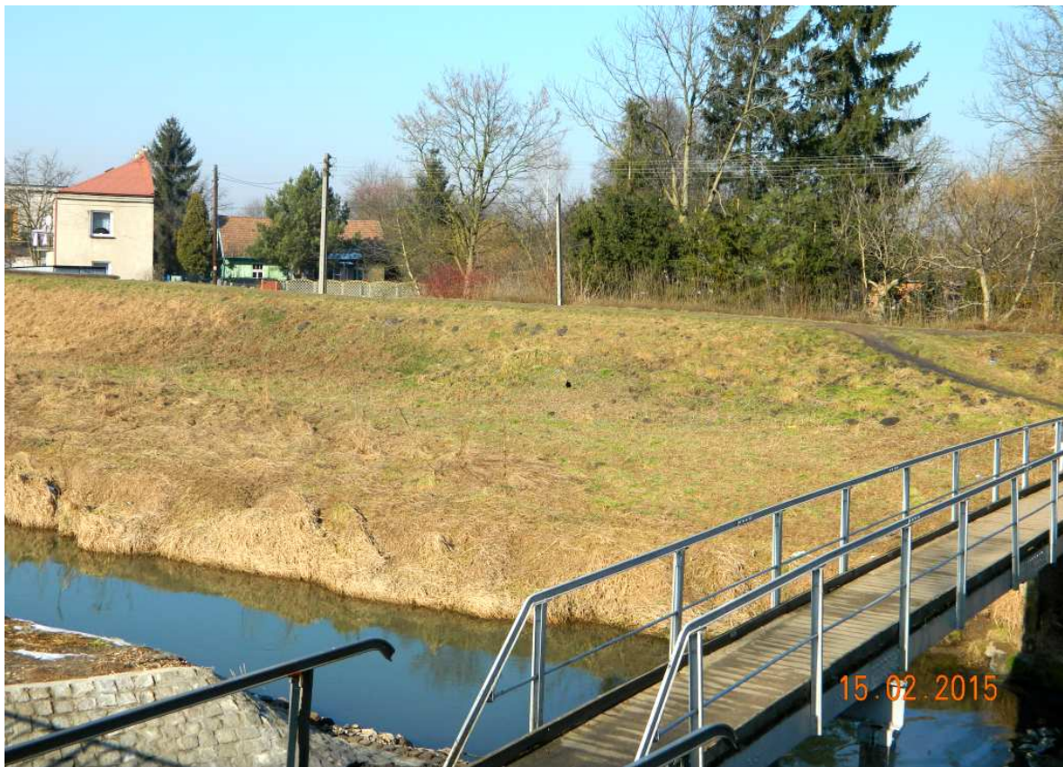
Fot. nr 94. „Ława” („czerwony most”), czyli dawna drewniana kładka na wysokości ulicy Korbutowej, która kiedyś skracała drogę rolnikom z Woli na miejskie targowiska.
