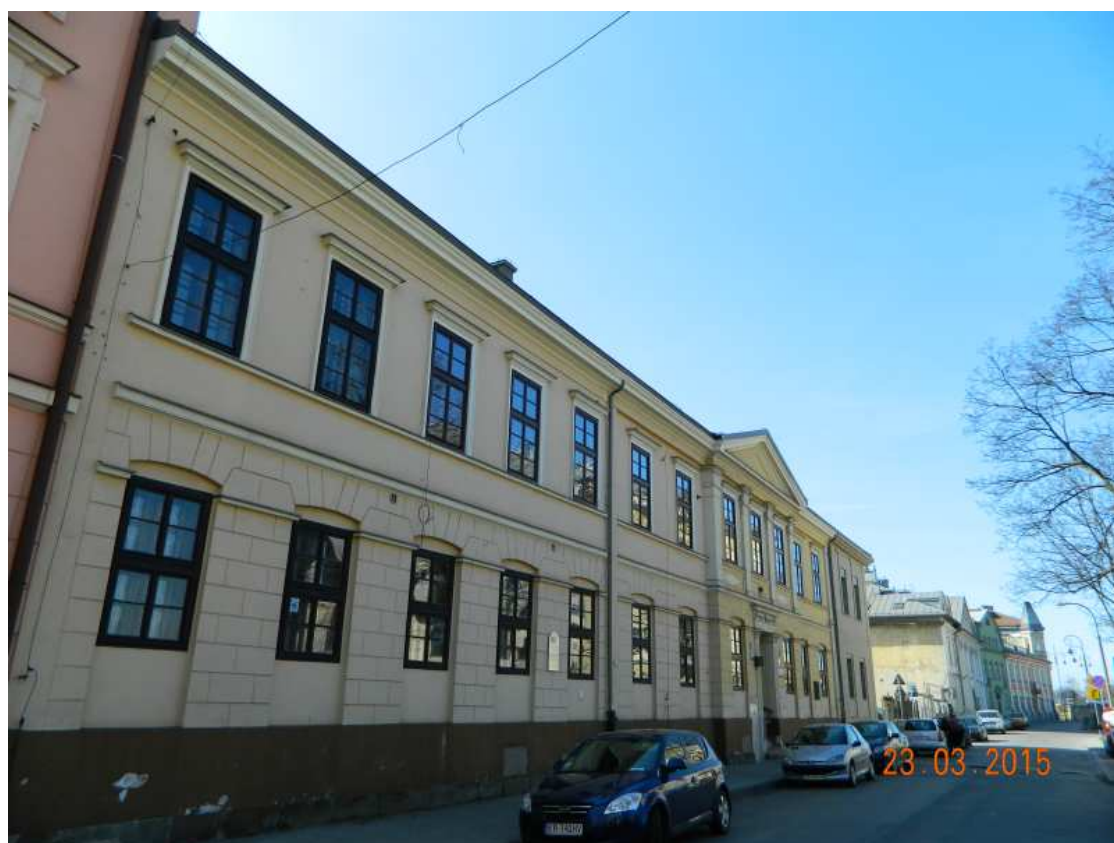
Fot. nr 269 (269-270). Zabytkowa zabudowa początkowego fragmentu ulicy Józefińskiej.
