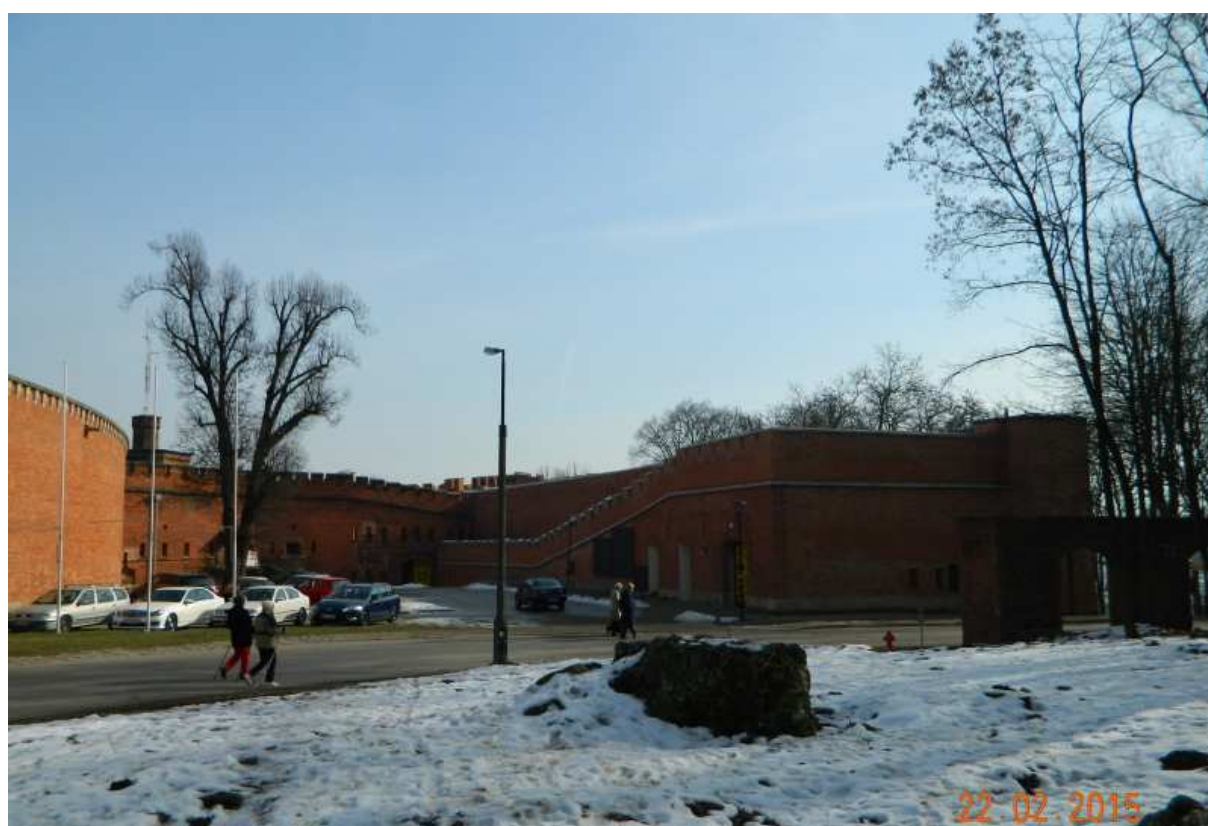
Fot. nr 193 (193-194). Bastion nr V i kurtyna I-V od wewnątrz – widoki ze splantowanego po II wojnie światowej terenu po bastionie nr I fortu.
