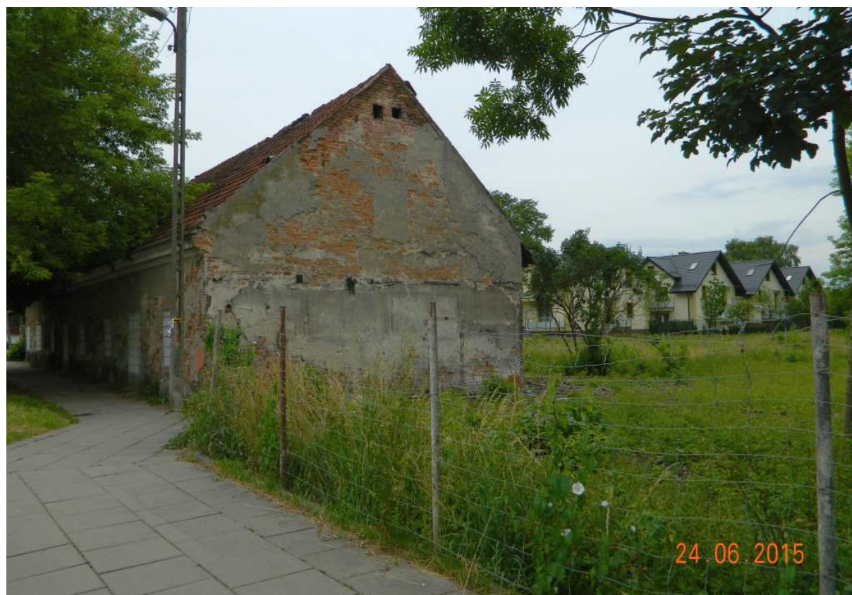
Fot. nr 233. Dawny budynek mieszkalny pracowników kamieniołomu z ulicy Twardowskiego 117 i jego współczesne otoczenie. Może to już ostatnie jego ujęcie?
