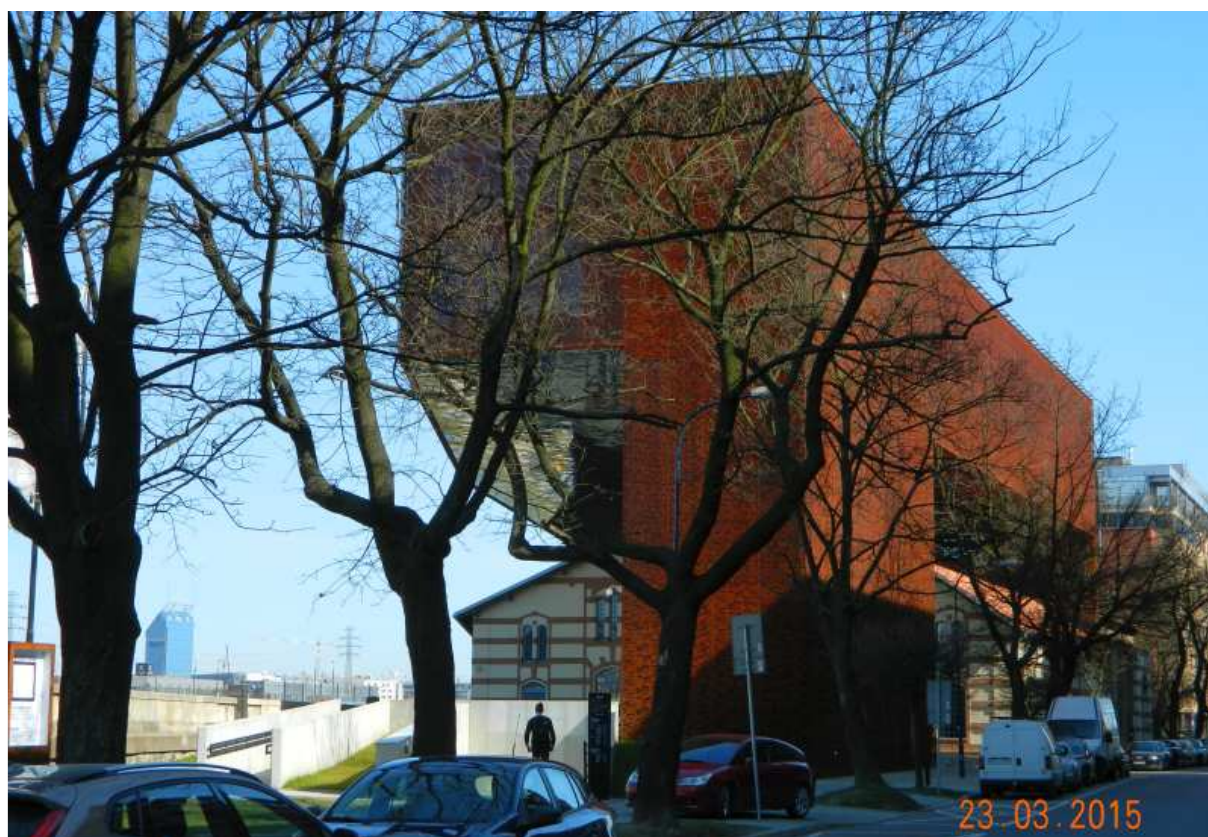
Fot. nr 271 (271-276). Niedawno oddana do użytku Cricoteka, która powstała z wykorzystaniem wyremontowanego budynku dawnej elektrowni podgórskiej z 1901 roku.
