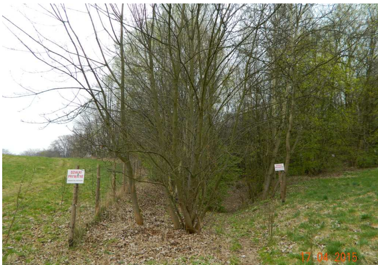
Fot. nr 140. Siatki w sąsiedztwie zarastającego kanionu, usytuowanego w bliskości szczytu.
