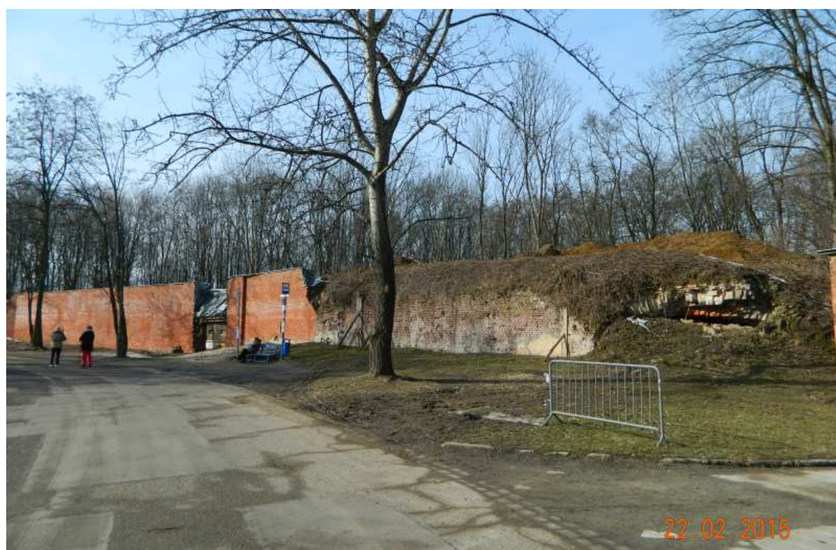
Fot. nr 179 (179-188). Rekonstruowana kurtyna I-II fortu Kościuszko.
