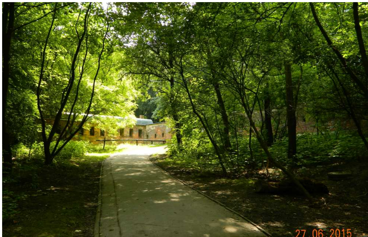
Fot. nr 198 (198-200). Pozostałości zespołu bramnego 3a fortu Kościuszko przy końcu ulicy Hofmana (dawniej Spadzistej) i szańcu FS-3.
