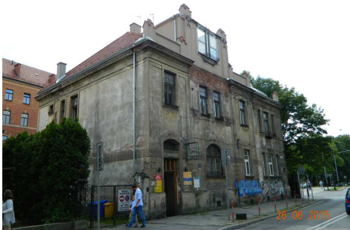
Fot. nr 63. Mocno zniszczona, ale okazała modernistyczna willa spod nr 8 (ok. 1908).
