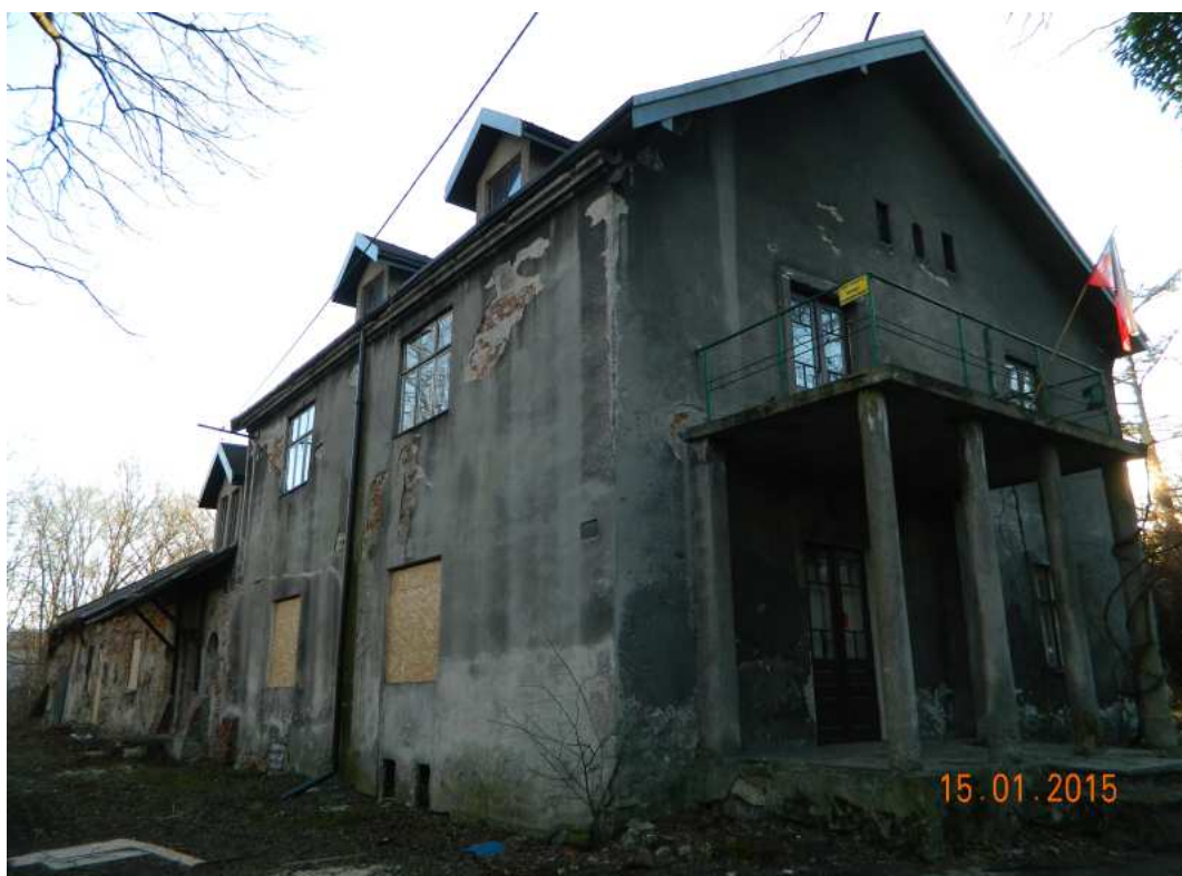
Fot. nr 301 (301-302). Ujęcia części: bocznej i tylnej od strony wjazdu z ulicy Estońskiej.
