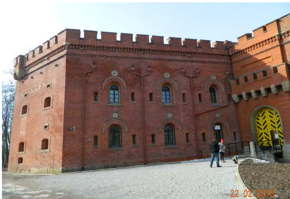
Fot. nr 160 (160-161). Bastion nr V i brama wjazdowa – widoki z przedpola fortu.
