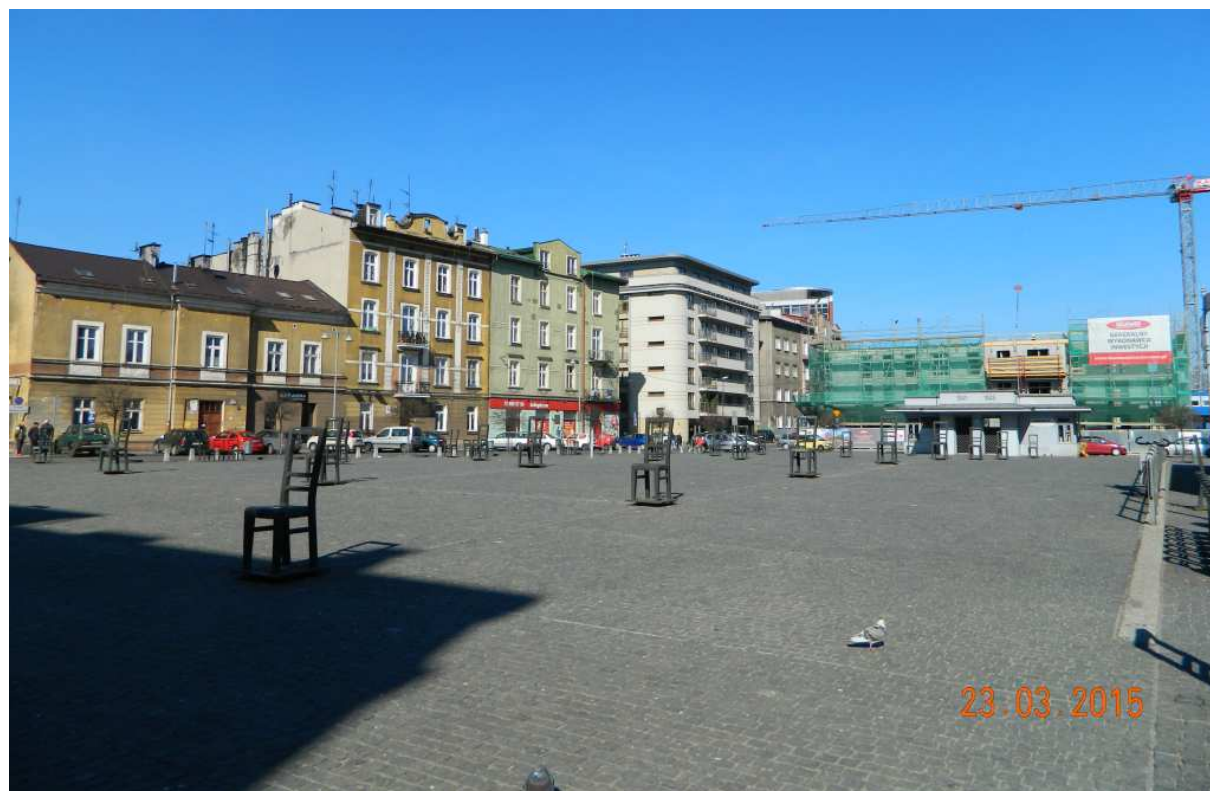
Fot. nr 266. Rozpoczęła się zabudowa fragmentu Placu przy wylocie ulicy Piwnej.
