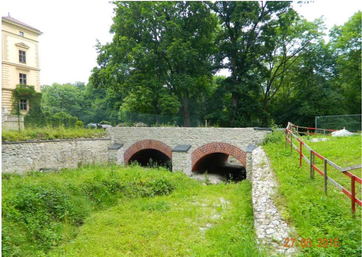
Fot. nr 115 (115-116). Niedawno zrekonstruowany mostek na dawnej drodze dojazdowej do Pałacu Decjusza.
