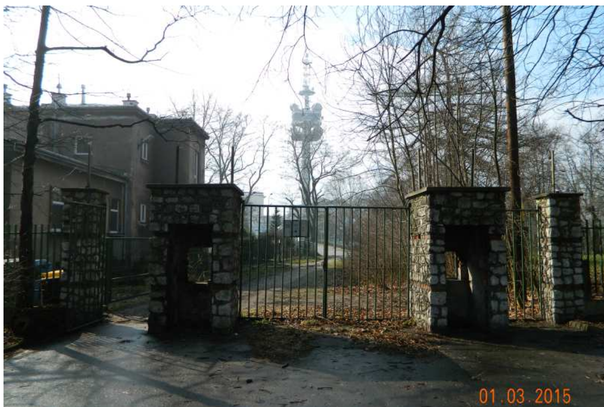
Fot. nr 259. Wejście od strony ośrodka TVP Kraków.
