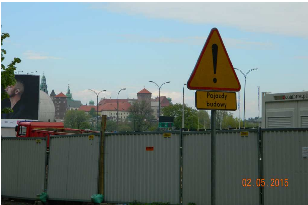
Fot. nr 235 (235-236). Trwa właśnie zabudowa działki w sąsiedztwie hotelu Hilton Garden Inn. Tu widok Wawelu z ulicy Barskiej, który niebawem zostanie przysłonięty.
