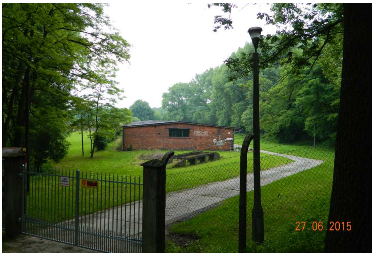
Fot. nr 196 (196-197). Poniemieckie garaże przy Słonecznej Promenadzie.
