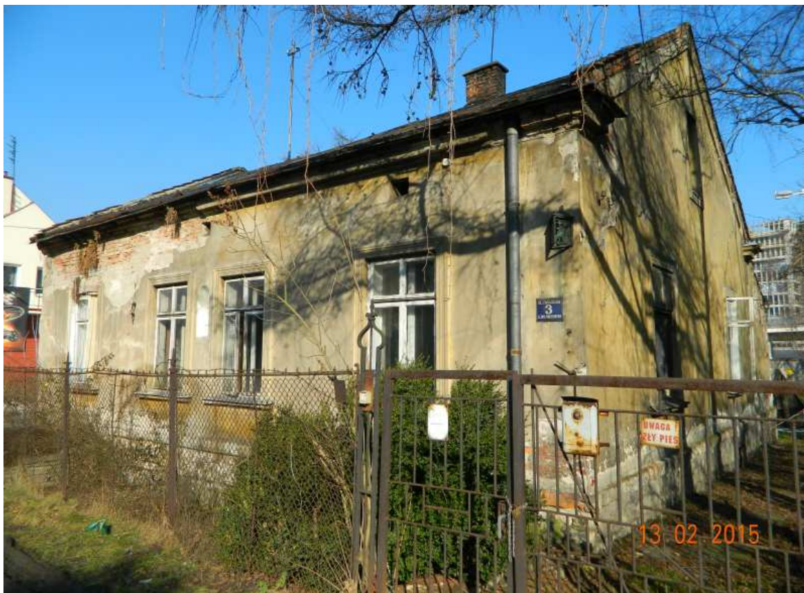
Fot. nr 26 (26-28). Fasada od strony ulicy.
