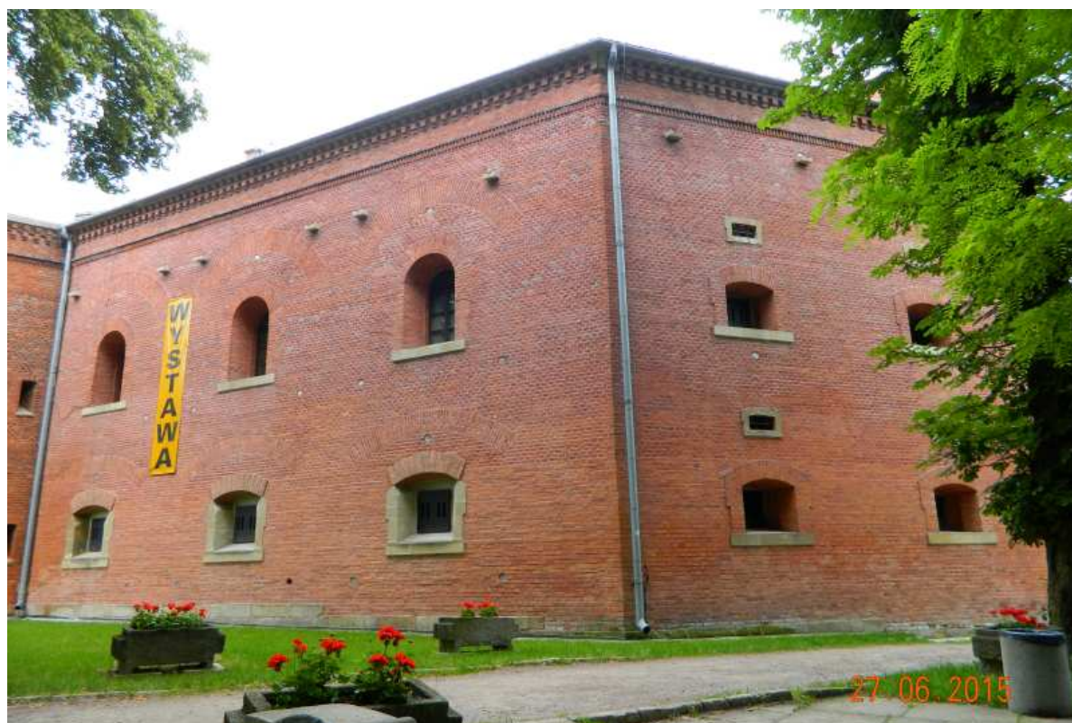
Fot. nr 158 (158-159). Bastion nr V – widoki od strony alei Waszyngtona.
