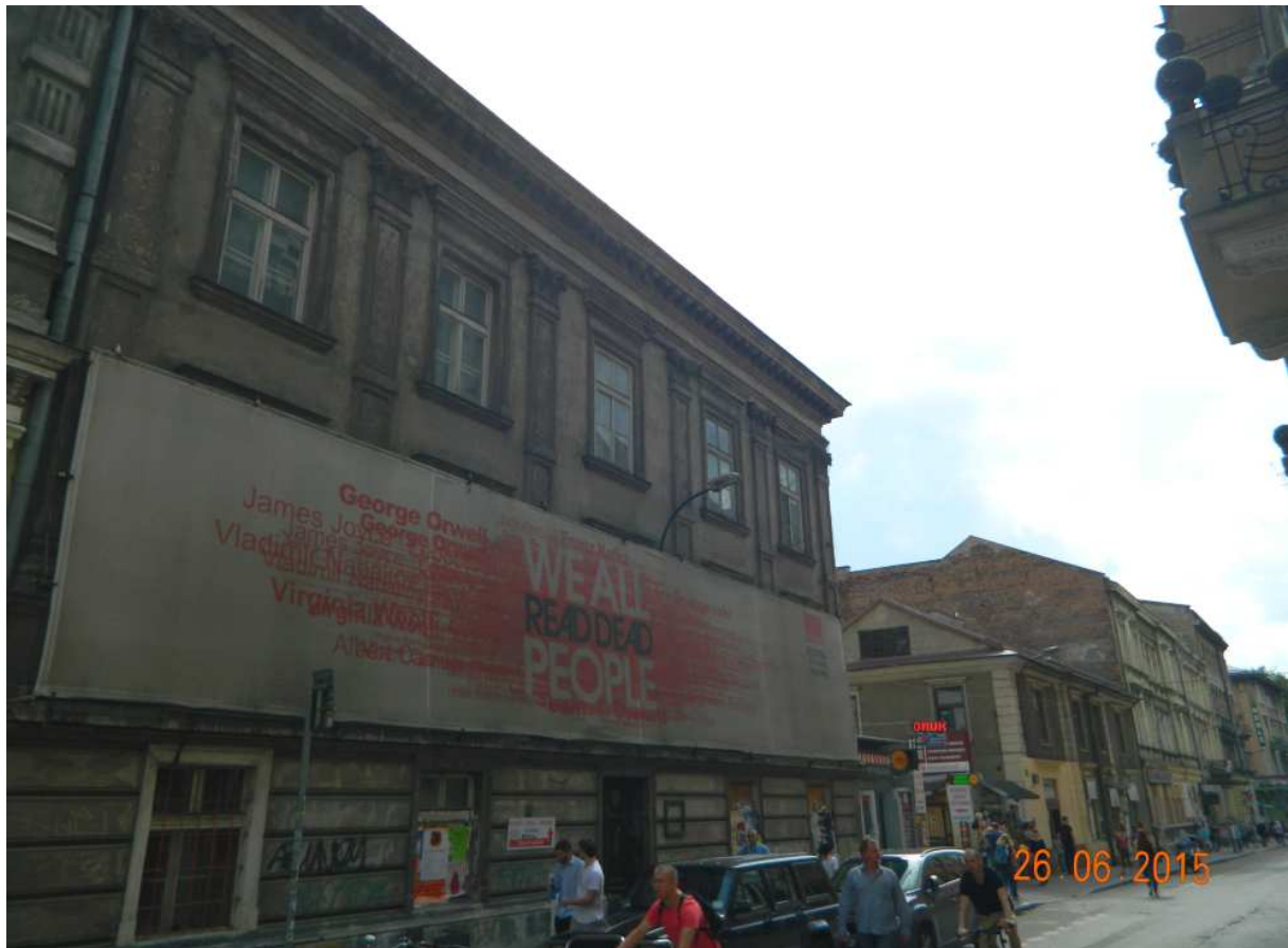
Fot. nr 73 (73-74). Fragment ulicy Krupniczej o numerach: 4-12. Budynki pod nr: 4 i 6 zostały wybudowane jeszcze w XVIII wieku.
