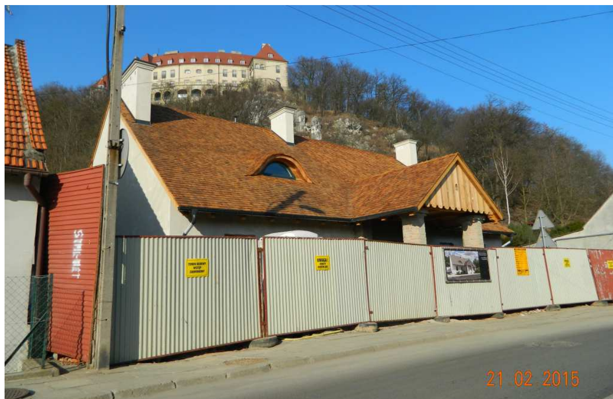
Fot. nr 208 (208-209). Szybko postępuje remont dawnej karczmy przegorzalskiej.
