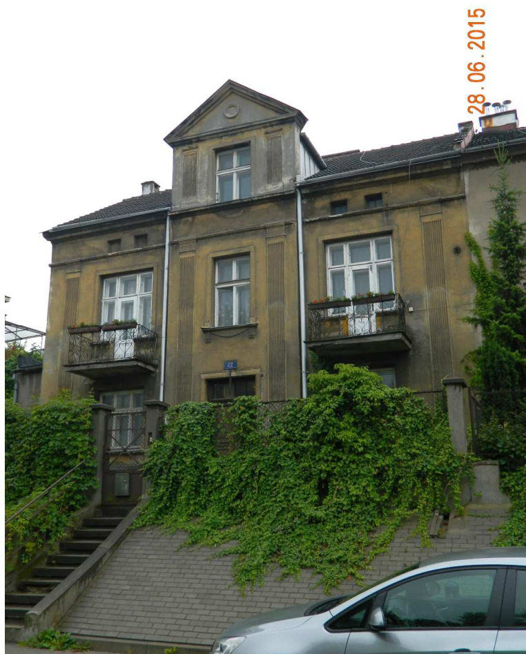
Fot. nr 244 (244-245). Przedwojenna kamienica z ulicy Pod Kopcem 22.
