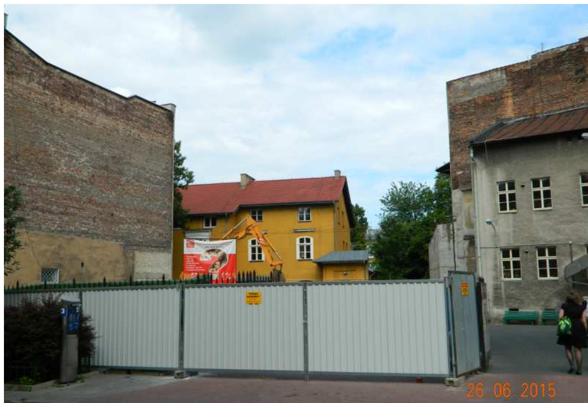
Fot. nr 72a. A tu już posesja, dawna willa z ogrodem, pochodząca z III ćwierci XIX wieku, na etapie robót ziemnych przy budowie hotelu. Kapliczki już nie ma.
