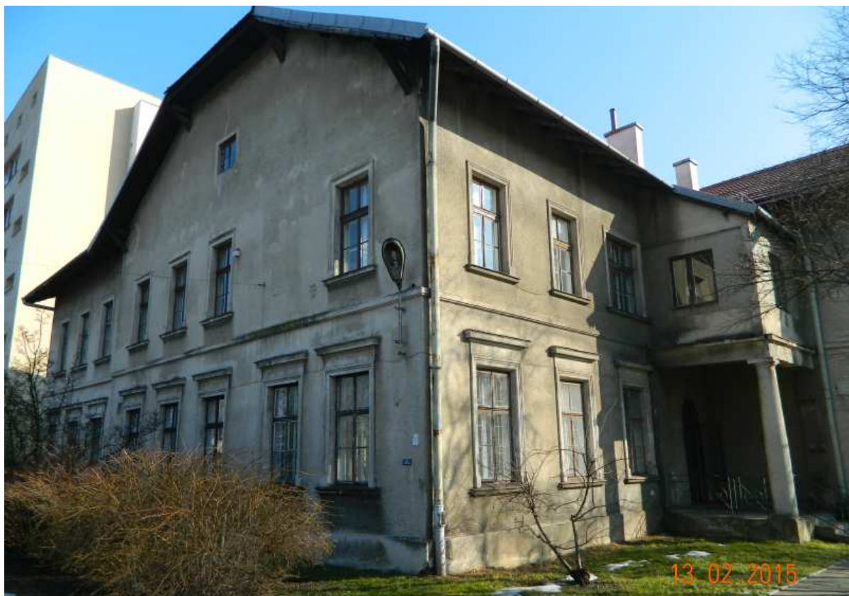
Fot. nr 9. Tylna część i lewy bok domu.
