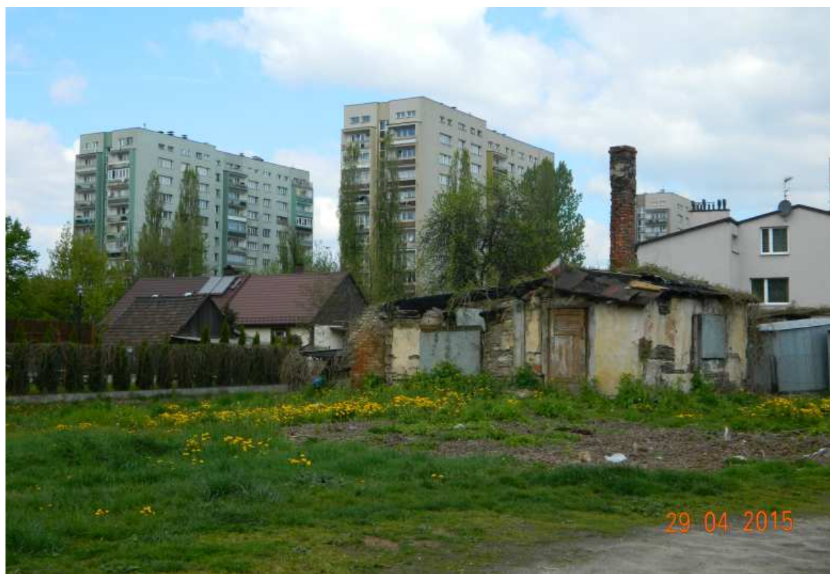
Fot. nr 325. Popadająca w coraz większą ruinę chałupa z (dawnej) ulicy Jesiennej 5.
