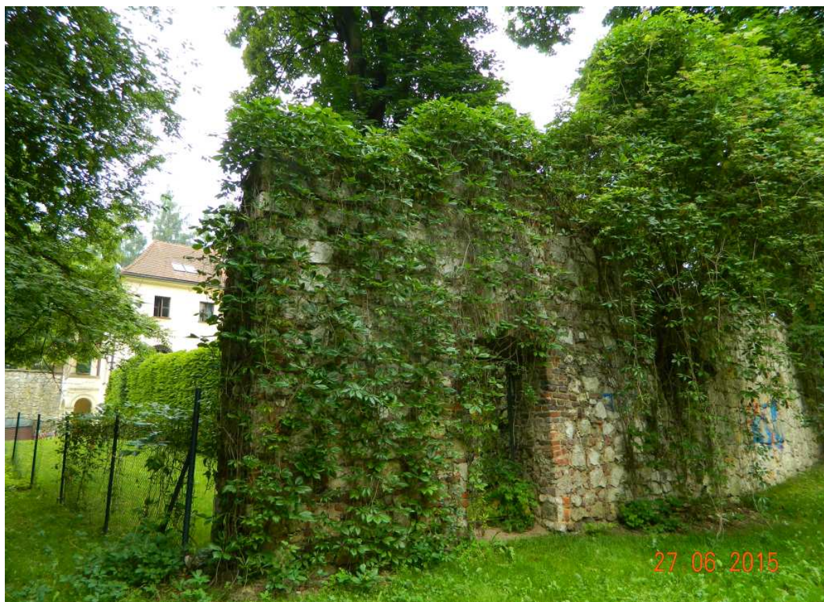
Fot. nr 121. Relikty dawnego muru przy pałacu.
