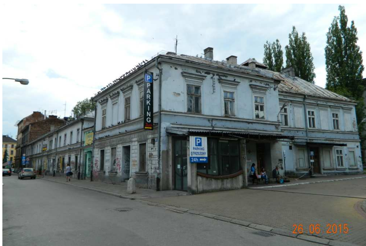
Fot. nr 54. Budynek socjalny dawnej Rządowej Fabryki Tytoniu i Cygar spod nr 8-10, która została wybudowana do 1872 roku.
