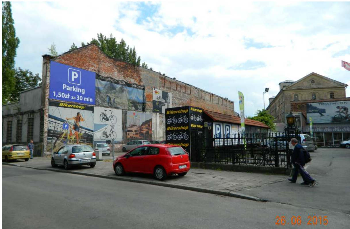
Fot. nr 61. Pusty plac po wyburzonej niedawno kamienicze spod nr 4.
