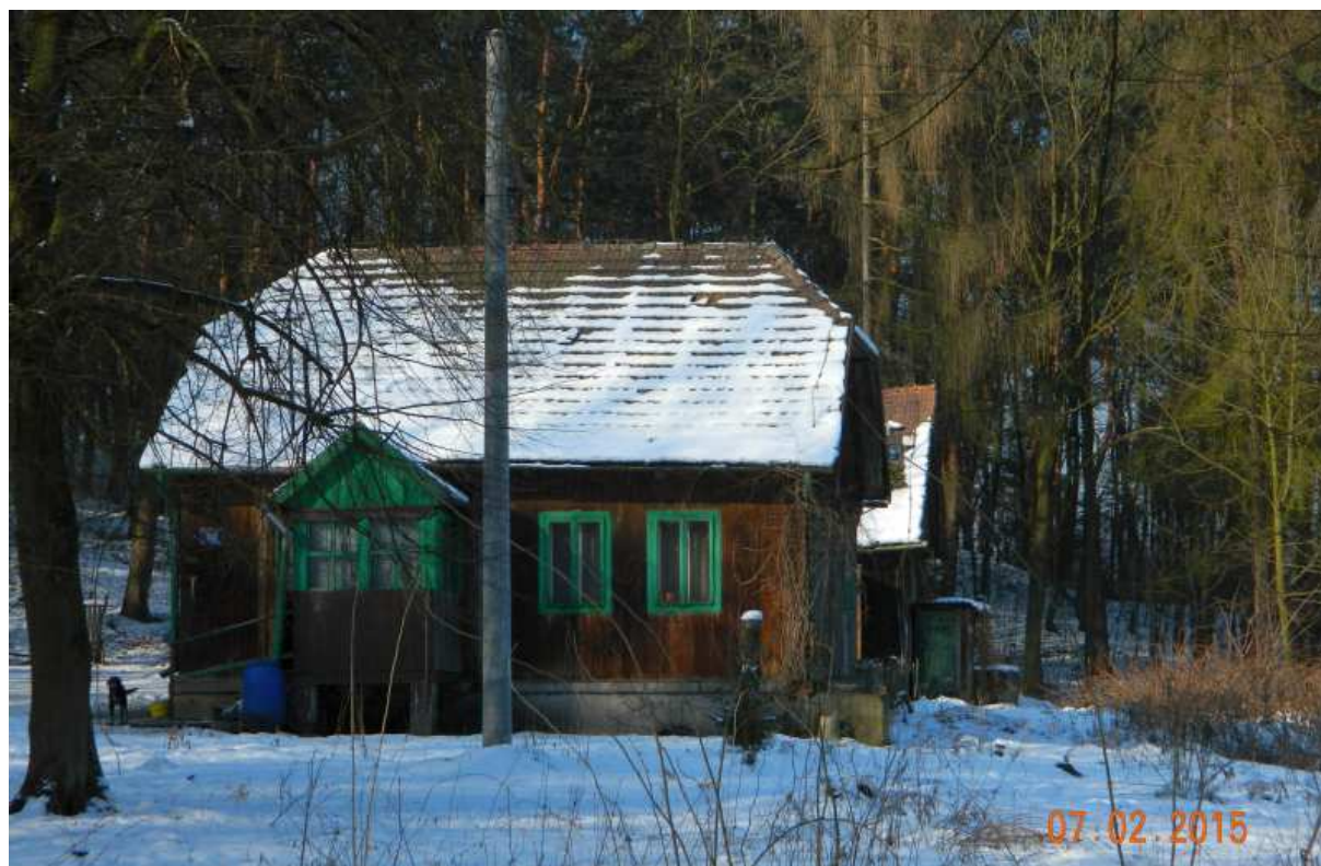
Fot. nr 227. Widok z ulicy Do Groty.
