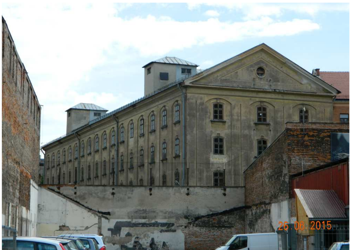
Fot. nr 62 (62-62a). Zabytkowy budynek fabryczny „cygar fabryki”, przylegający do Alei Mickiewicza i starego budynku dawnej WSR – widoki z ulicy Czarnowiejskiej.
