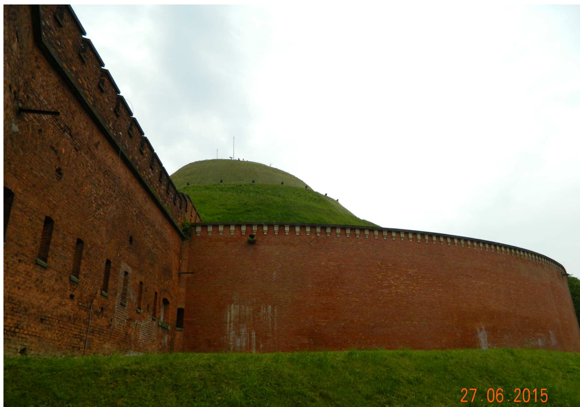
Fot. nr 178. Widok szczytu Kopca spod bramy wjazdowej na dziedziniec.
