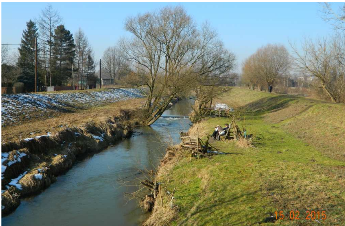
Fot. nr 104. Brzegi Rudawy w sąsiedztwie siódmego mostu.
