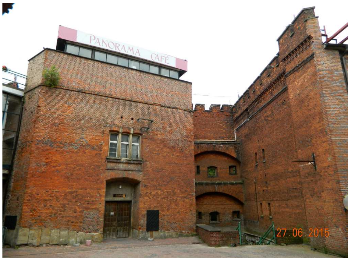
Fot. nr 175. Bastion nr IV z kawiarnią na jego dachu – widok od strony wewnętrznej.
