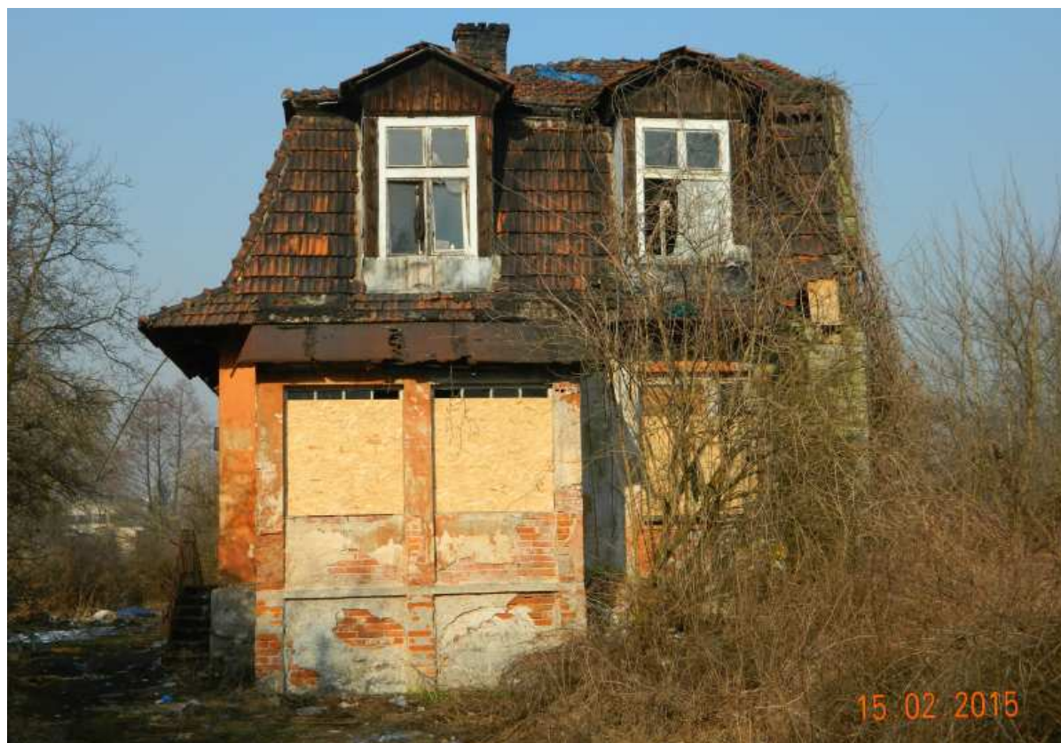
Fot. nr 79 (79-81). Nieistniejący już dom ogrodników z ulicy Mydlnickiej 5.
