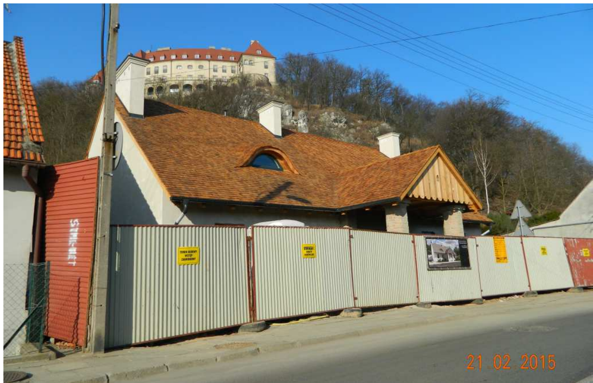
Fot. nr 142 (142-143). Zamek Belweder ponad dawną karczmą przegorzalską.
