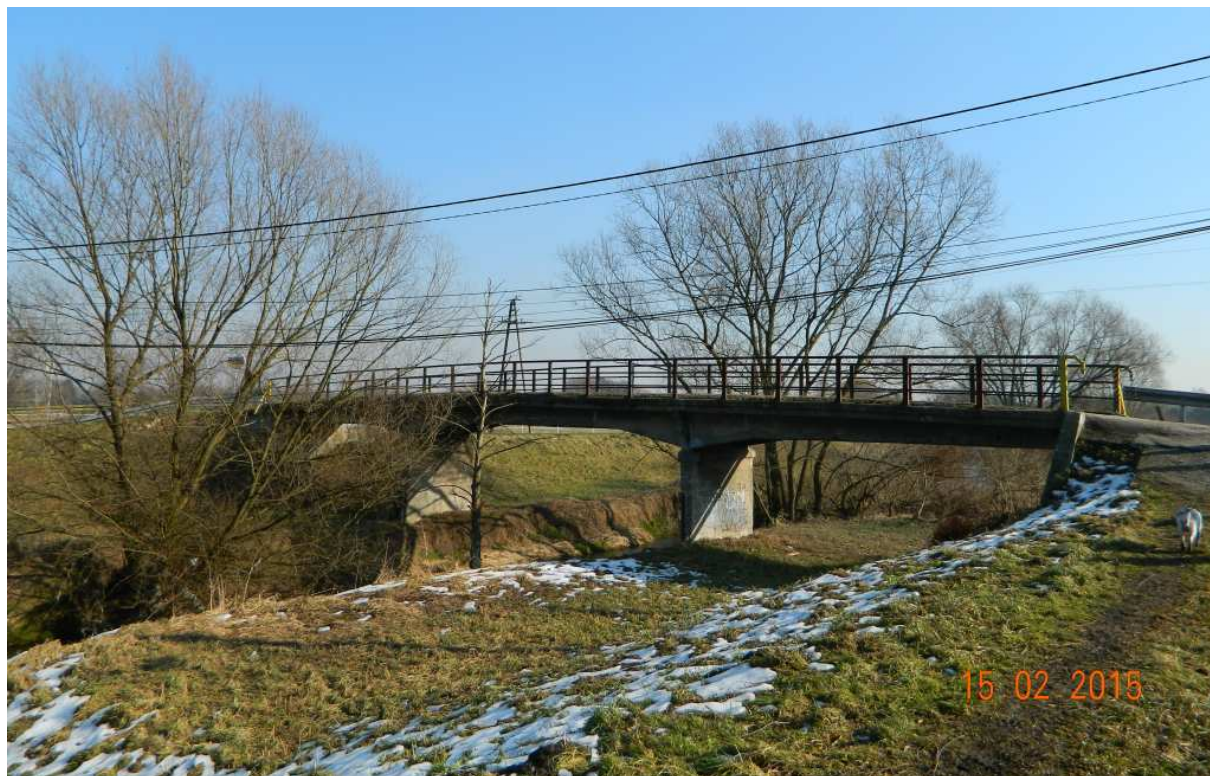
Fot. nr 44 (44-45). Szósty most na Rudawie w ciągu ulicy Nad Zalewem.
