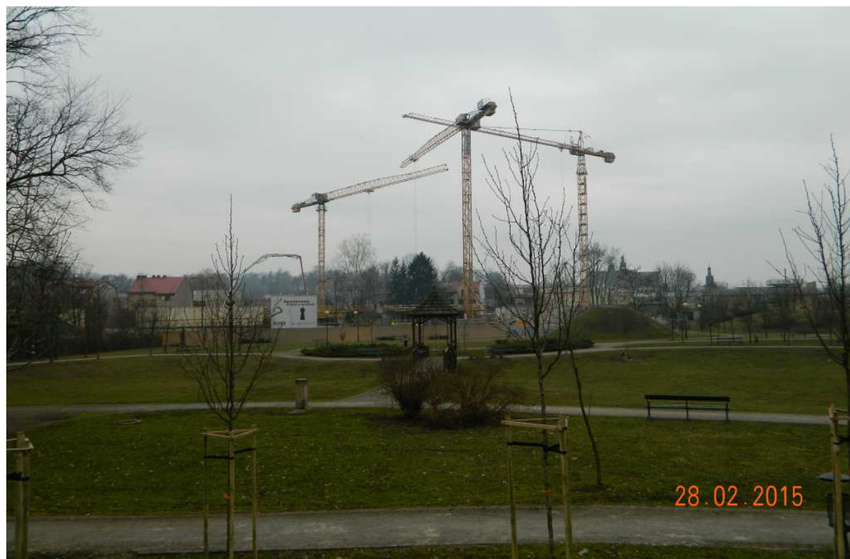
Fot. nr 204 (204-208). Trwa zabudowa otuliny Parku Dębnickiego w sąsiedztwie ulicy Praskiej i Wisły.
