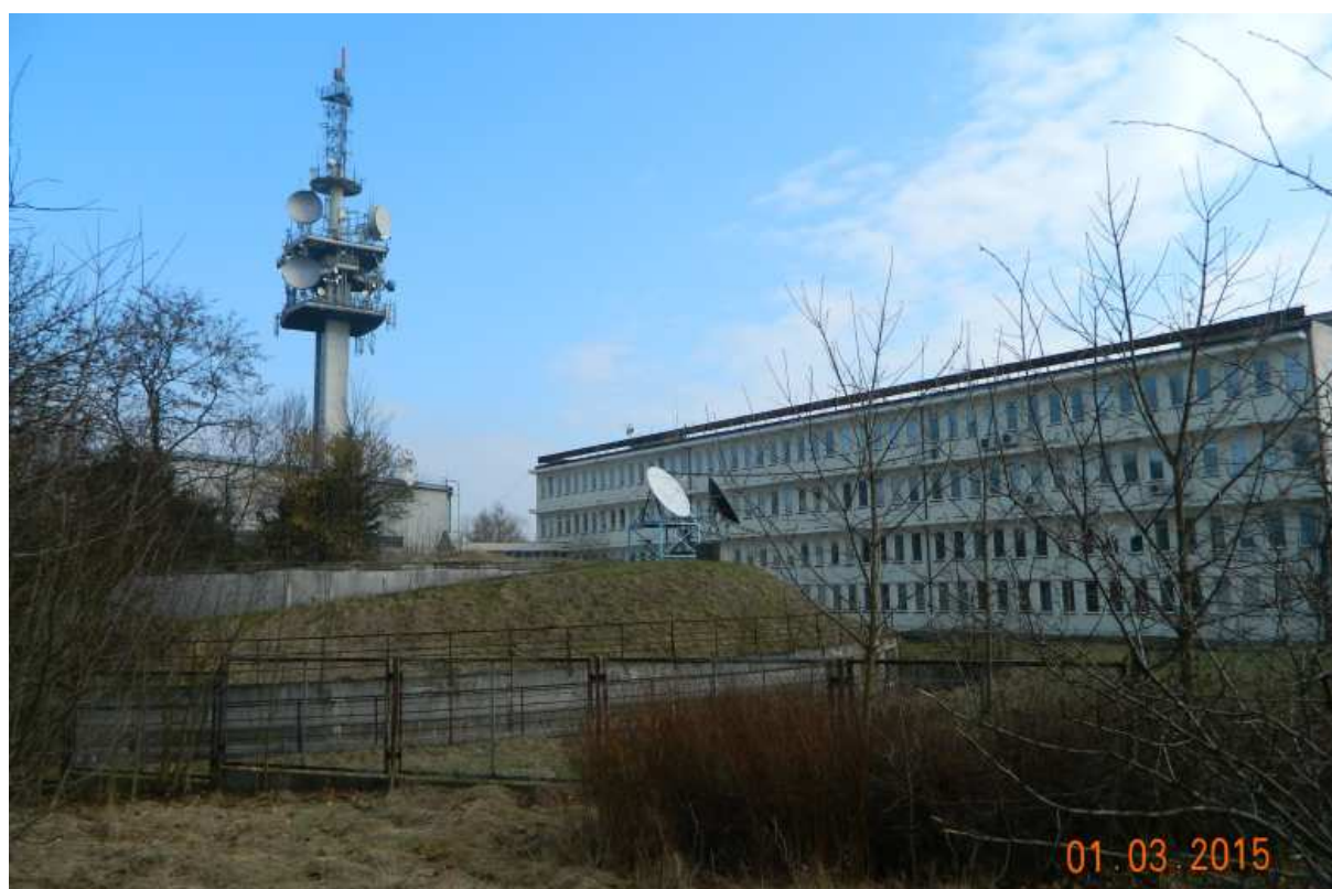
Fot. nr 259. Ośrodek TVP Kraków, który powstał w miejscu fortu nr 32 – Krzemionki. Na pierwszym planie resztki dawnego wału ziemnego.
