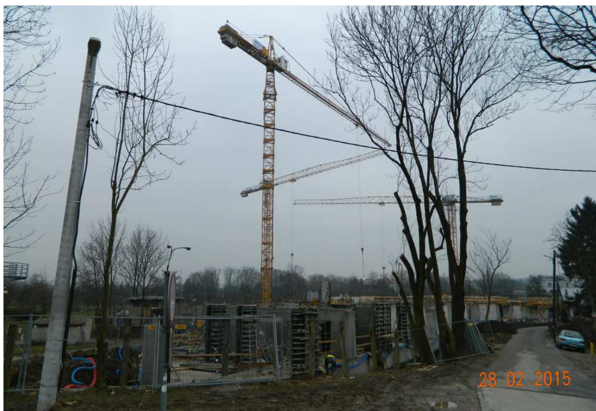
Fot. nr 219. Plac budowy blokowiska realizowanego przez ECHO – widok od strony wału wiślanego.
