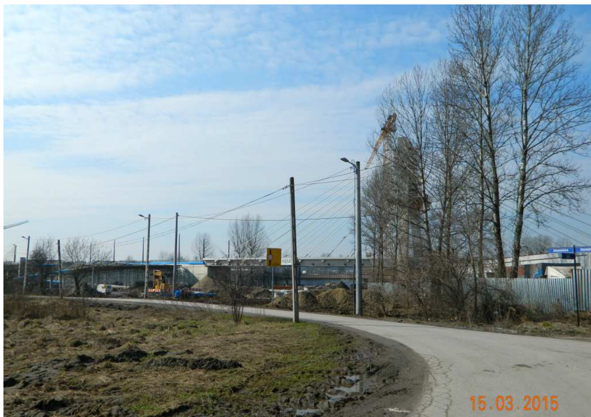
Fot. nr 282 (282-283). Estakada w budowie – widoki z ulicy Żołnierskiej.
