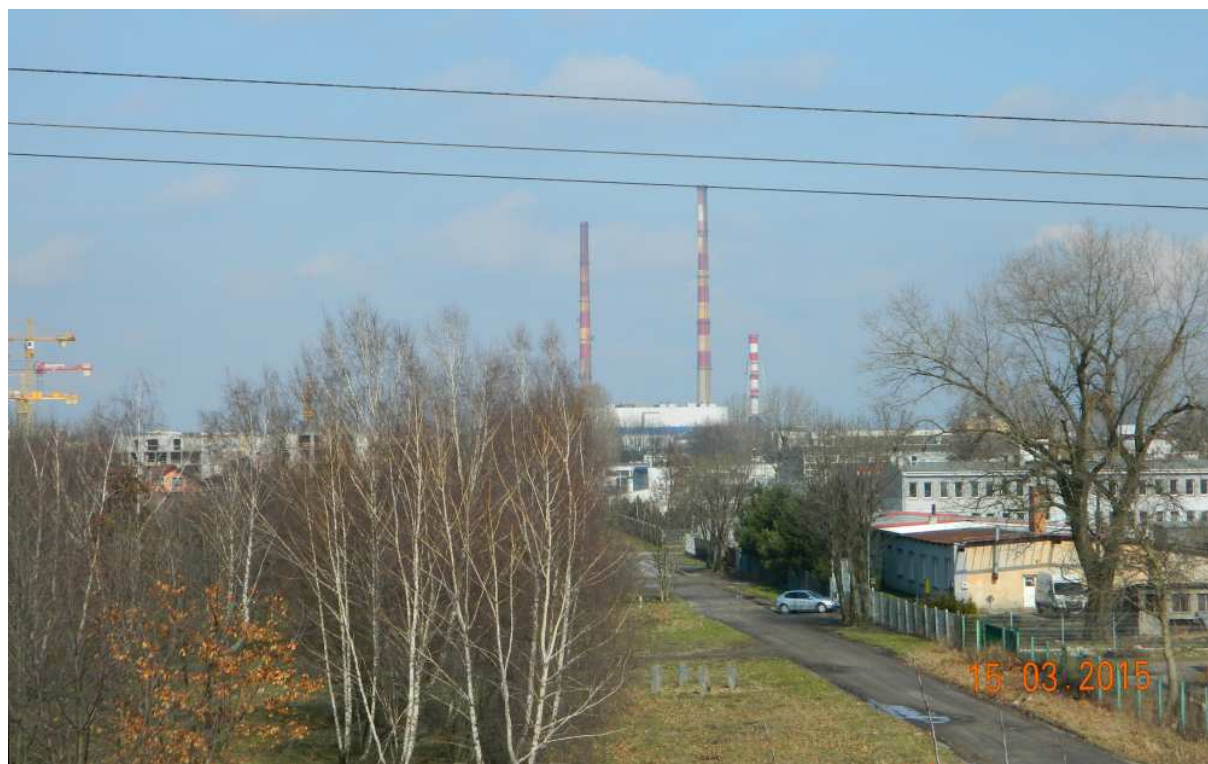
Fot. nr 272. Kominy elektrociepłowni w Łęgu.
