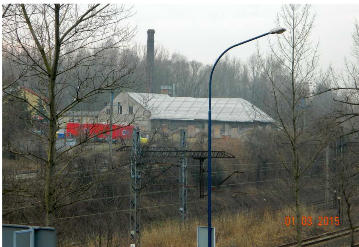
Fot. nr 245. Nieco już poreperowane budynki administracyjne dawnego kamieniołomu Libana przy ulicy Za Torem 22.
