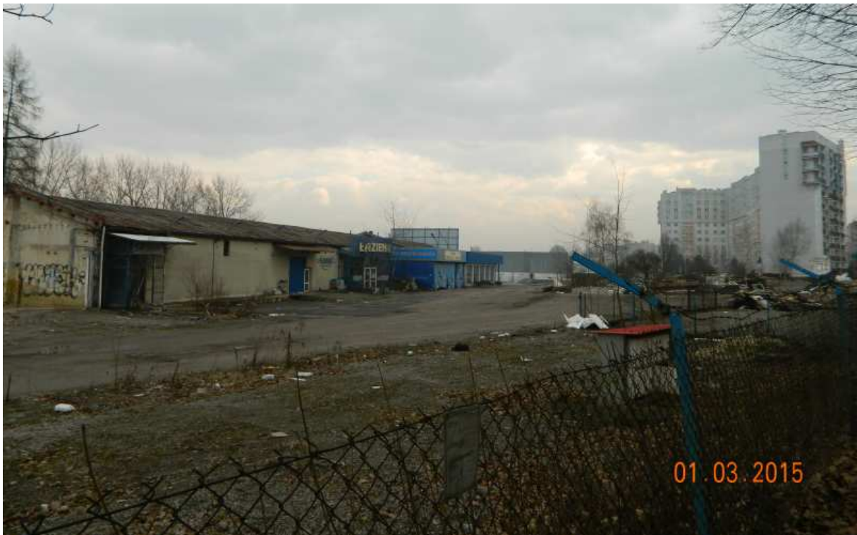
Fot. nr 295. Likwidacja dawnego centrum handlowego, które było zlokalizowane w widłach ulic: Jerozolimskiej i Wielickiej.
