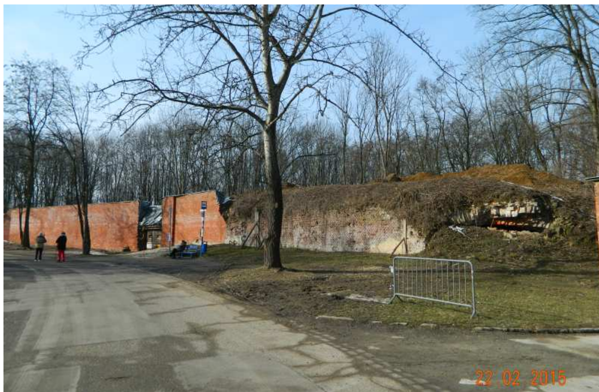
Fot. nr 74 (74-78). Częściowo rekonstruowany fragment kurtyny I-II fortu Kościuszko na zachodnim przedpolu Kopca.
