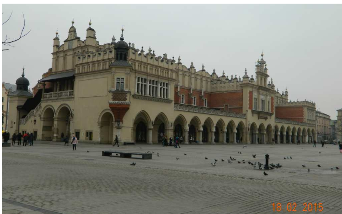
Fot. nr 15. Sukiennice – widok z wylotu ulicy Sławkowskiej.
