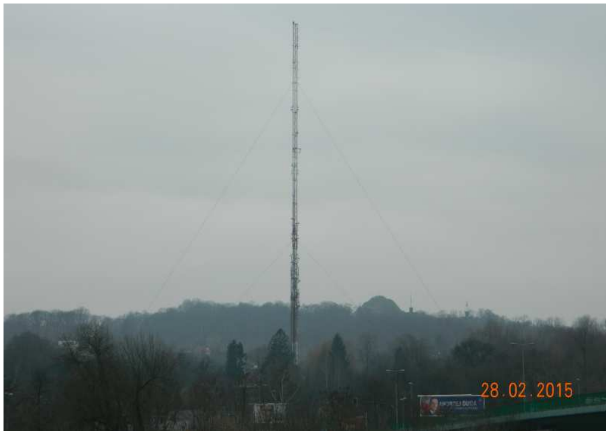
Fot. nr 60. Maszt radiostacji z ulicy Malczewskiego na tle Kopca Kościuszki.
