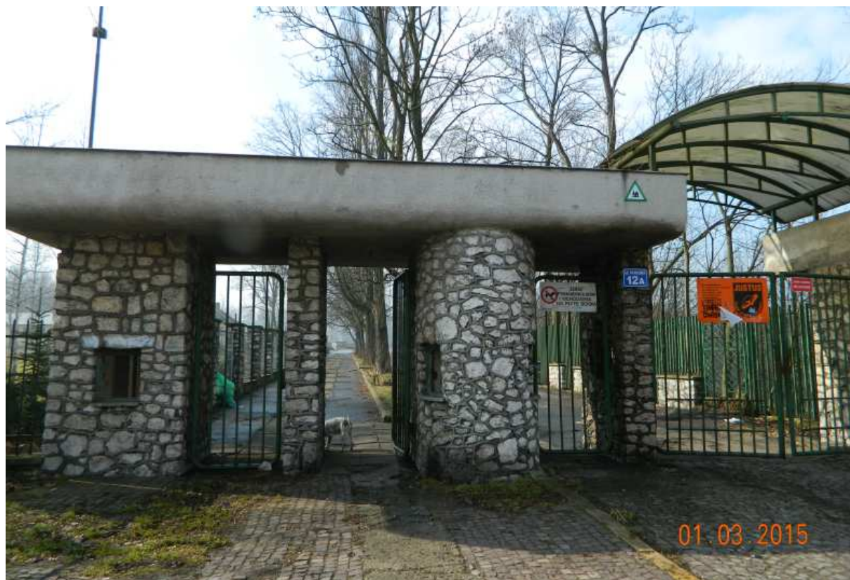
Fot. nr 250 (250-258). Systematycznie niszczący stadion Korony, który został oddany do użytku ledwie w 1961 roku. Wejście od strony ulicy Parkowej.
