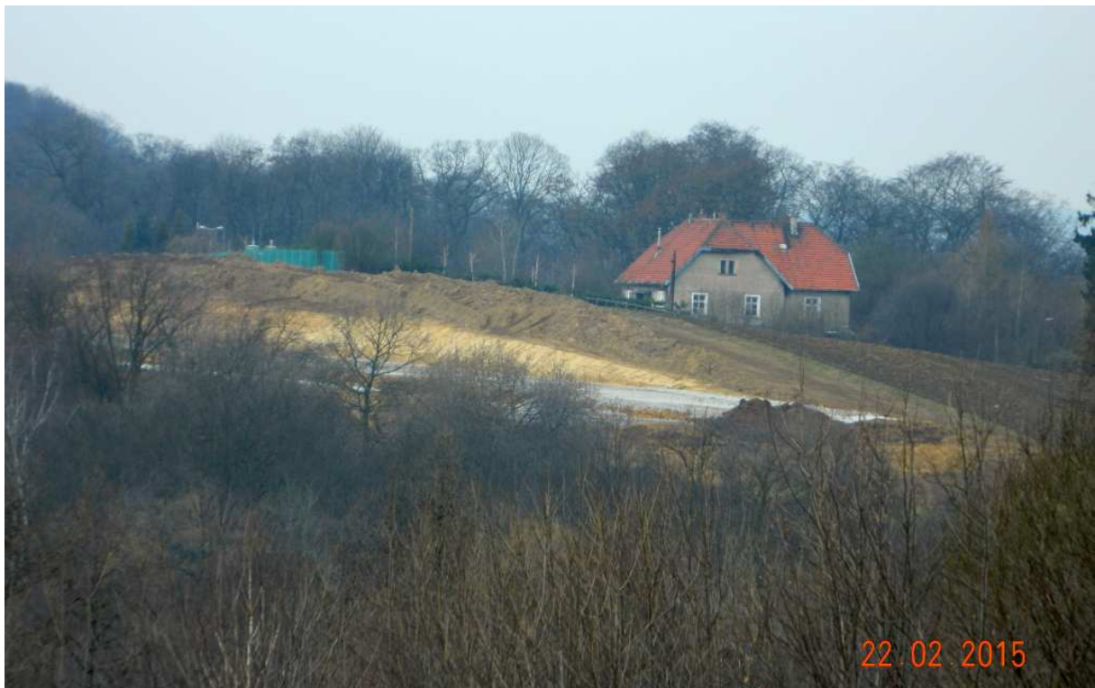
Fot. nr 111. Nieznane mi roboty budowlane na dawnych łąkach i polach uprawnych w bliskości ulicy Kukułczej.
