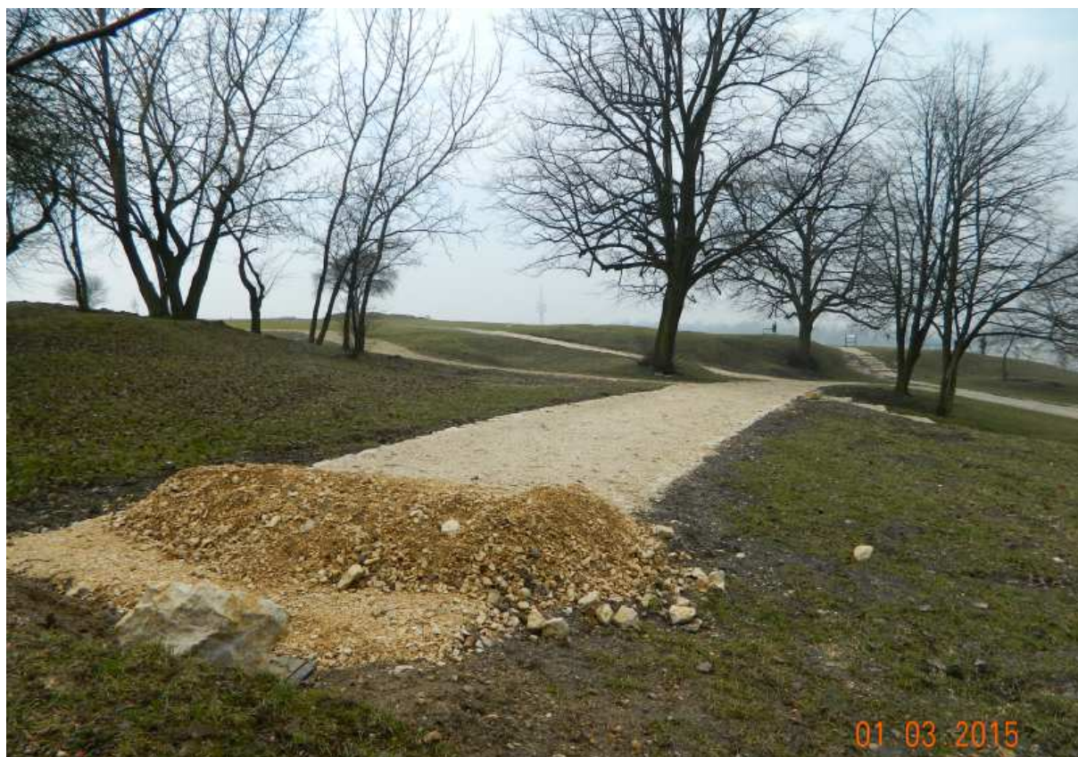
Fot. nr 242. Odtwarzanie narysu dawnej drogi fotecznej.
