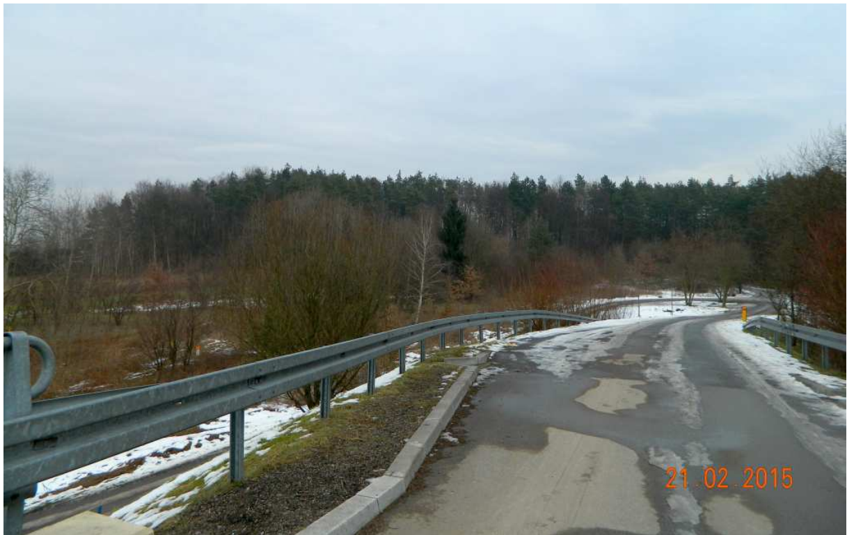
Fot. nr 164 (164-166). Mostek nad autostradą i roztaczające się z niego widoki.
